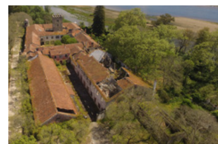
Fig. 134 – Primeiro núcleo de demolição
