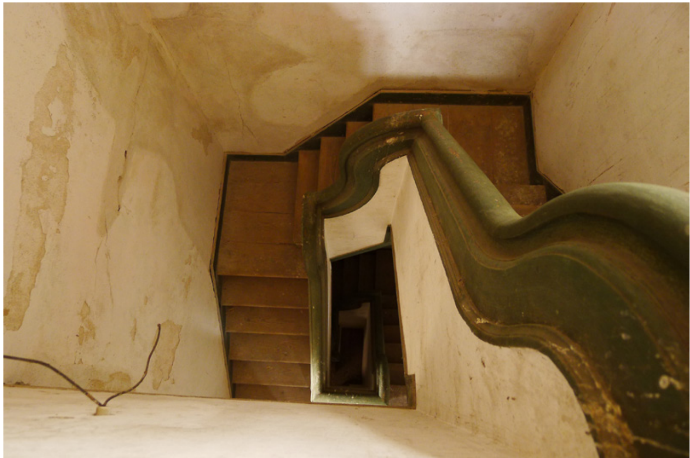
101. | 102. primeiro piso da Torre 103. escada de acesso aos pisos mais recentes
