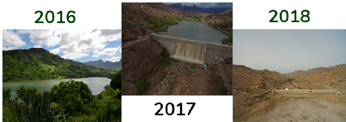
Figura 2 - Barragem do Poilão três anos subsequentes. Fonte: imagem captada através de drone por Ailton Soares
