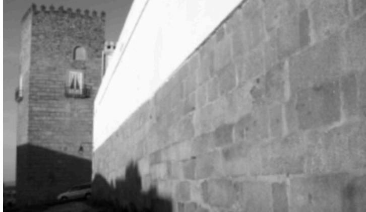
Figura 7 – Pano da antiga muralha (Rua do Menino Jesus). Aspeto do aparelho regular ( opus quadratum ) em alinhamento com a “Torre das Cinco Quinas”.
