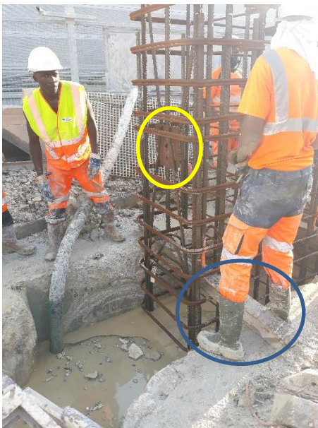
Figura 27 Círculo a amarelo corresponde ao encaixe entre o 1º módulo de armadura e o 2º módulo, através do fishplate. Círculo a azul que corresponde às alças de posicionamento que mantêm o 1º módulo de armadura suspenso para o encaixe do 2º módulo de armadura
