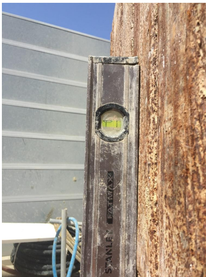
Figura 23 Junta colocada na vala com ligeira inclinação como se pode ver pela bolha do inclinómetro.
