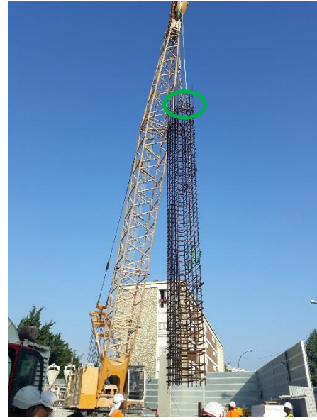
Figura 26 Elevação da armadura pelas alças de suspensão (indicado a verde).
