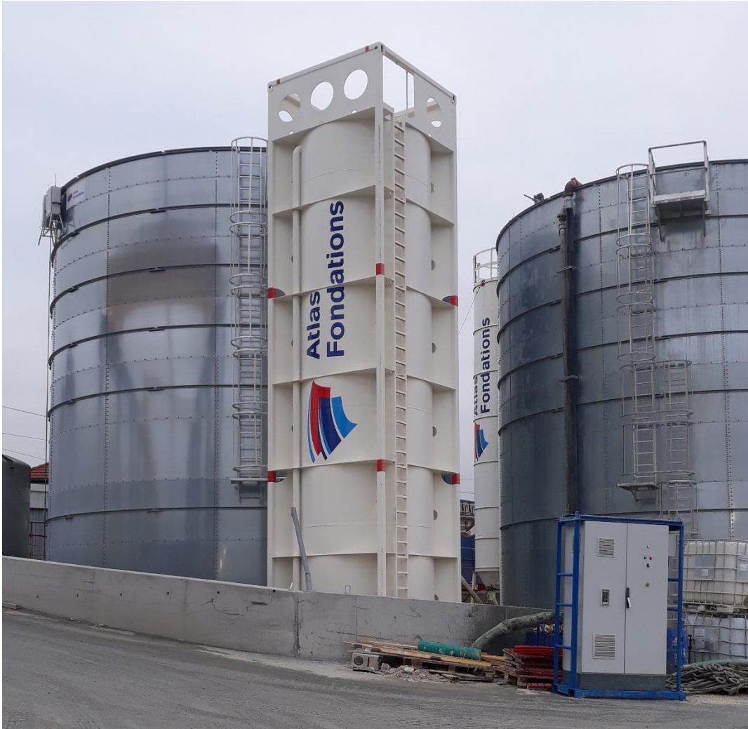
Figura 11 Zona de armazenamento e fabrico de lamas bentoníticas: 2 reservatórios a cinzento que armazenam a bentonite para escavação, 2 silos brancos que armazenam a argila para a produção de bentonite.
