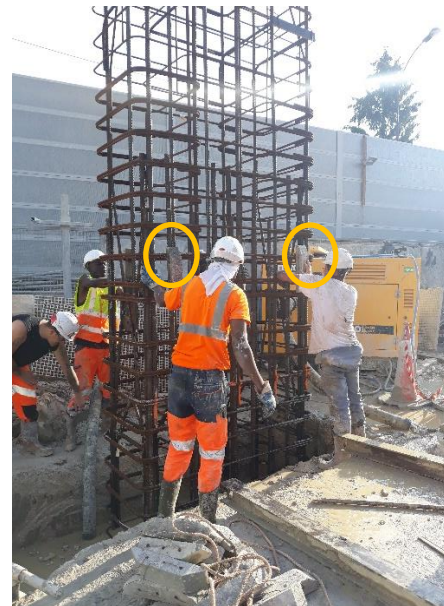
Figura 28 Círculos a laranja representam os espaçadores colocados na armadura
