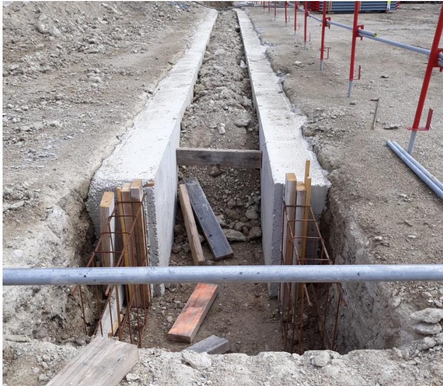
Figura 13 Execução de muros guia com parte da armadura visível e outra parte já betonada e preenchida de terra. Fonte: Atlas Foundations.
