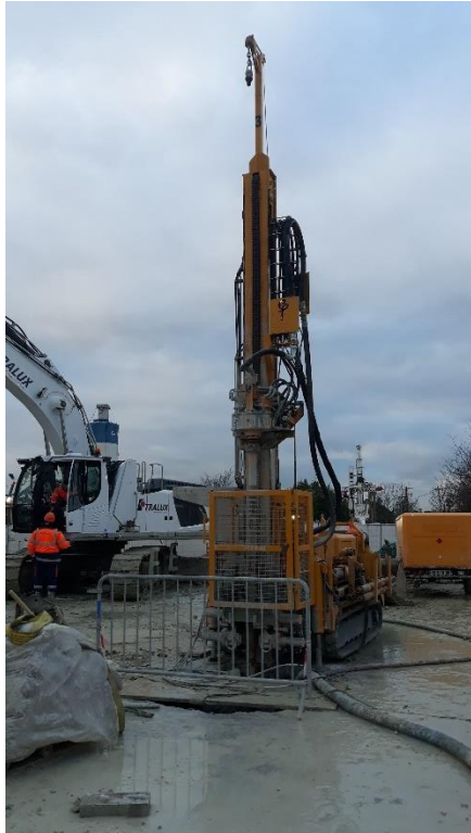
Figura 34 a) Perfuradora que efectuou a carotagem; b) caixa com os testemunhos da sondagem realizada.
