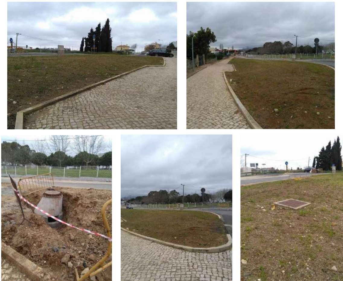
ILUSTRAÇÃO 66. Registos fotográficos da área de intervenção Fonte: Autora
