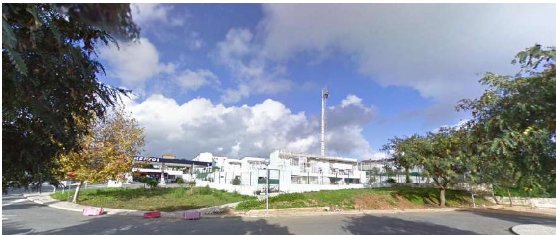
ILUSTRAÇÃO 74. Registos fotográficos da área de intervenção Fonte: Autora
