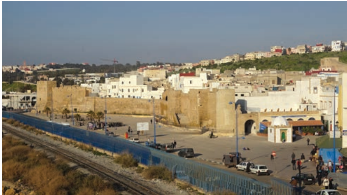
8. Railway line in front of the medina wall © João Rocha 8. Linha de caminho de ferro em frente à muralha da medina © João Rocha
