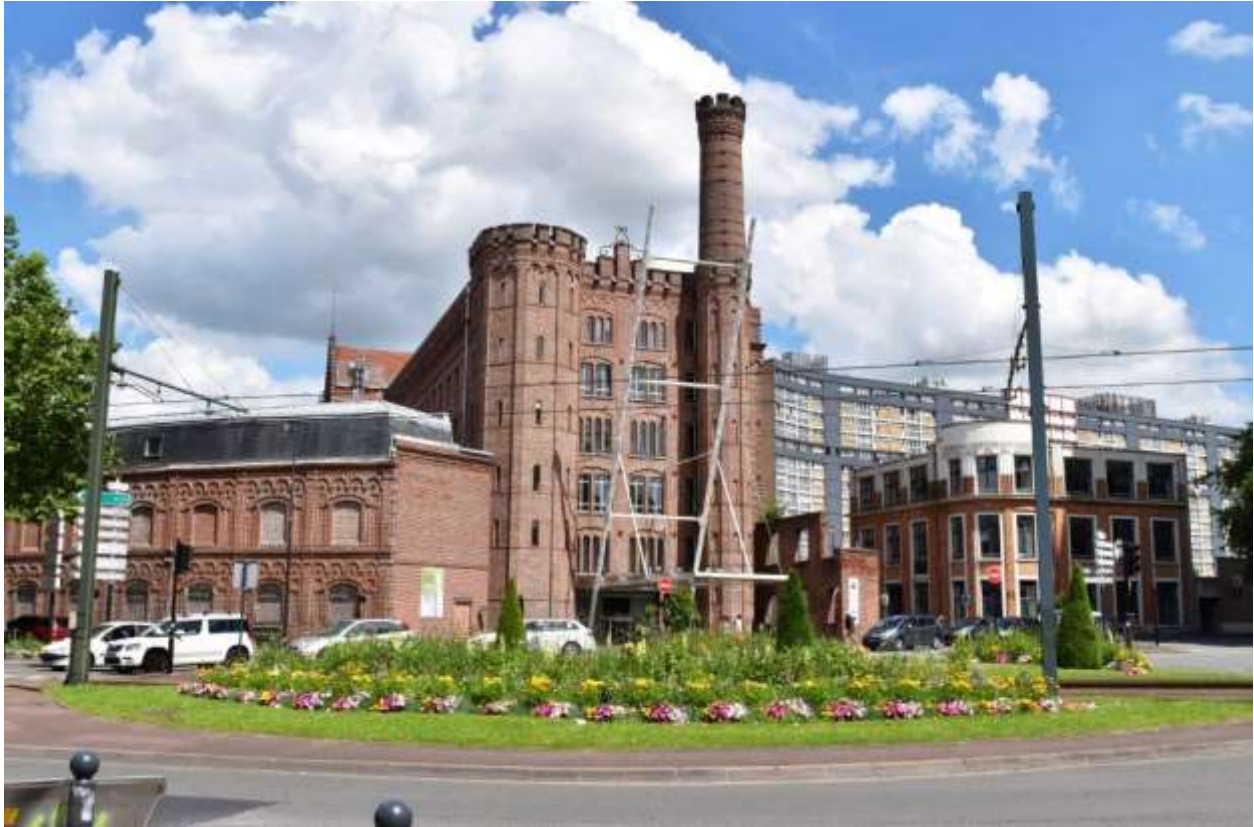
Centre national des archives du monde du travail à Roubaix
