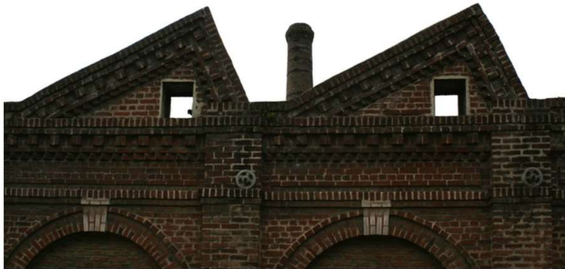
Ancien tissage de guipure et de tulle Archibald Josias Broad, puis Albert Sidoux et Cie (détruit) - Corniche et sheds des ateliers de tissage, rue Poëtte : seule la façade subsiste. A l'arrière plan, la cheminée de l'usine.
