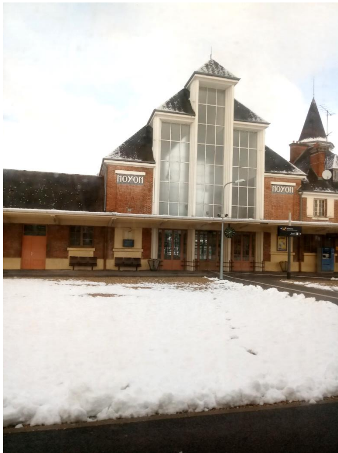
Figure 30: Exemple de gare périphérique, au nord de la France, Noyon
