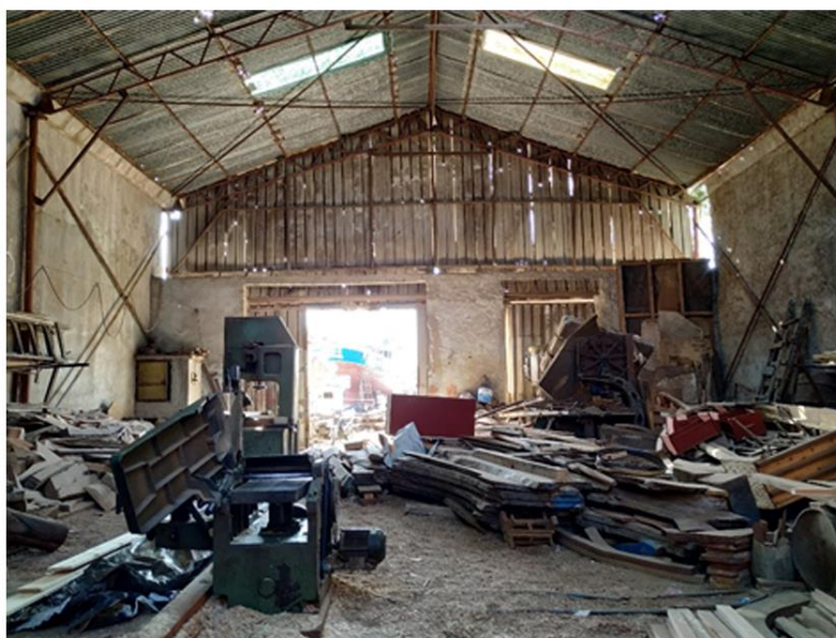
Annexe n° 3 – Chantier naval couvert, dans le port de la ville de Sfax.
