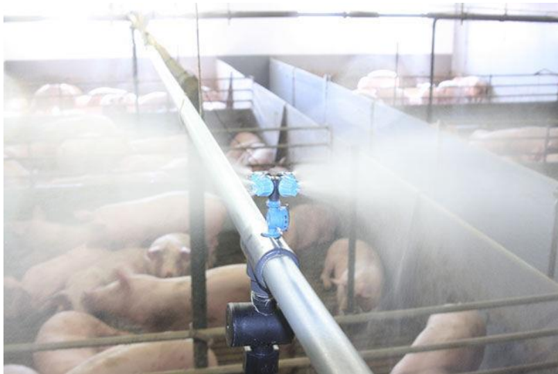
Figura 8 – Sistema nebulização (Fonte: http://www.agriexpo.online/pt/ )
