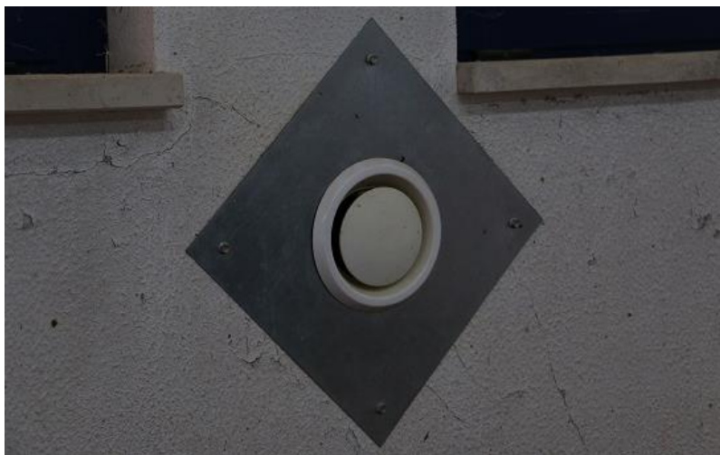
Figura 5 - Sistema de aquecimento por convecção através de gás (Fonte: Elaboração própria)
