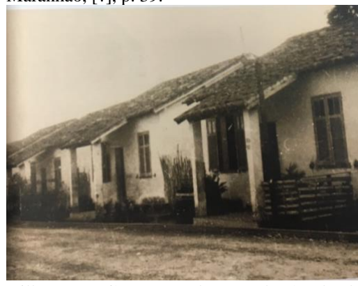
Village ouvrier pour les employés de la Estrada de Ferro São Luís-Teresina à Caxias.
