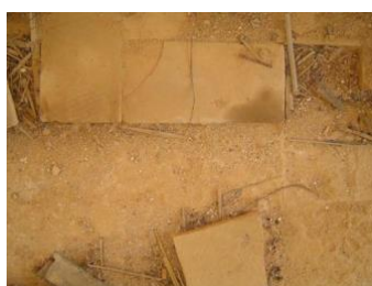
(b) pavage du sol
