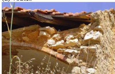
(d) support de la toiture en voute
