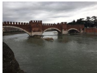
(c) pont d'accès
