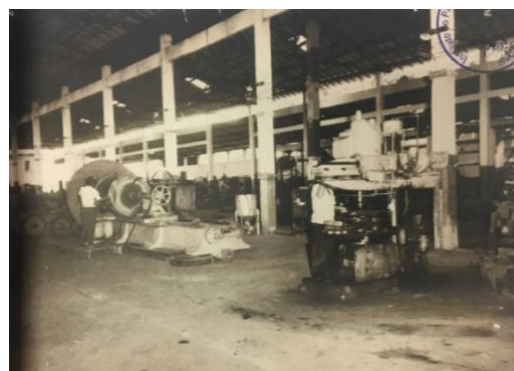
Oficine pour l'entretien des trains de la Estrada de Ferro São Luís-Teresina à São Luís.
