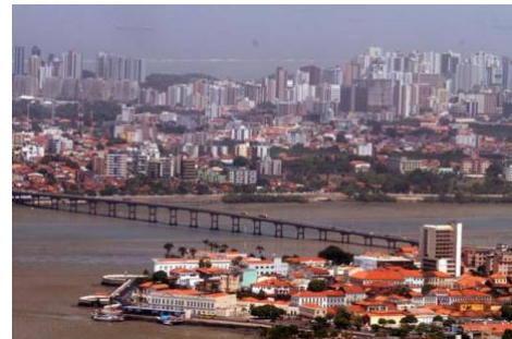
Figure XIV : Ponte do São Francisco sobre o Rio Anil. Em primeiro plano, vê-se o centro histórico de São Luís e ao fundo os novos bairros gerados após a expansão do tecido urbano antigo. Source : MOREIRA, Neidson. Disponível em: http://silviatereza.com.br/sao-luis-e-a-terceira-capital-mais-desenvolvida-do-nordeste . Accès en décembre de 2018.
