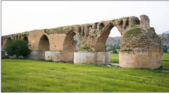
Fig. 12: Kashkan bridge, commons.wikimedia.org, 2016
