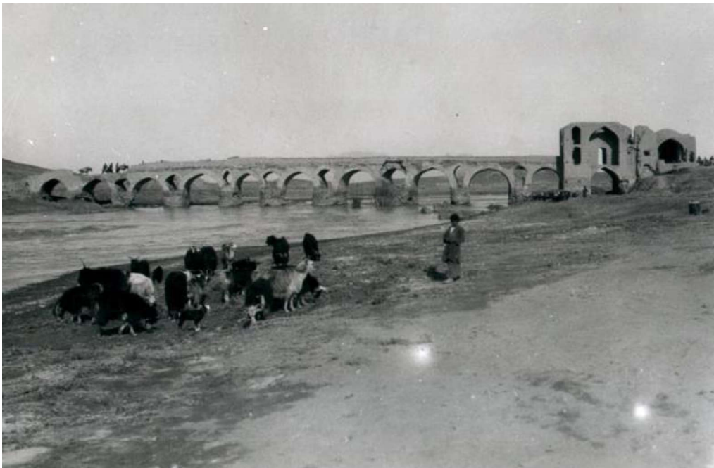
Fig. 41: Shahrestan bridge, 1933, www.archnet.net
