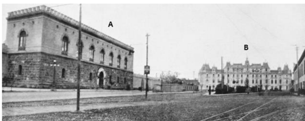
Image 33. (A) Le pénitencier de Lima, œuvre de Maximilien Mimey et Mariano Felipe Paz Soldán, inauguré en 1862 357 . (B) Le bâtiment Rímac, conçu par Ricardo Malachowski et finalisé en 1924 358 . Photographie des années 1920. Image consulté en juillet 2019, issue de https://edificiorimac.blogspot.com/
