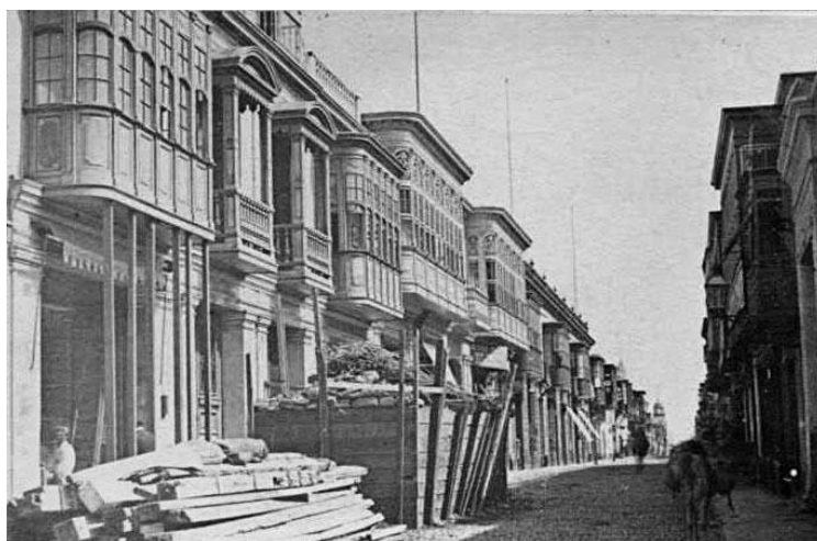
Image 5. Photographie de la rue Carabaya à Lima, autour de 1870. On observe la rénovation d'une maison avec des matériaux de construction de l'époque : du bois, de la terre, des pierres et de la paille. Image issue d'Internet, source expirée, consultée en 2012 32 .
