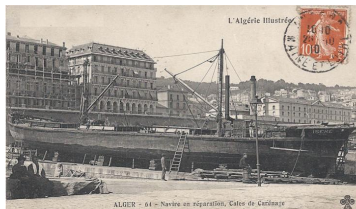
Figure 3.15: Navire en réparation, cales de carénage.
