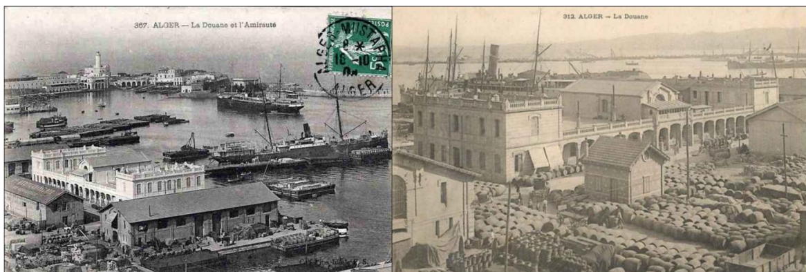
Figure 3.12: Douanes, façade coté ville
