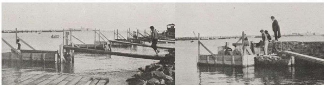
Figure 3.21 : Construction d'un tablier en ciment armé (îlot Al-Djefna) Source: Journal Général de l'Algérie numéro du 12 novembre 1908 due à Mr. Delarbre l'un des entrepreneurs des travaux.
