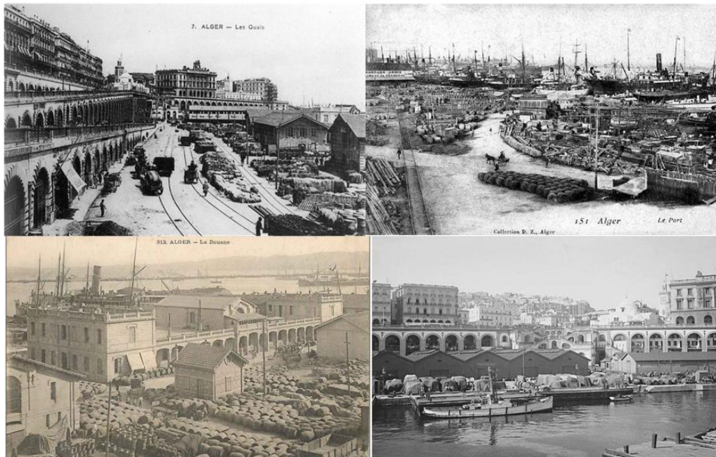
Figure 3.18 : Les quais, et le port chargés et encombrés.
