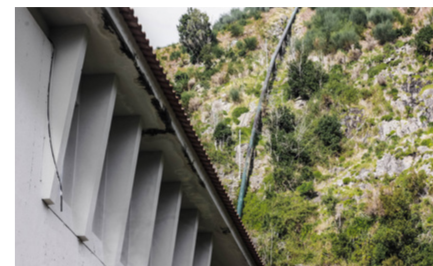
34 | Tubos de queda da central
