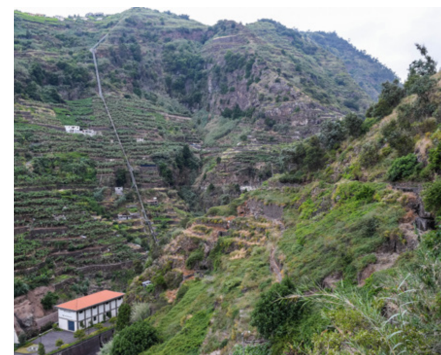
167 | Vista da levada sobre a central hidroelétrica dos Socorridos
