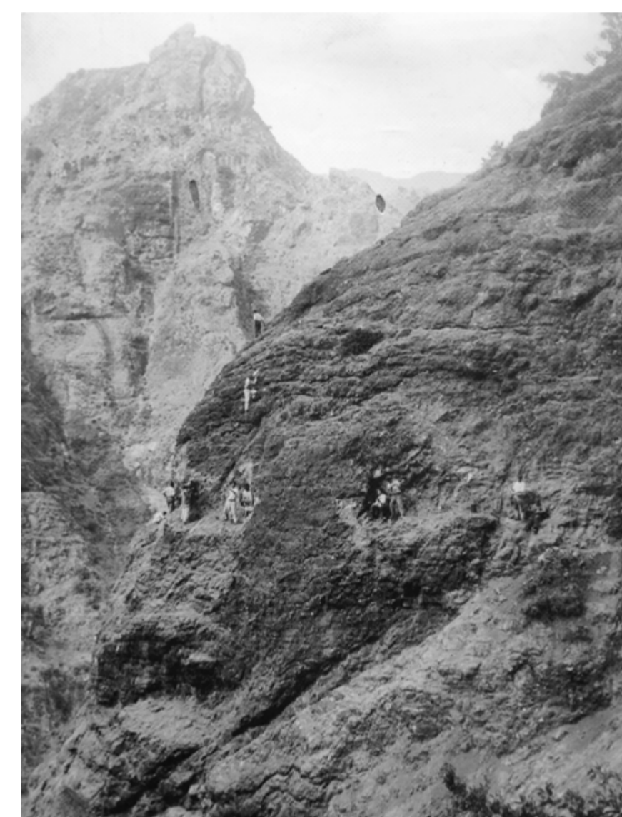
22 | Abertura do lanço sul da levada do norte, zona do Espigão
