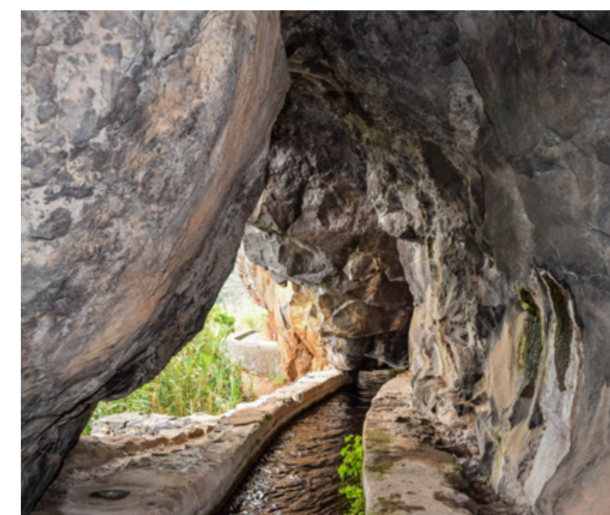
168 | Túnel da levada
