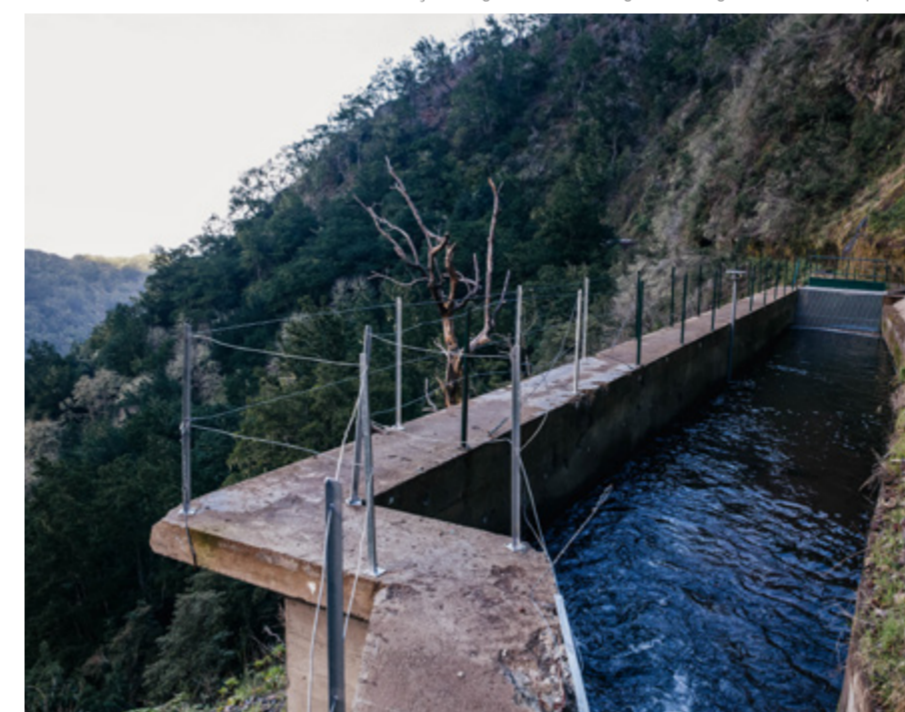
142 | Pequena câmara de carga da levada da Fajã da Nogueira
