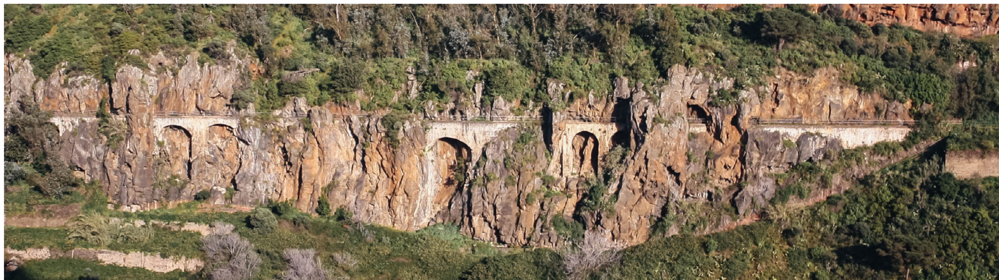
169 | Zona da levada em aqueduto
