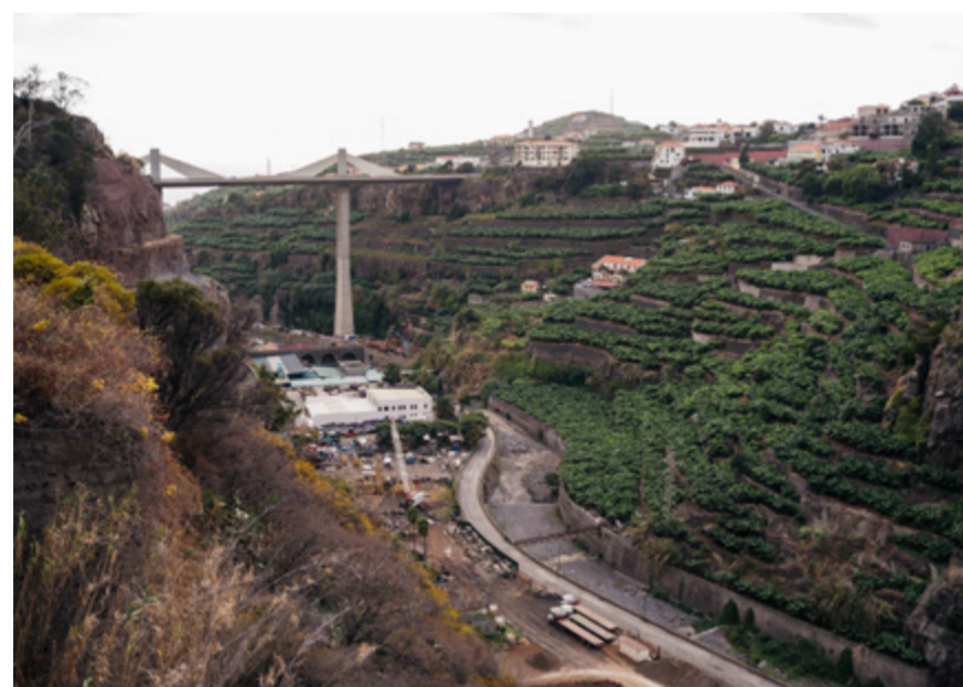
170 | Vista sobre o vale e ponte dos Socorridos
