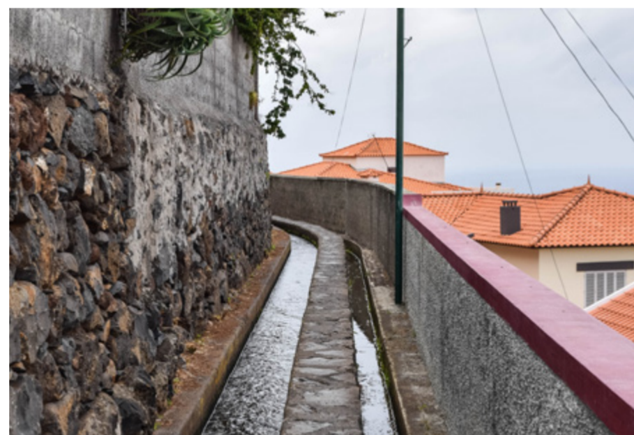
171 | Levada em zona urbana
