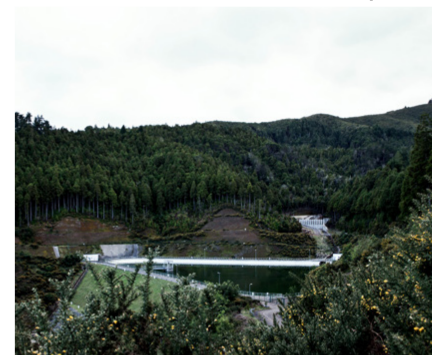
143 | Câmara de carga da levada do furado
