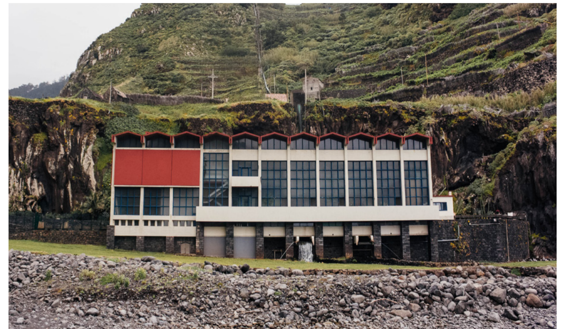
144 | Central Hidroelétrica da Hibeira da Janela
