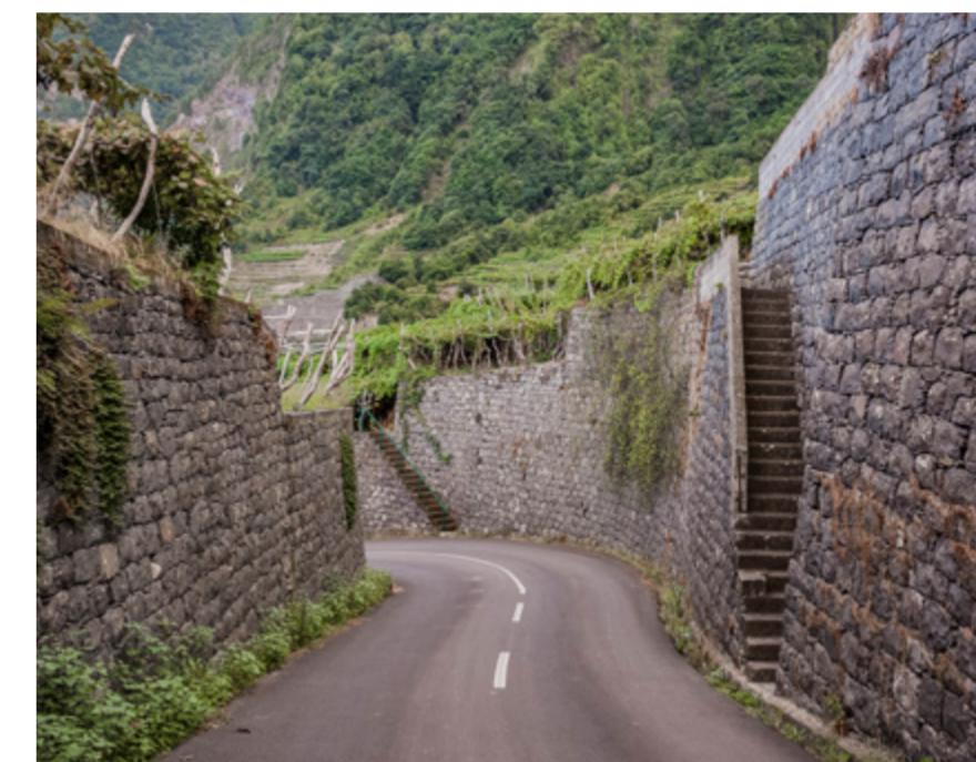
07 | Paredões em pedra
