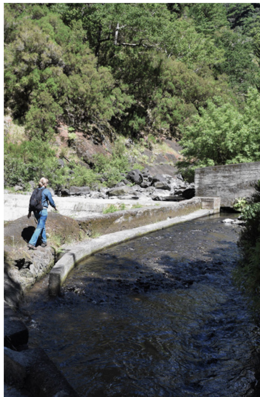
178 | Início da condução das águas para a levada
