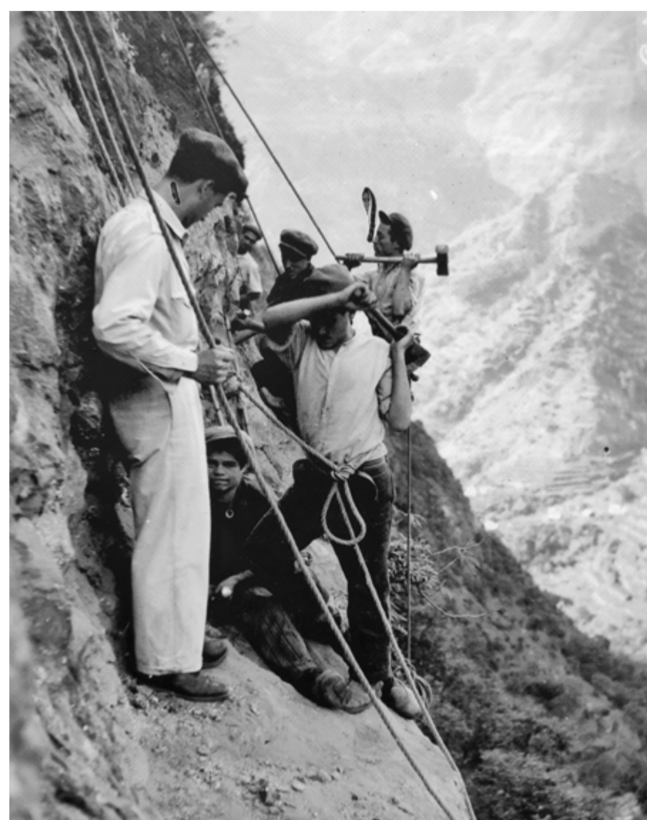
21 | Pormenor da abertura da esplanada da Levada nas encostas da Ribeira da Ameixeira, afluente da Ribeira Brava
