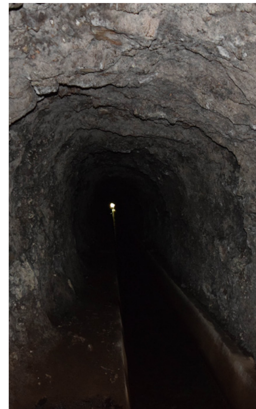
180 | Túnel de maior extensão da levada
