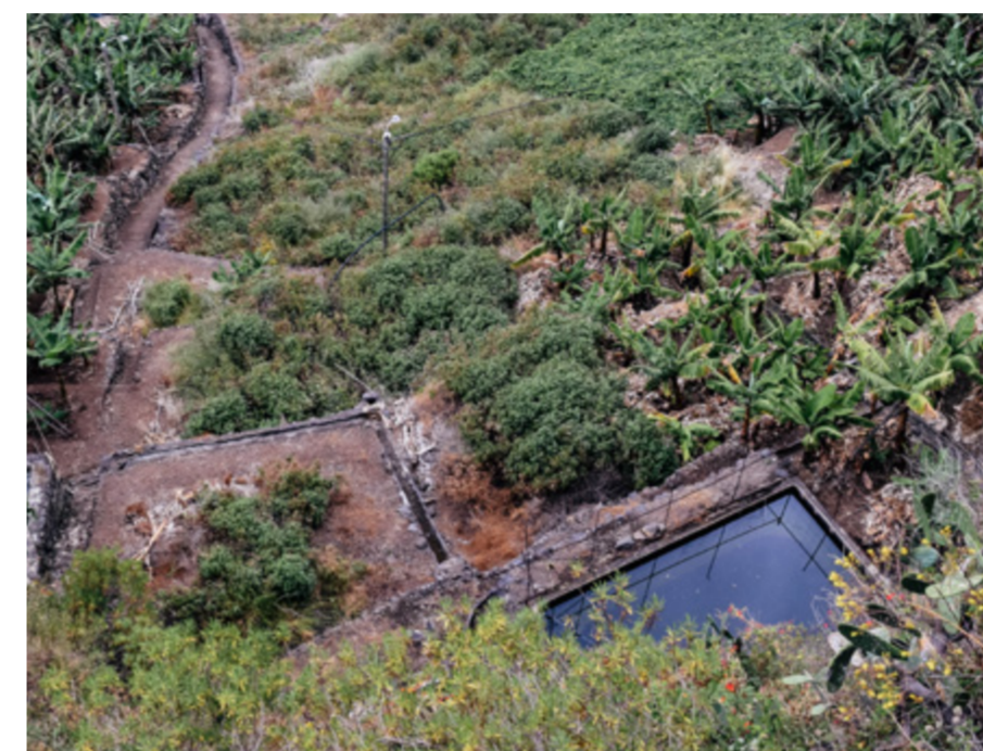
140 | Poços de água dos terrenos agrícolas marginais à levada dos piornais
