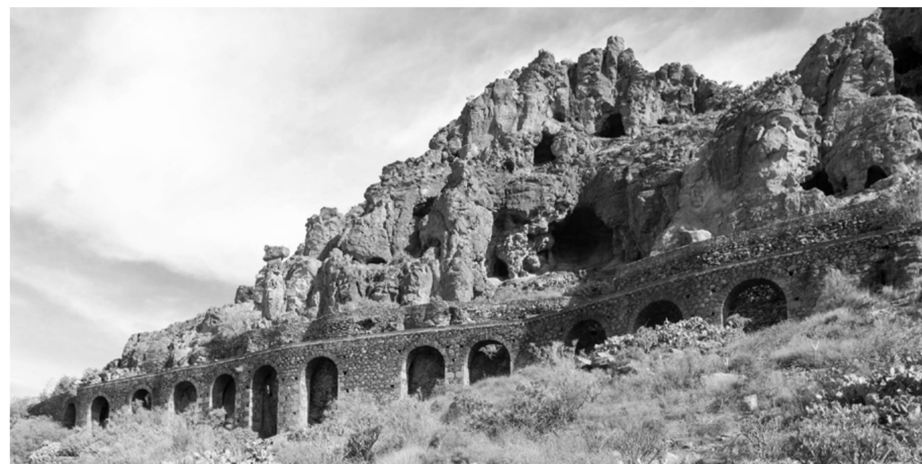
47 | Acequias em aqueduto
