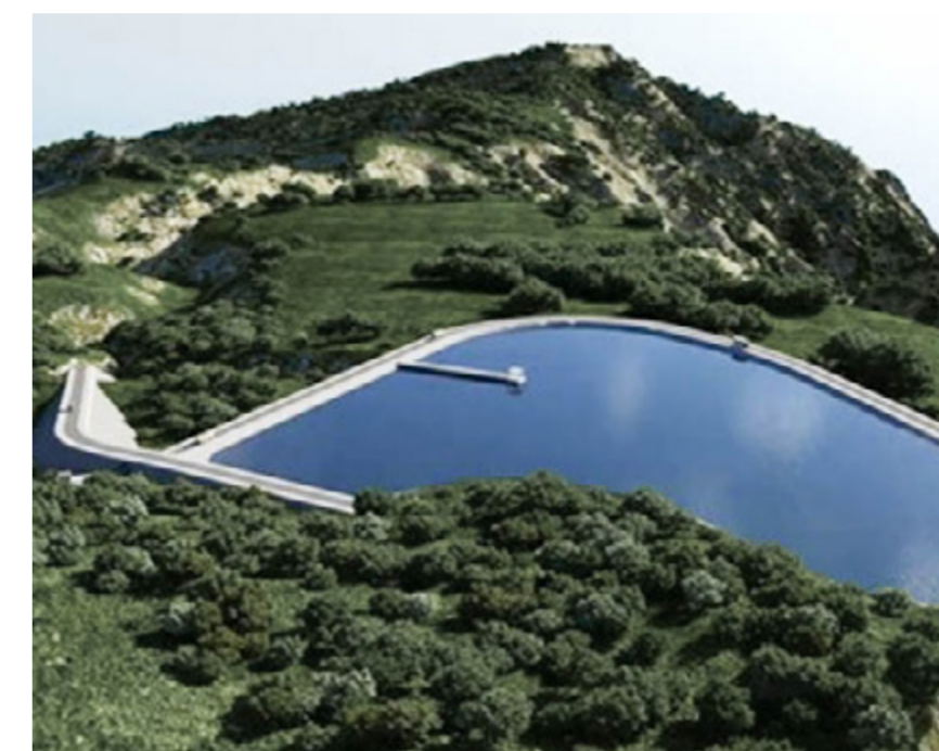
141 | Barragem do Pico da Urze
