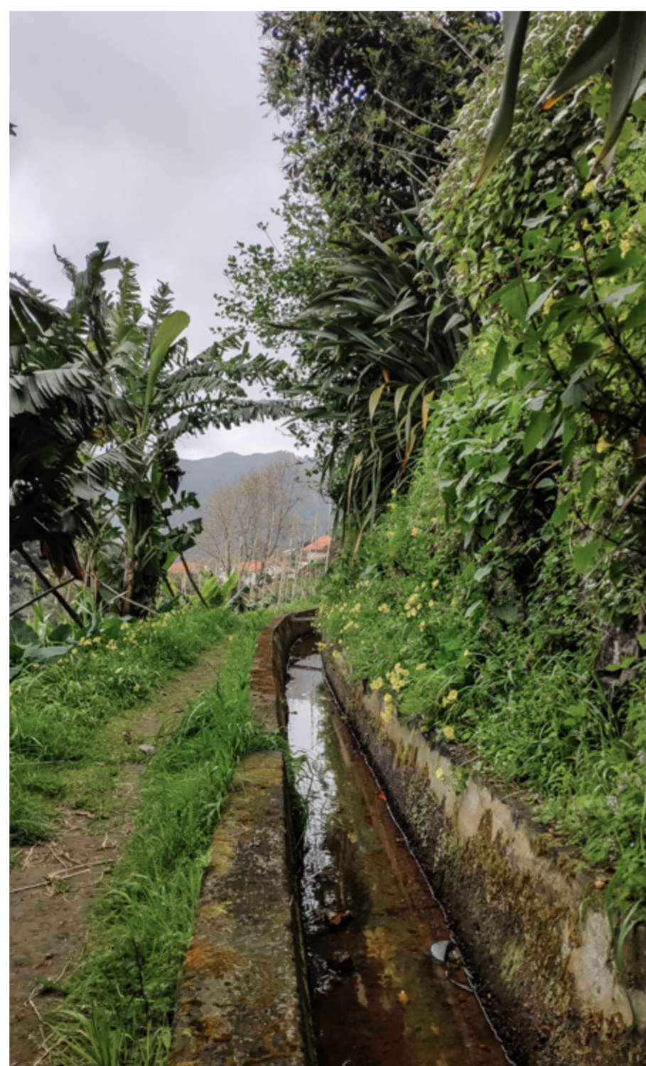
82 | Levada do Castelejo junto a área urbana 83 | Planta de localização da levada do Castelejo
