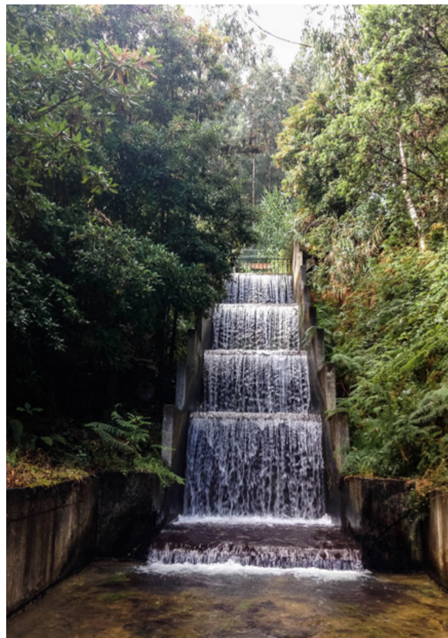
99 | Descida rápida das águas da galeria de captação de Fajã do Rodrigues
