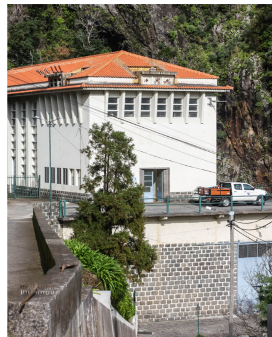
33 | Central hidroelétrica da Serra de Água
