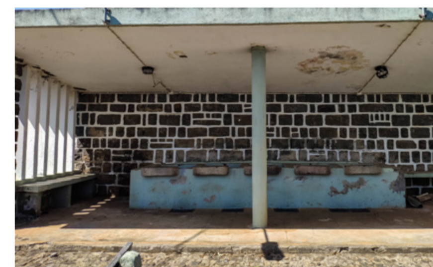
130 | Modernos lavadouros do sítio dos lavadouros, Água de Pena - Machico
