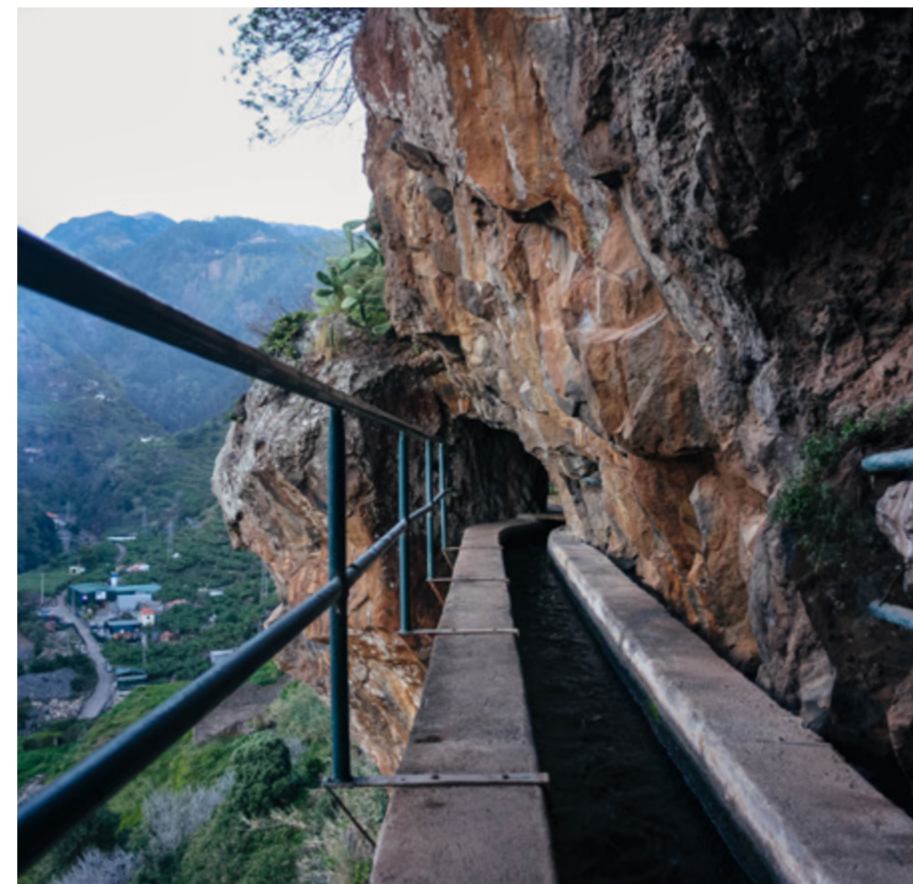
54 | Esplanada e canal da levada dos piornais
