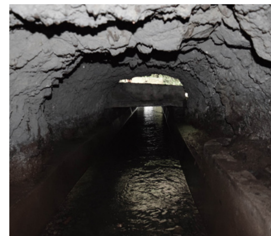
183 | Túnel da levada
