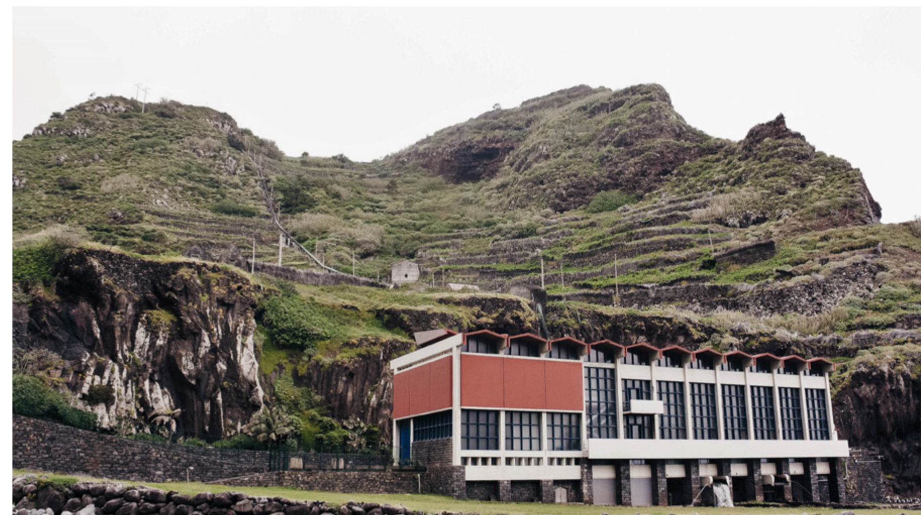
188 | Central hidroelétrica da Ribeira da Janela
