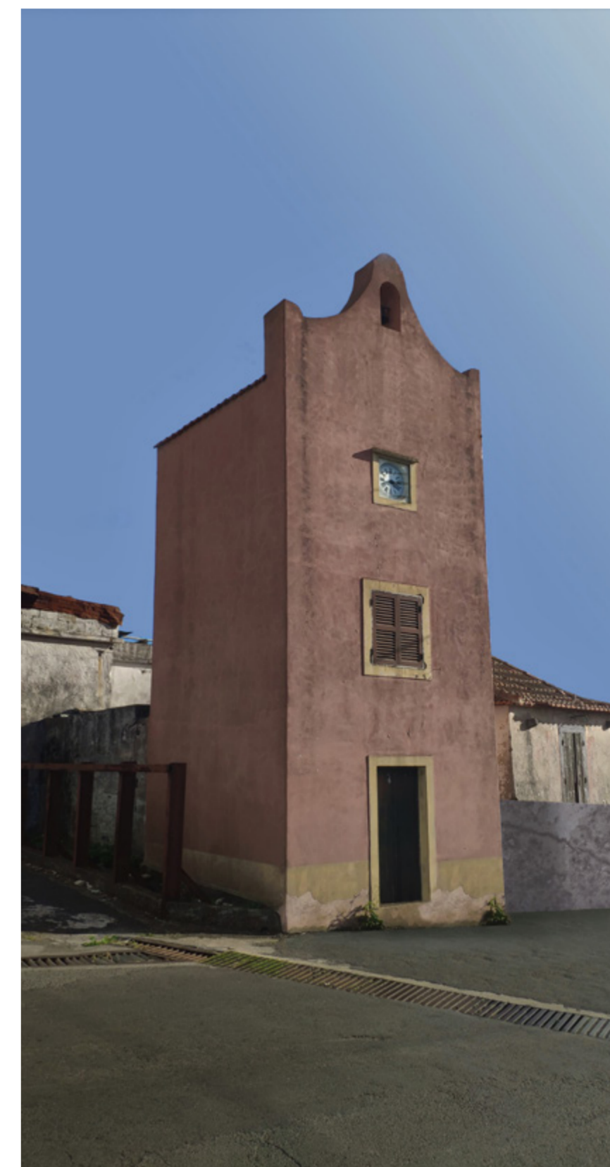
134 | Relógio de água da levada dos Canhas, Ponta do Sol
