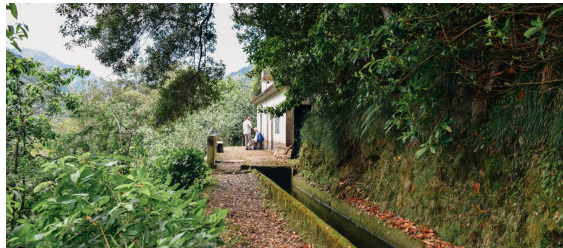
28 | Casa dos levadeiros, levada da Ribeira da Janela
