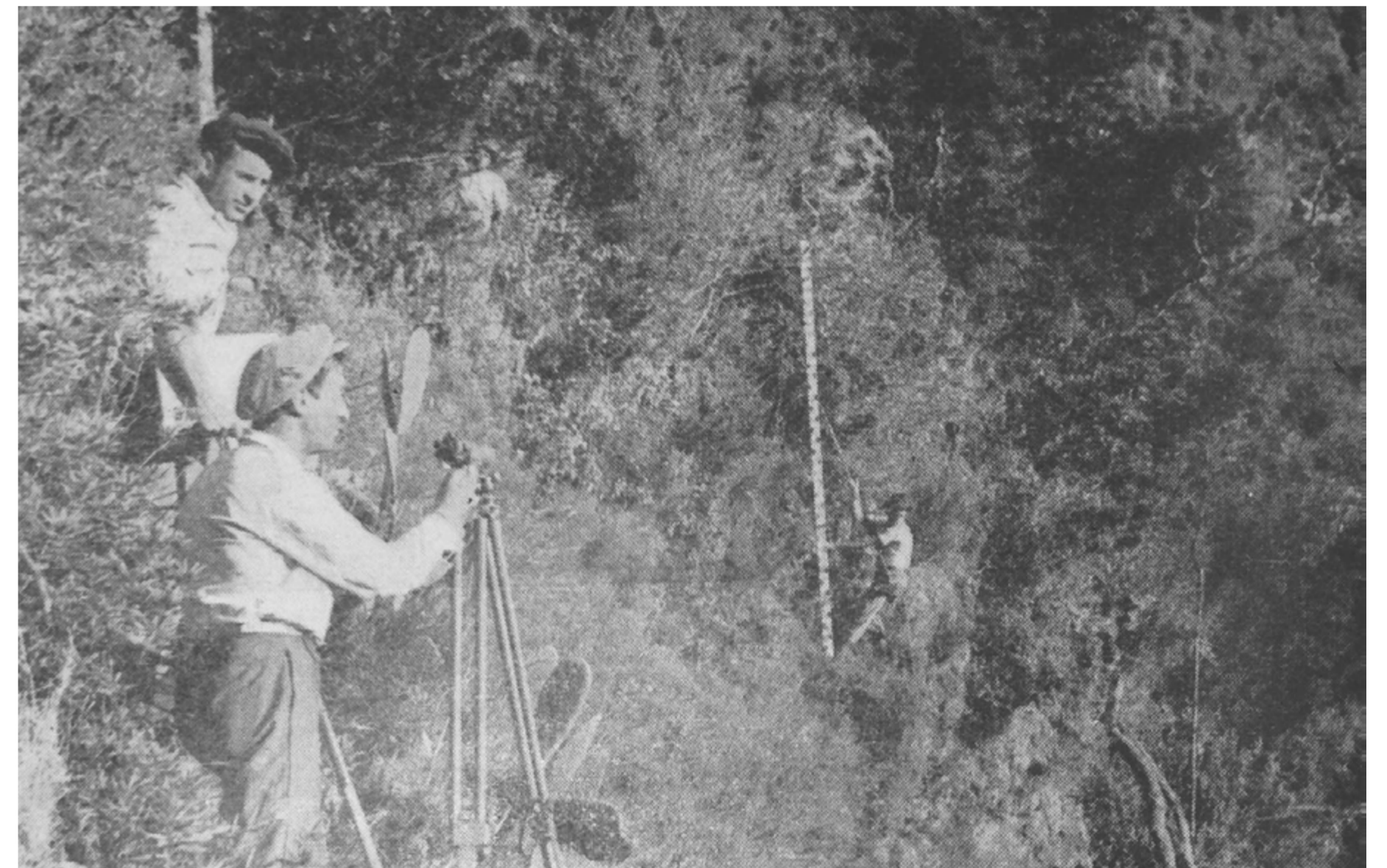
30 | Piquetagem da Levada na encosta da margem esquerda da Ribeira Brava
