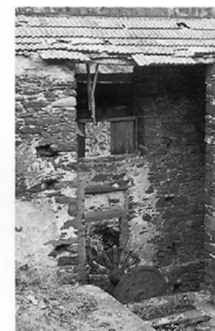
150 | Edifício do engenho de água em ruínas
