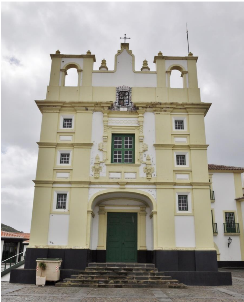
Figura 2 – Aspeto atual da fachada da ermida de Nossa Senhora dos Remédios.
