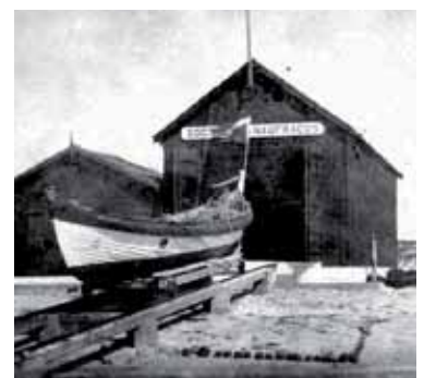
83. fonte: Da. Ana Luísa Mendes Segundo, anos 40 Antiga Estação de Socorros a Náufragos na ilha
