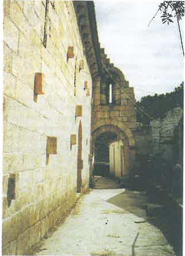
Ermelo: Fachada lateral da igreja e parte da estrutura conventual
