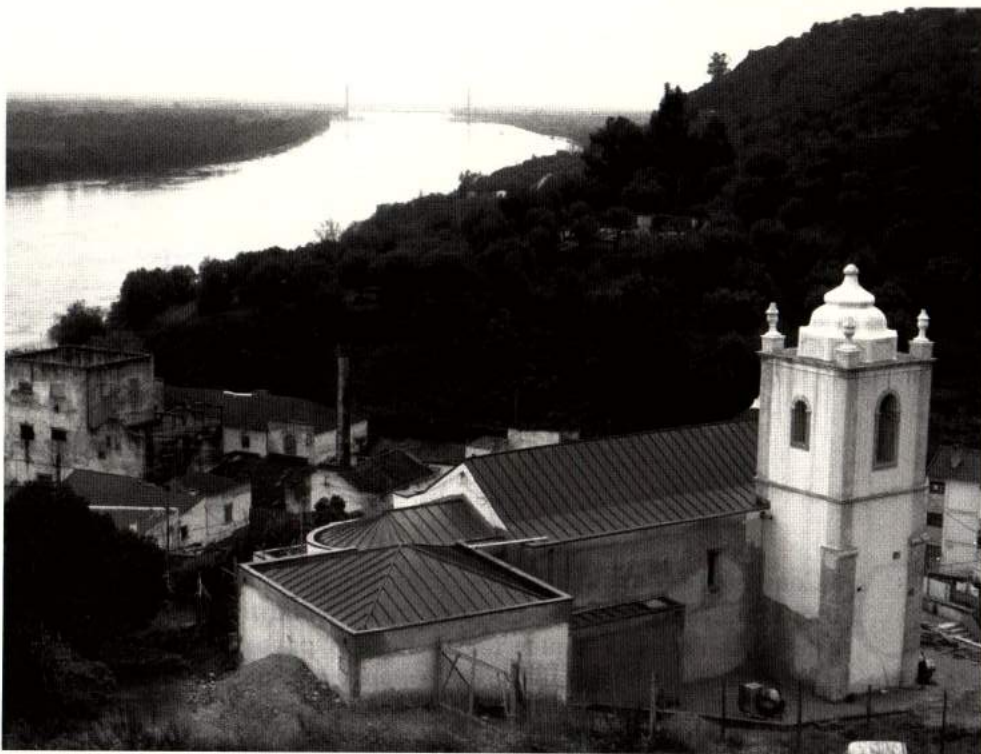
Igreja do Alfange, Santarém Reabilitação para reinstalação do culto (1996/2001, no âmbito da DGEMN).
