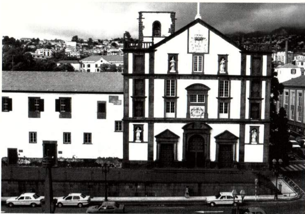
Colégio dos Jesuítas, Funchal Conservação e Restauro dos exteriores incluindo Torre sineira (1997/2000, no âmbito da DGEMN).
