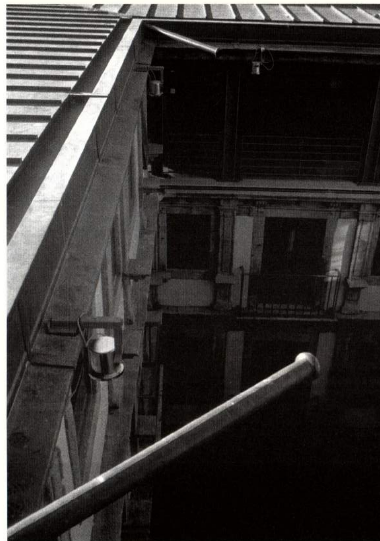
Edifício do Aljube, Antigo Convento de Santa Clara, Porto Reabilitação para aí instalar a Divisão Concentrada da P.S.P., Porto (1995/1999, no âmbito da DGEMN).
