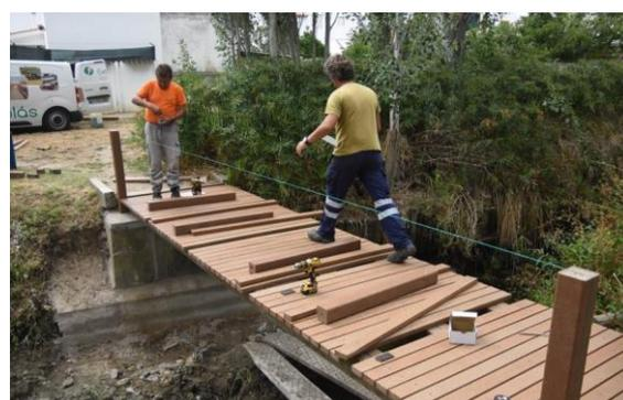
Figura 107: Execução de ponte pedonal em material reciclado da empresa Extruplas
