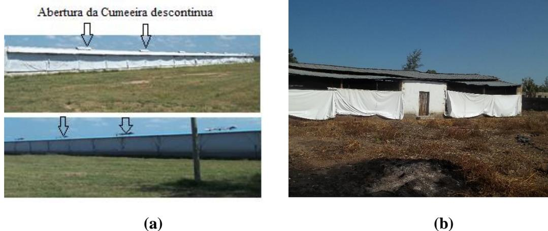
**Figura 7.** Abertura cumeeira descontínua (a) e contínua (b)
