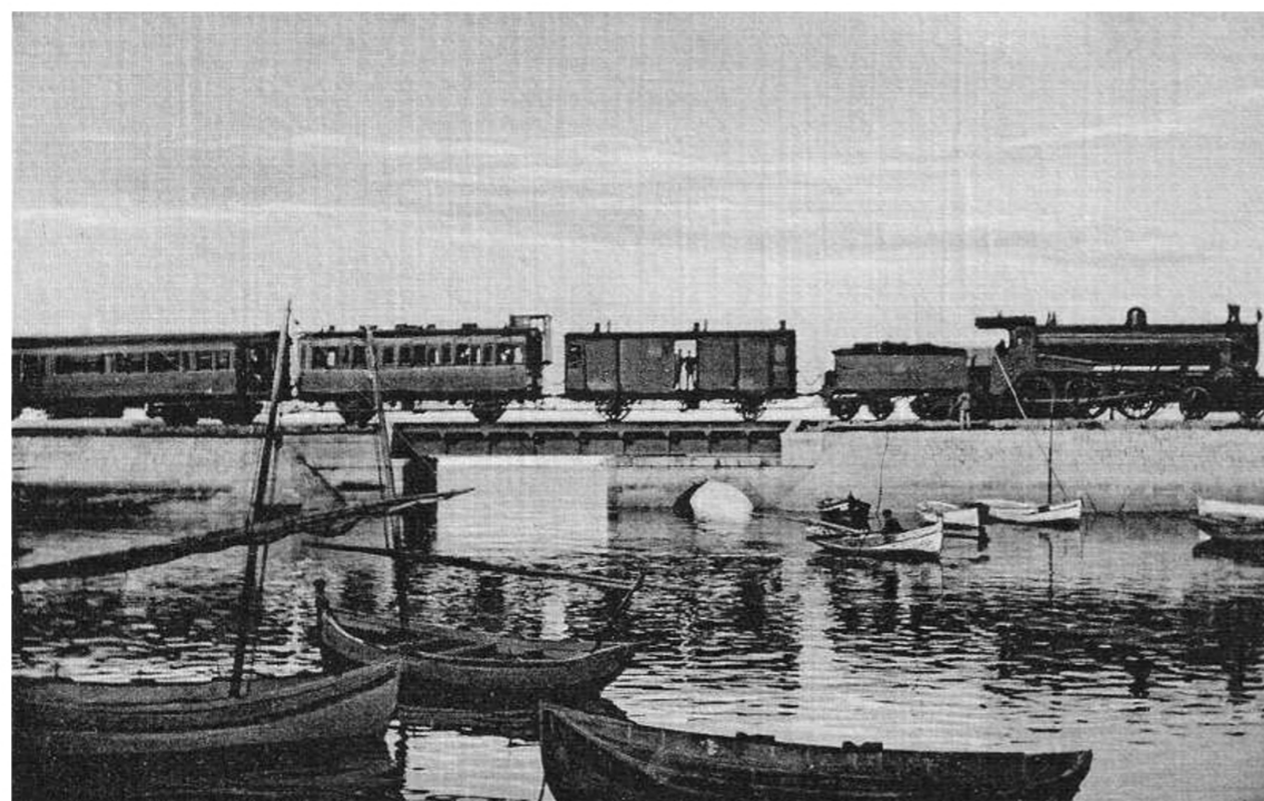
Fig. 1 Ponte do Caminho de Ferro em Faro
