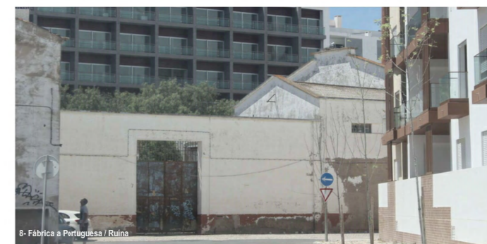
8- Fábrica a Portuguesa / Ruína
