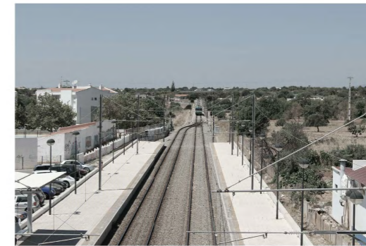
Fig. 19 Relação entre a Ferrovia e o Barrocal do Algarve
