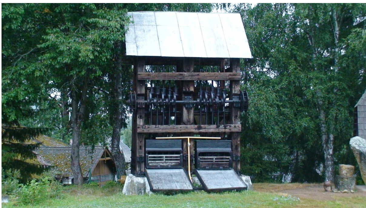
Foto 79 – Moinho de pilões de Época Moderna (Rosia Montana, Roménia)
