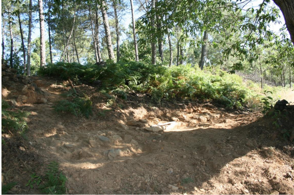
Foto 13 – Muros de sustentação do paredão da Cisterna (2010)
