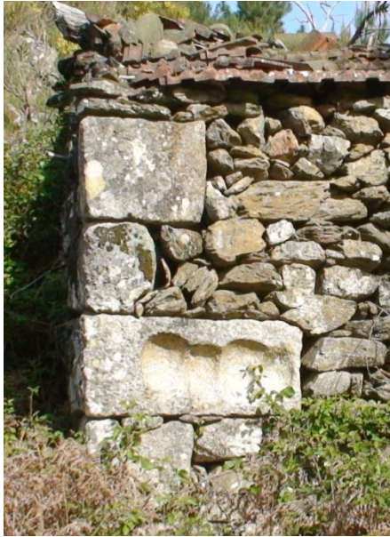
Foto 92 – Margem de fixação e movimento excêntrico, Moinho da Ribeira de Moinhos, Jales
