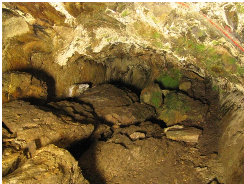
Foto 38 – Abatimentos interiores da Corta de Lagoinhos, Tresminas
