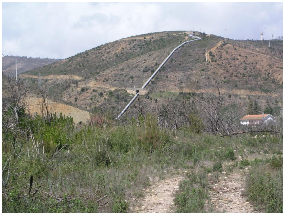
Foto 17 – Conduto de aceleração de central elétrica (Esteiro, Pampilhosa da Serra)
