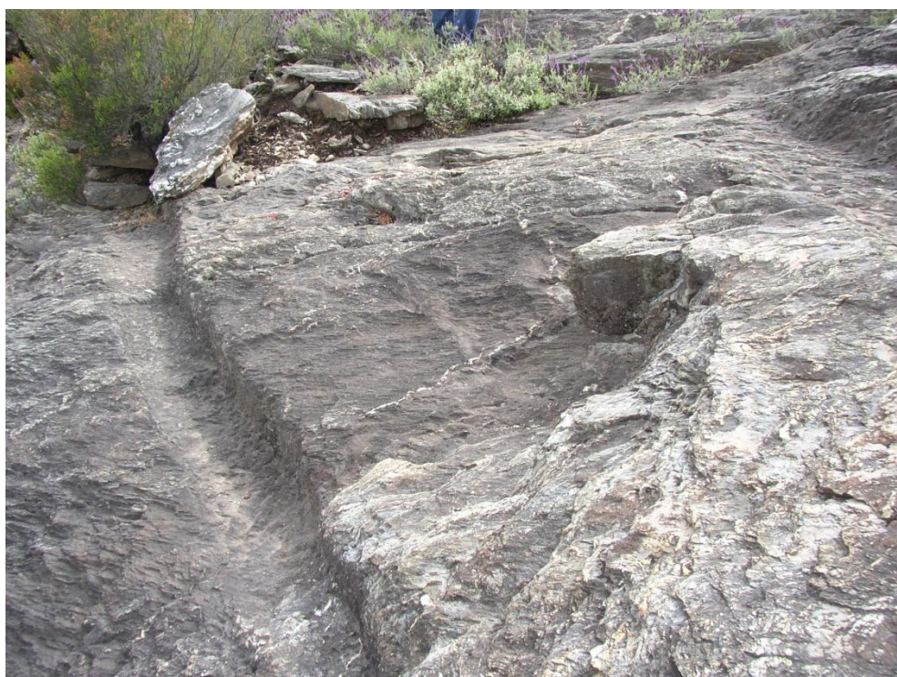
Foto 4 – Preparação da rocha para assentamento do Canal de Cevivas, Tresminas
