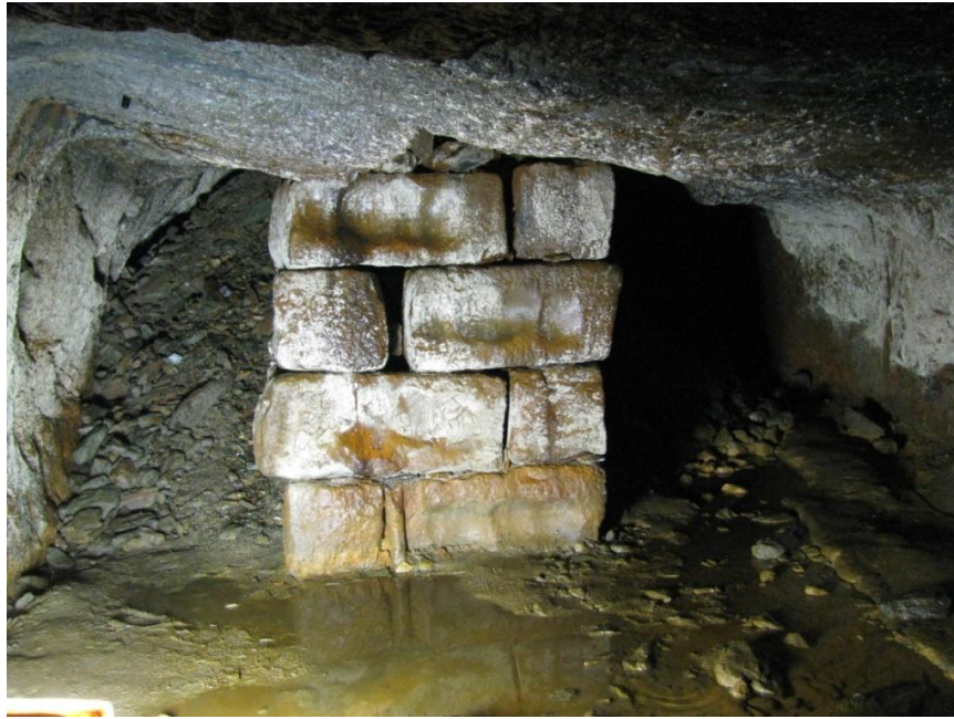
Foto 67 – Pilar da Galeria do Pilar, Corta de Covas, Tresminas
