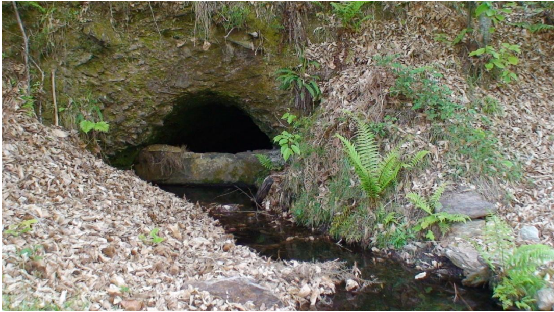
Foto 51 – Galeria do Buraco dos Santos, Galeria do Pilar, Tresminas
