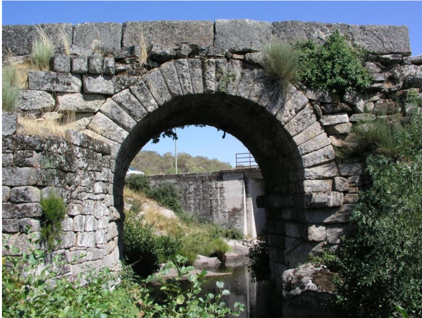
Foto 1 – Ponte do Arco (Barrela de Jales)
