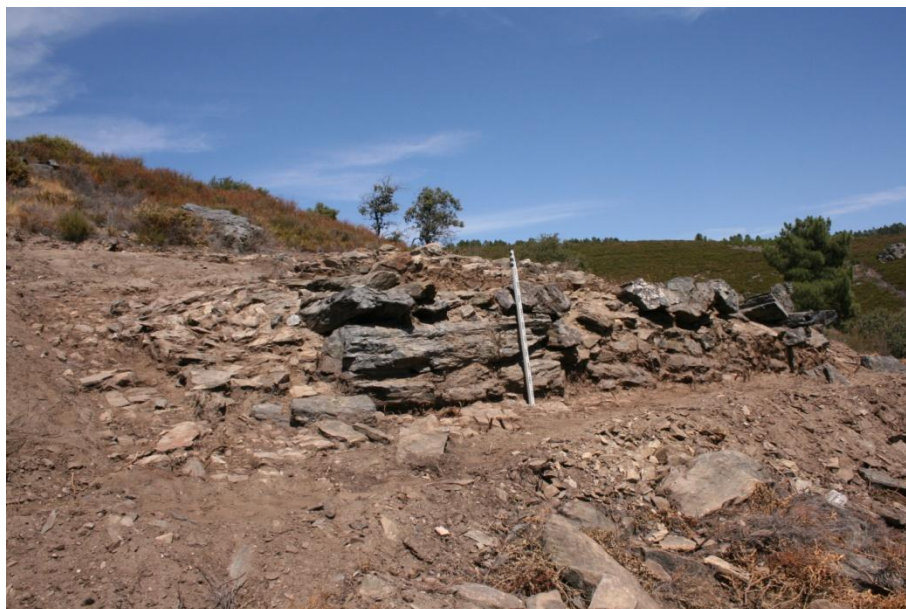
Foto 15 – Muros de sustentação do Aqueduto III (2008)
