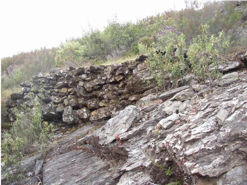
Foto 5 – Muro de sustentação do Canal de Cevivas, Tresminas
