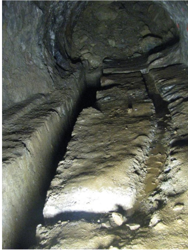
Foto 69 – Canaletes e término da Galeria do Pilar, Corta de Covas, Tresminas
