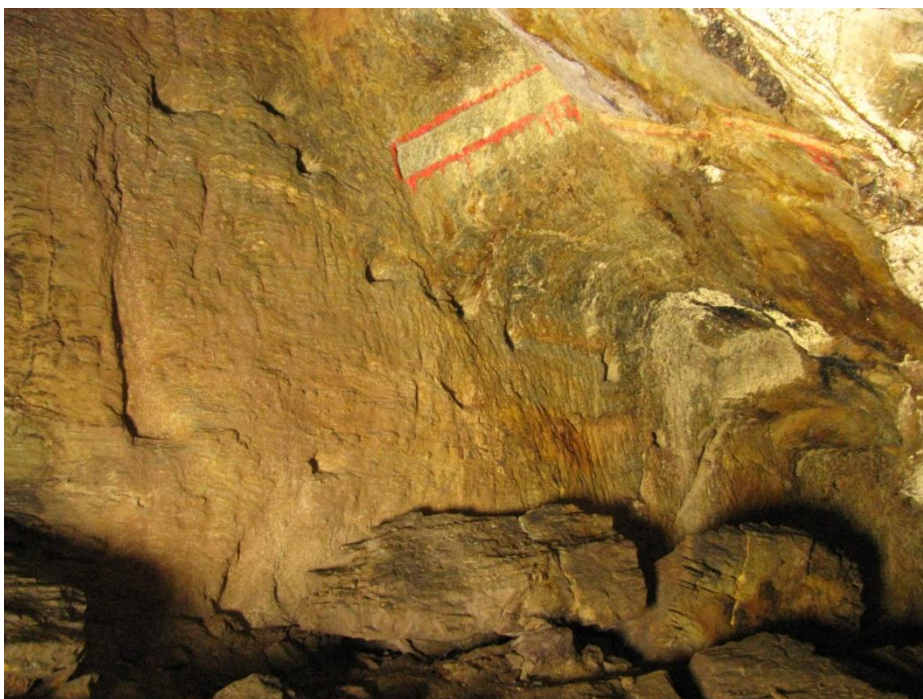
Foto 39 – Profusão de nichos de lucerna e marcas de travejamento na Corta de Lagoinhos, Tresminas
