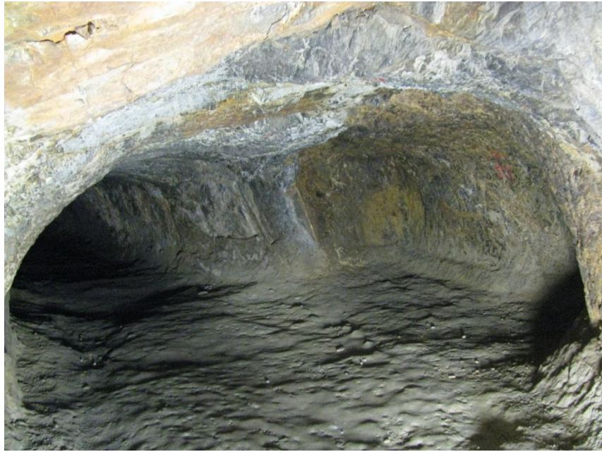
Foto 59 – Cruzamentos de carros, Galeria dos Alargamentos, Corta de Covas, Tresminas
