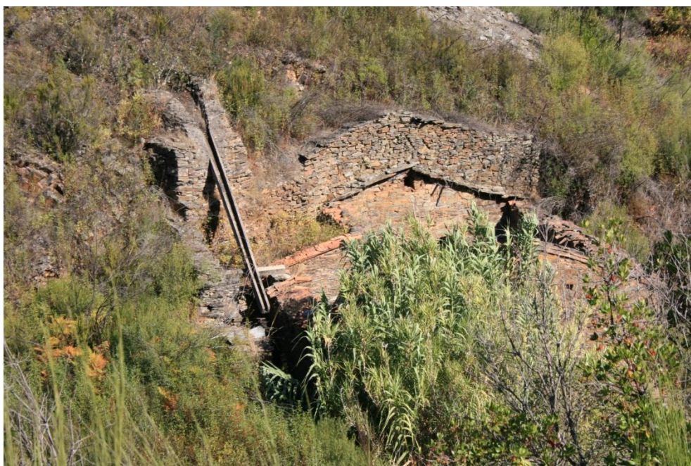
Foto 18 – Conduto de aceleração de água de moinho (Pampilhosa da Serra)
