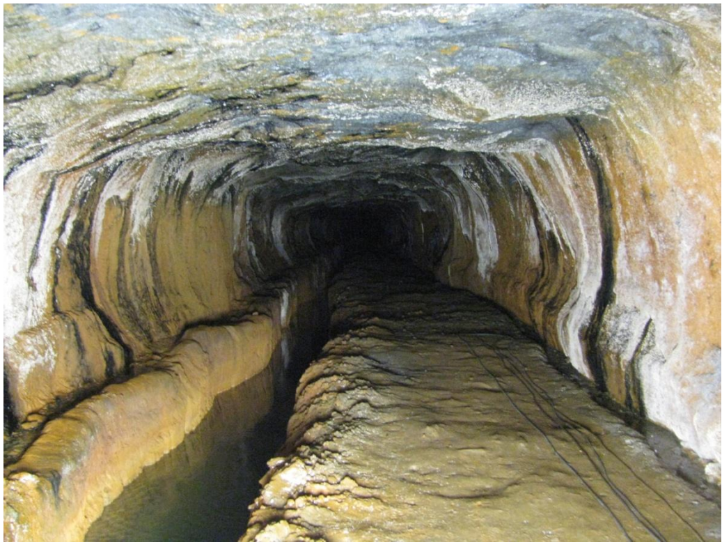
Foto 70 – Canal da Galeria do Pilar, Corta de Covas, Tresminas
