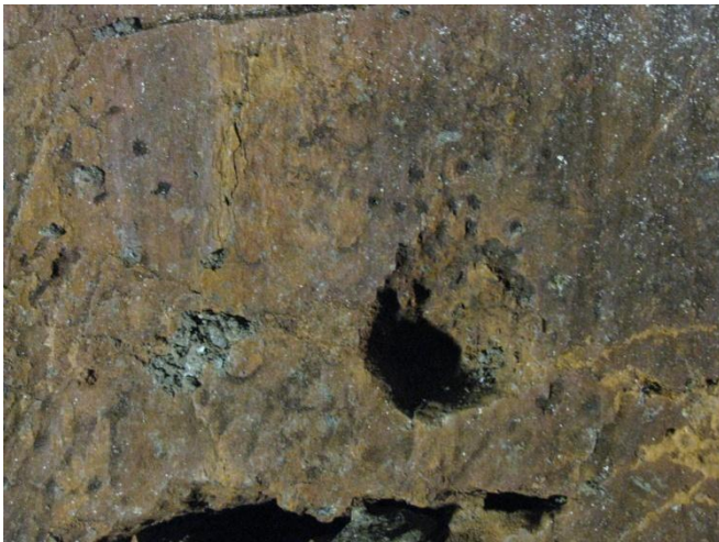
Foto 90 – Feitura de nicho na Galeria do Pilar, Corta de Covas, Tresminas
