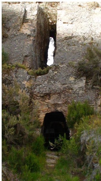
Foto 44 – Galerias Superior e Inferior da Galeria da Lavaria, Tresminas
