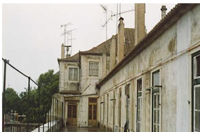
Figura 5 - Palácio Casa do Governador da Torre de Belém, Belém, Lisboa. Fachada Sul, Terraço. DGCP
