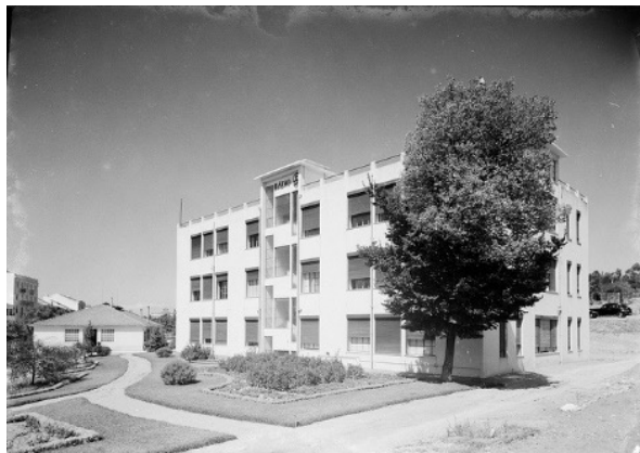
Figura 3 - Pavilhão do Rádio (1927-1933) - Carlos Ramos (1897-1969) ©Biblioteca de Arte da Fundação Calouste Gulbenkian – Mário Novais, 1936-37
