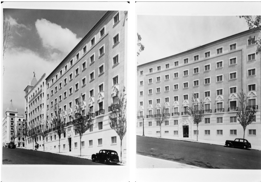
Figura 13 - Edifício de habitação Av. Sidónio Pais, nº12 (1942) - Cristino da Silva (1896-1976) © Biblioteca de Arte Fundação Calouste Gulbenkian
