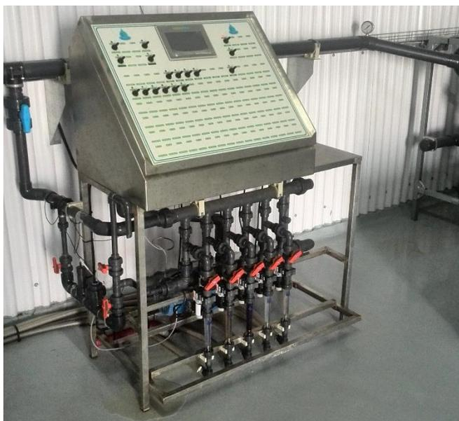
Figura 19 - Máquina de controlo de pH e CE da solução de entrada.
