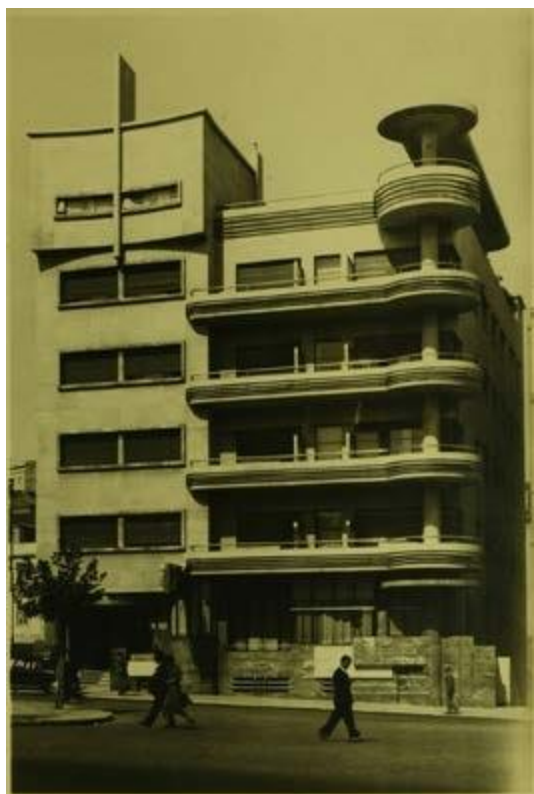
Figura 7 - AML - Autor não atribuído, [ Hotel Vitória: Fachada principal ], [1936], PT/AMLSB/CB/08/02/13.
