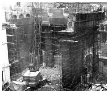
Figura 1 Demolição do arco da Euston Station, em 1962.
