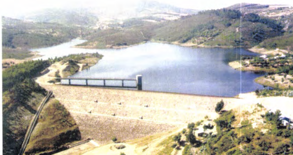
Figura 7.1 – Barragem da Apartadura ( http://cnpqb.inag.pt/gr_barragens/gbportugal )
