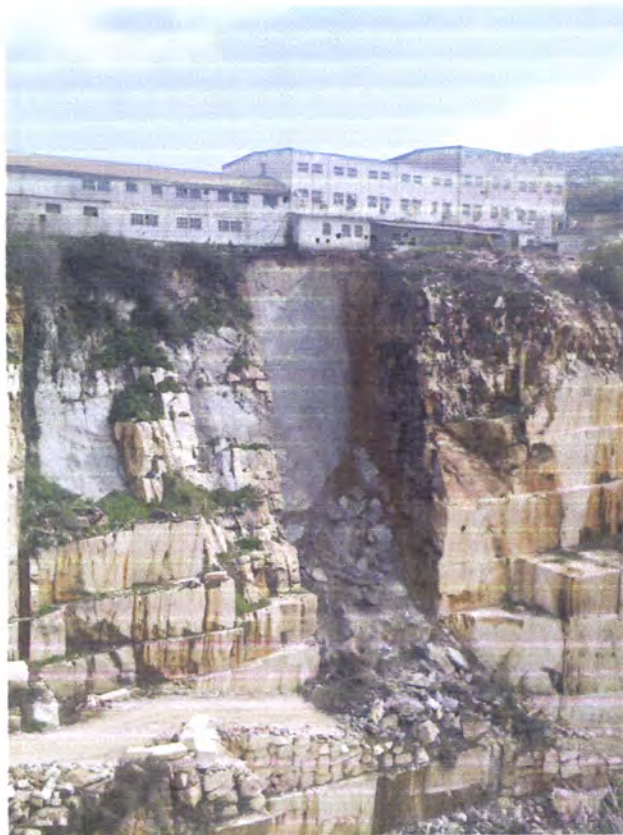
Figura 74. Deslizamento em pedreira de mármore com risco directo de desmoronamento da unidade industrial adjacente.
