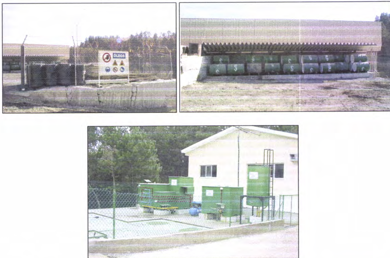
Figura 72. Correcto acondicionamento de óleos e separação de hidrocarbonetos numa pedreira.
