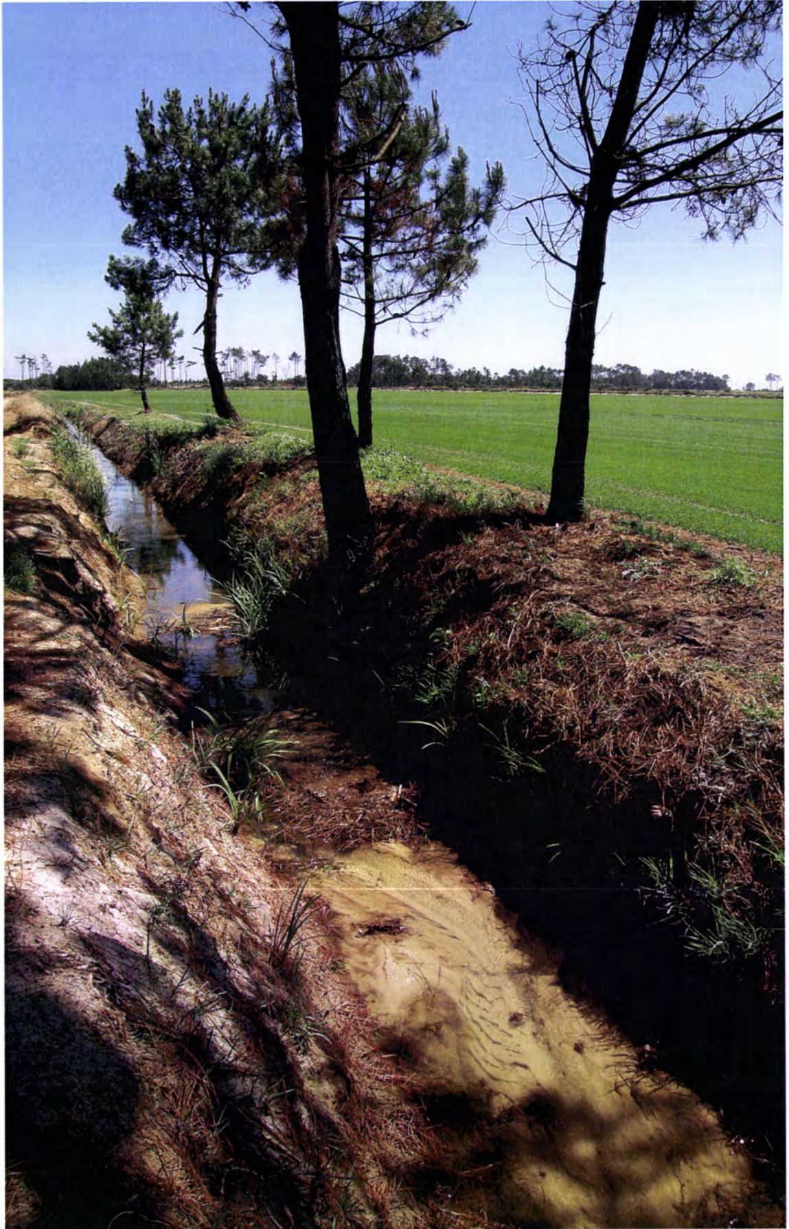
Figura 24. Nivelamento de terreno e valas de drenagem em parcelas onde existiram, no passado, charcos temporários.
