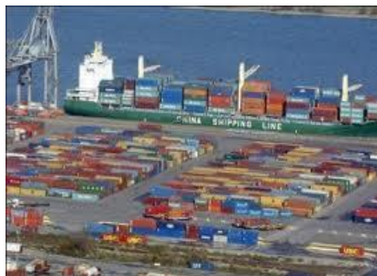
terminale à conteneur Port Marseille
