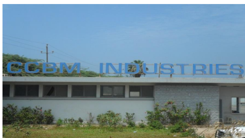
Usine de montage de voiture, ex usine Bata, Photo prise par Abdoulaye Gaye
