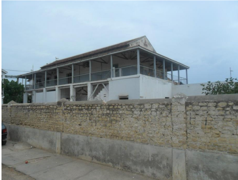
Ancien bâtiment colonial, devenu siège de la Mairie de Rufisque Est
