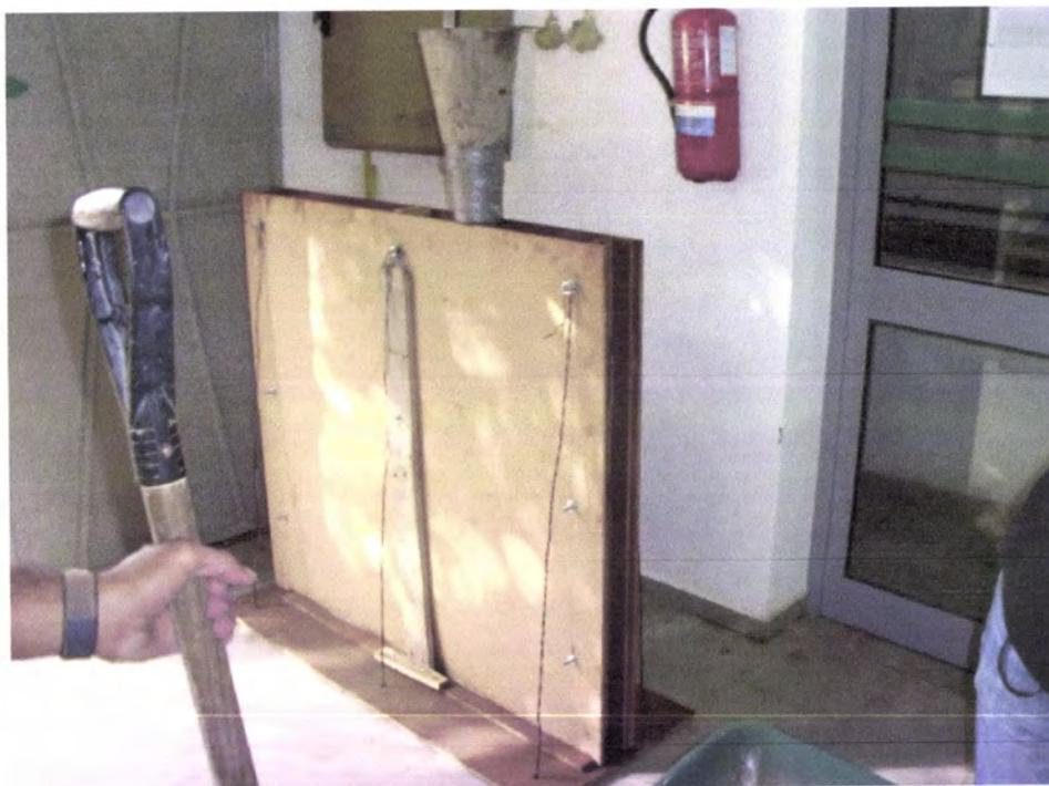
Figura 11 - Cofragem do protótipo
