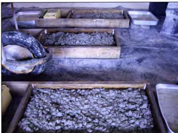
Figura 4. 3 – Primeira amassadura ao centro para ser colocada por cima da segunda amassadura
