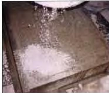
**Figura 4. 14** – Colocação do endurecedor de superfície
