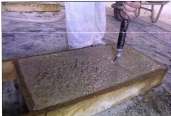
Figura 4. 1 – Vibração da amassadura de betão
