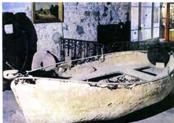
Figura 2.3 – Barco em ferrocimento construído por Jean-Louis Lambot em 1848.
