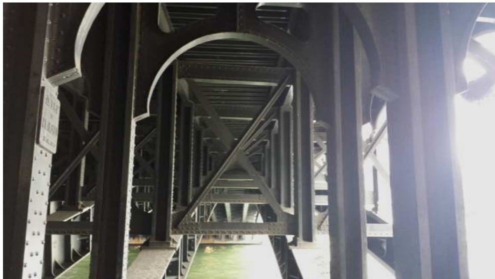
Figure 5 : le pallier du pont
