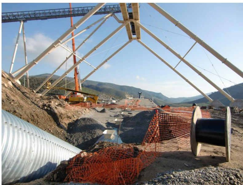
“Edifício das areias” (em construção) – Estaleiro da obra da Barragem do Sabor - 2010
