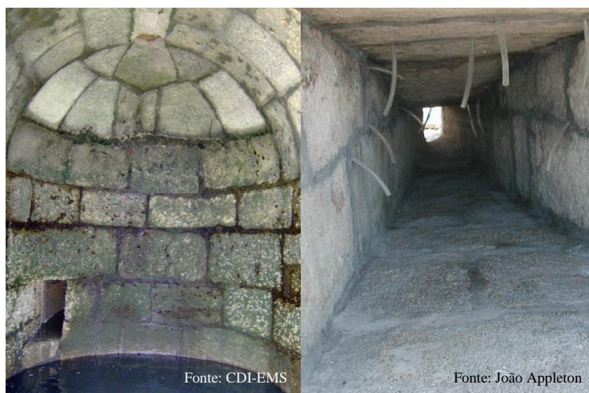
Figura 19 –Vista de uma abóbada dos rodízios do Moinho de Corrois (esq.); Vista do interior de uma setia do Moinho do Montijo (dir.)
