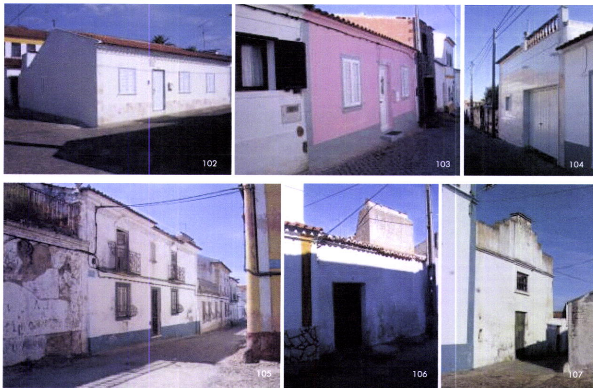
102, 103, 104, 105, 106 e 107 Habitações "degradadas", quer por terem sido alvo de intervenções incorrectas, quer por se encontrarem devolutas.
