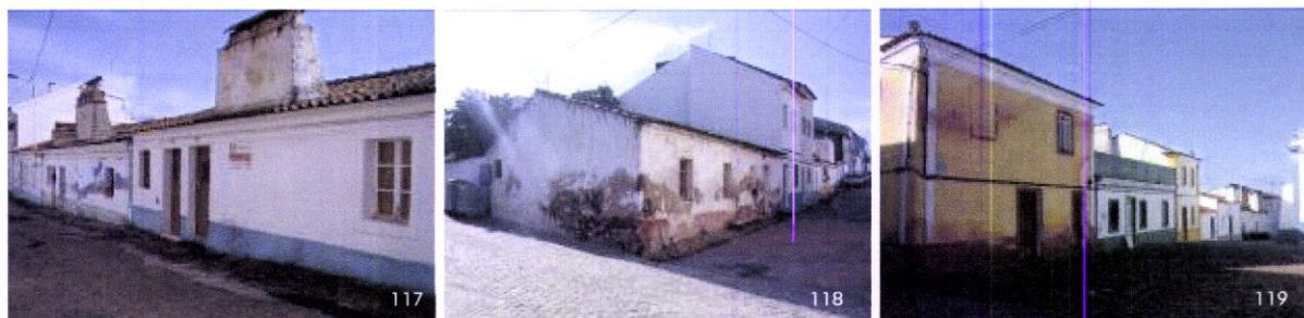
117, 118 e 119 Habitações degradadas.
