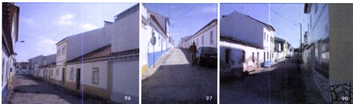
96, 97 e 98 Construções recentes com 1º andar.
