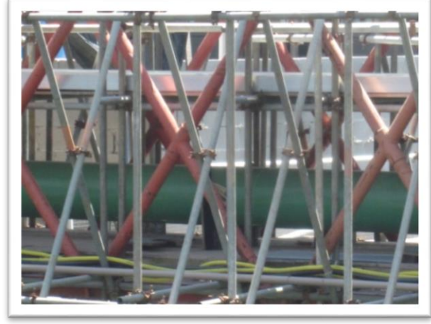
Figura 23 - Suspensão executada para suportar conduta de água desviada
