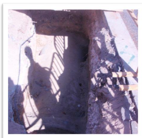
Figura 36 - Condução de água- abertura de vala para reabilitação de juntas - Obra Estação de Metro Areeiro
