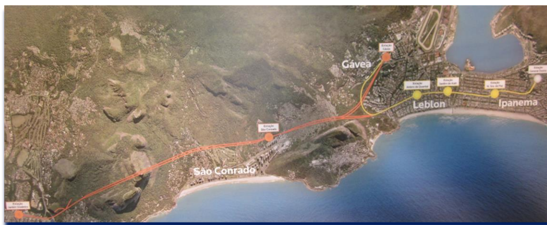
Figura 20 - Imagem da Linha 4 em construção. Fonte: Fotografia própria sobre o original do Metro do Rio
