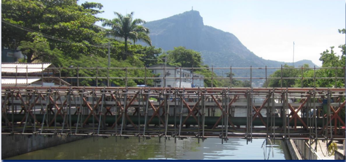
Figura 21 - Desvio de conduta de água com suspensão sobre a linha de água
