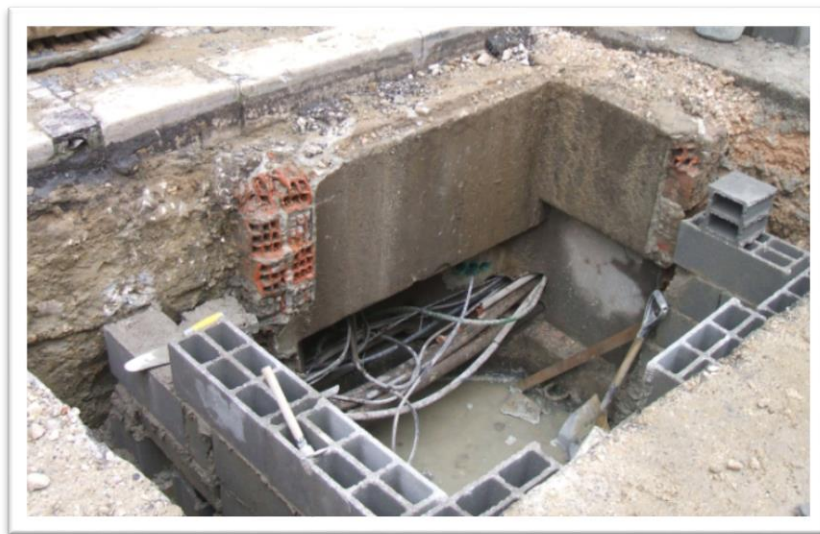
Figura 32 - Reabilitação de caixa de visita de Telecomunicações Remodelação da Estação Saldanha 1 Fonte: Base de dados da empresa Ferconsult
