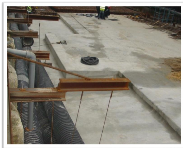
Figura 35 - Suspensão física do coletor com recurso a perfis metálicos e cabos Obra Estação de Metro Saldanha Fonte: Base de dados da empresa Ferconsult
