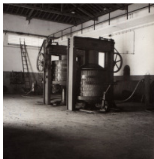
Fig. 41 Prensas hidráulicas "titan". Lagoa
