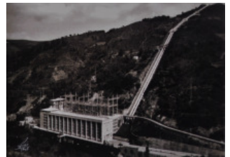
FIG. 7 Edifício de comando e descarga da estação hidroeléctrica do Cávado, 1947. Arq.º Januário Godinho
