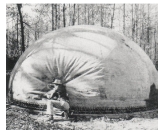
FIG. 46 Cofragem pneumática (primeiro enchimento)
