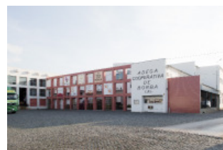
FIG. 96 Situação actual do edifício original da adega cooperativa de Borba.
