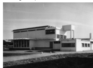
FIG. 97 Edifício original da adega cooperativa de Borba.
