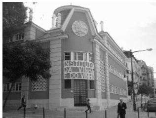
FIG. 4 Sede da extinta Junta Nacional do Vinho, 1941. Arqº Cassiano Branco.
