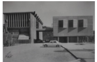
FIG. 8 Edifício de comando e descarga da estação hidroeléctrica da Bemposta, 1958-64. Arqs.º Archer de Carvalho, Nunes de Almeida e Rogério Ramos.
