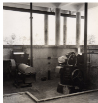
FIG. 35 Desengaçador/esmagador no tegão da adega cooperativa de Lagoa (demolido).
