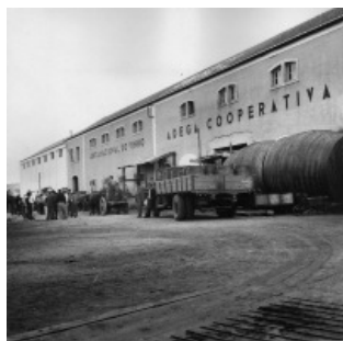
FIG. 48 Edifício comprado e ampliado pela JNV em Pinhel.
