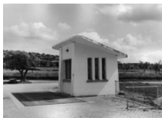
FIG. 32 Balança da adegua do Redondo (demolida).
