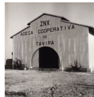
FIG. 22 - Pavilhão metálico desmontável em Tavira.
