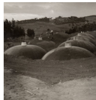
FIG. 47 Processo de enterramento dos depósitos air-form em São Mamede da Ventosa.
