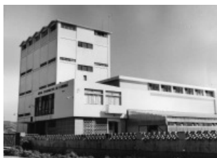
FIG. 102 Adega cooperativa da Lourinhã (demolida).
