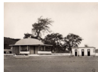
FIG. 45 Habitação air-form do guarda na adega da Lourinhã.
