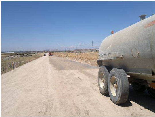
RIEGO SELECCIONADO PARA EXTENDER - TRAMO DE PRUEBA.
