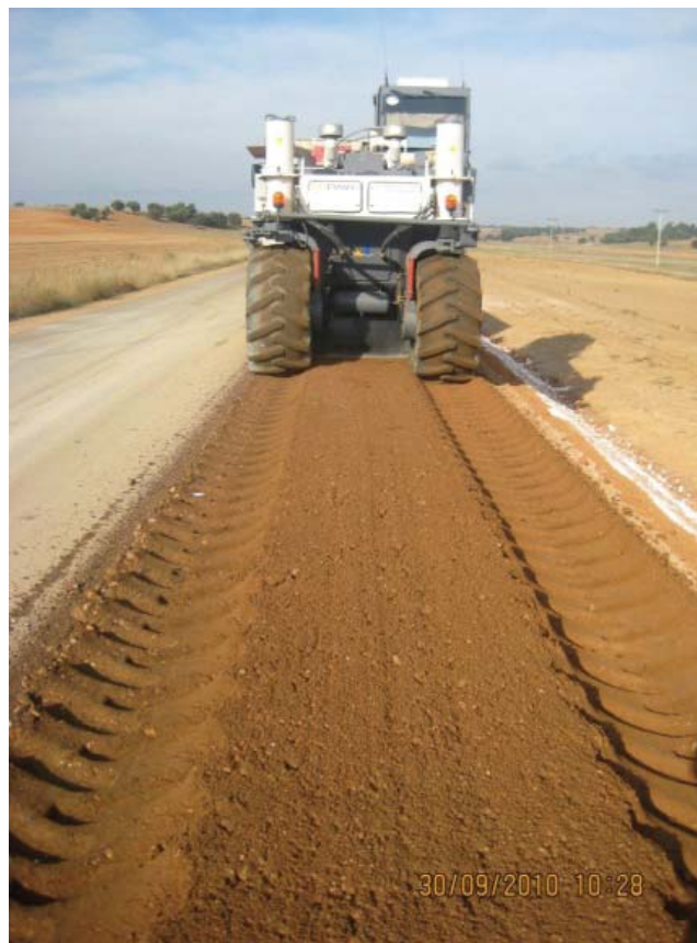
Figura 4. 41 - Aspectos del suelocemento in situ a la salida del equipo, material sin refinar ni compactar.
