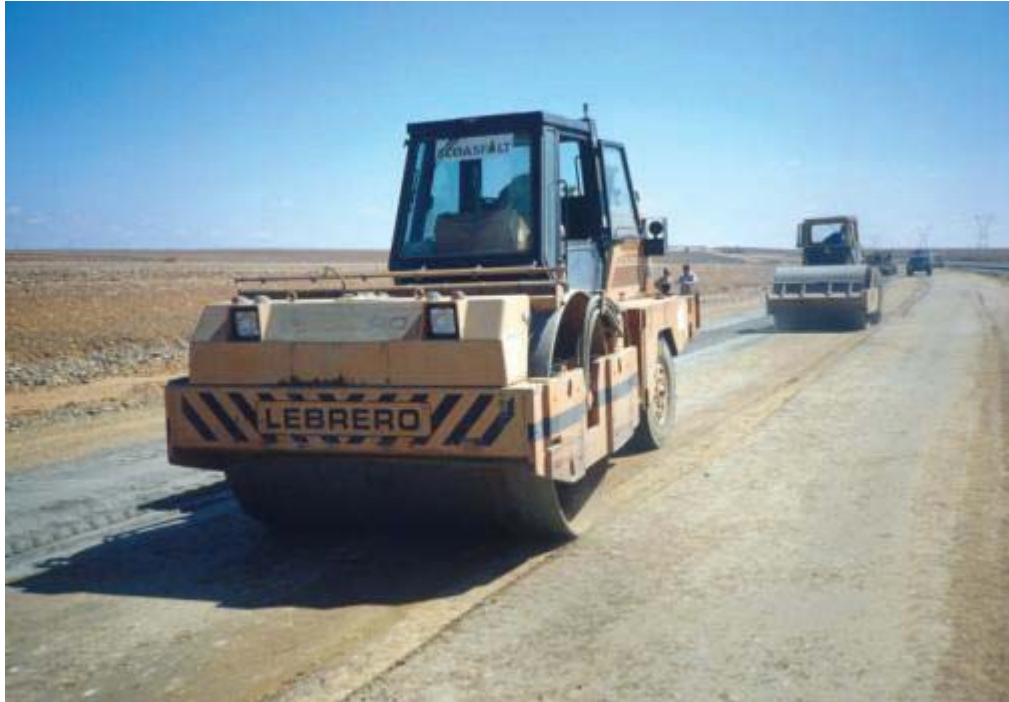
Figura 2.13 - Tren de compactado sobre la capa tratada.
