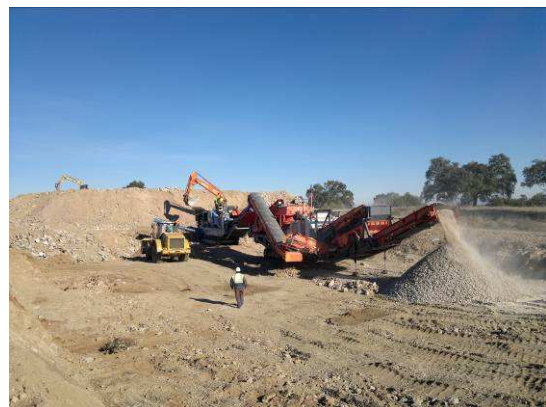
MACHAQUEO Y ACOPIO DE MATERIAL PARA SC.
