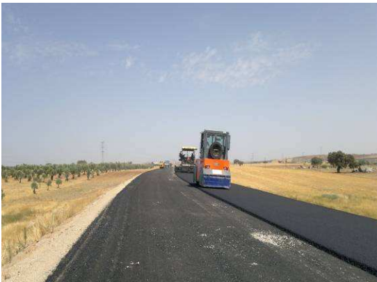
EXTENDIDO PRIMERA CAPA DE AGLOMERADO SOBRE SUELOCEMENTO.
