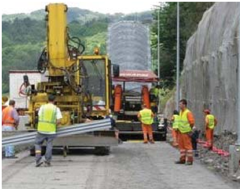
Figura 4.24 - Extendido y prefisuración con juntas activas en la AP-8.
