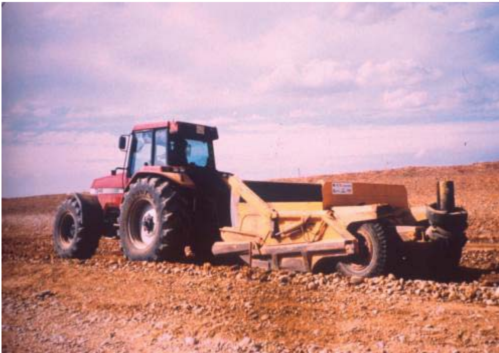
Figura 2.9 - Trabajos en material.
