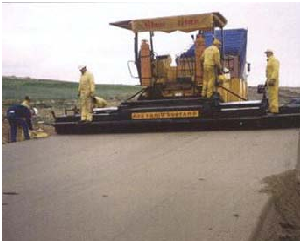
Figura 4.18 – Extendedora de suelo cemento.
