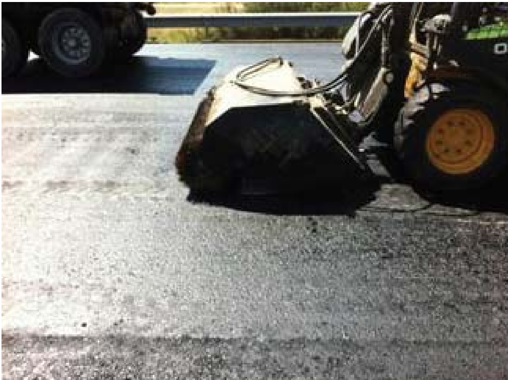
Figura 4.31 - Limpieza con barredora.
