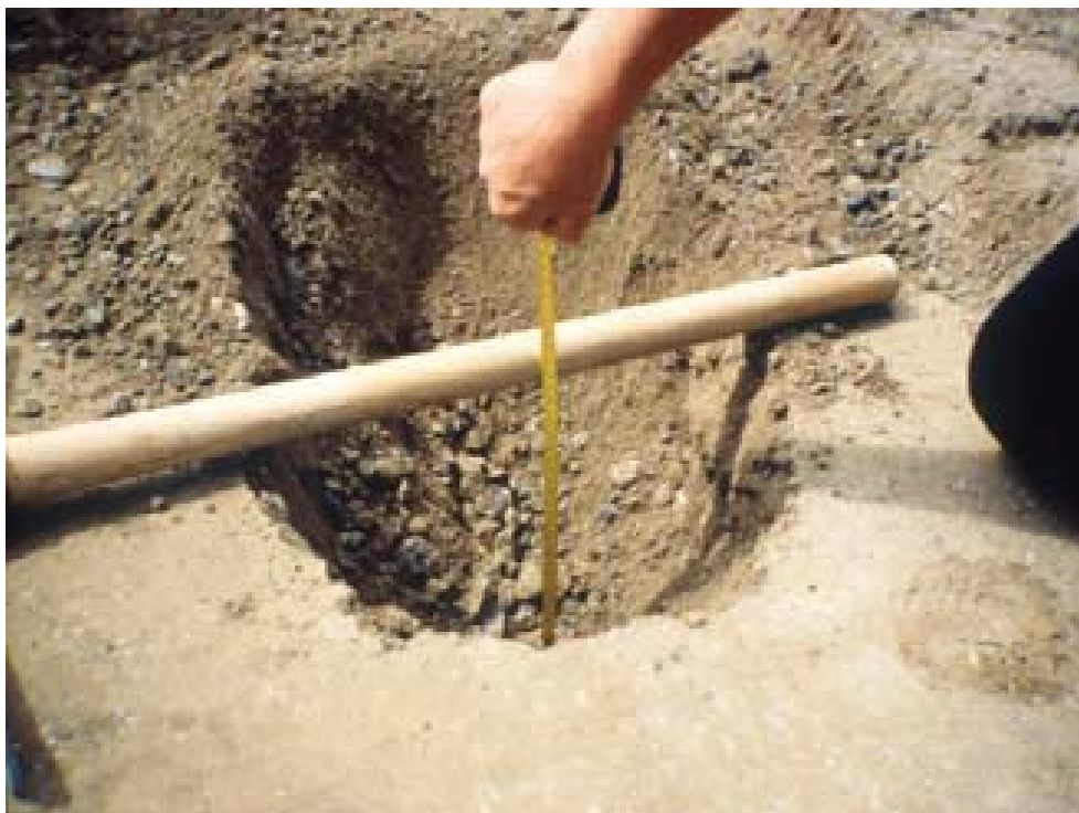
Figura 4.46 - Control de espesores, humedad y densidad.
