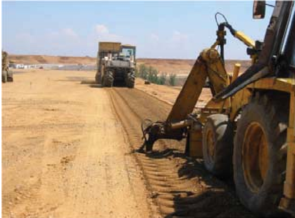
Figura 4.52 - Prefisuración del suelocemento.
