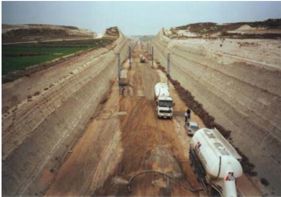
Figura 2.3 - Trabajos en trazado de obra lineal (Guía Técnica, 2013).
