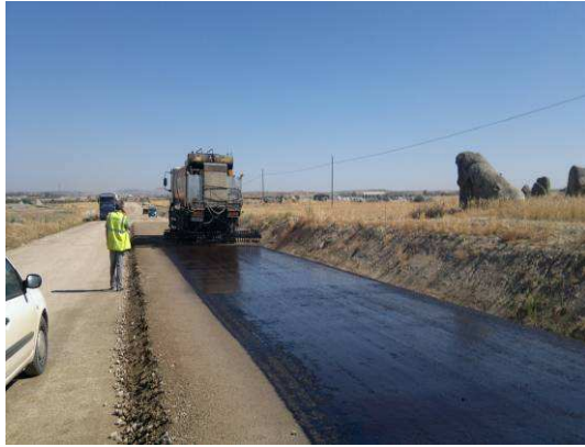
RIEGO DE CURADO CON EMULSIÓN.
