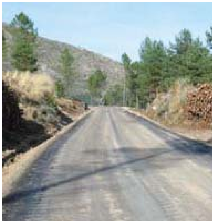
Figura 4.36 - Vista traza después de los trabajos de suelocemento in situ .
