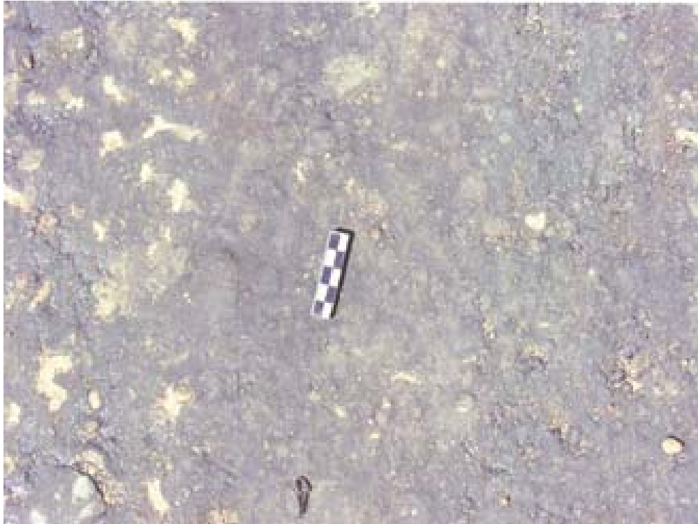
Figura 4.55 - Detalle de la terminación del suelocemento realizado in situ correctamente.
