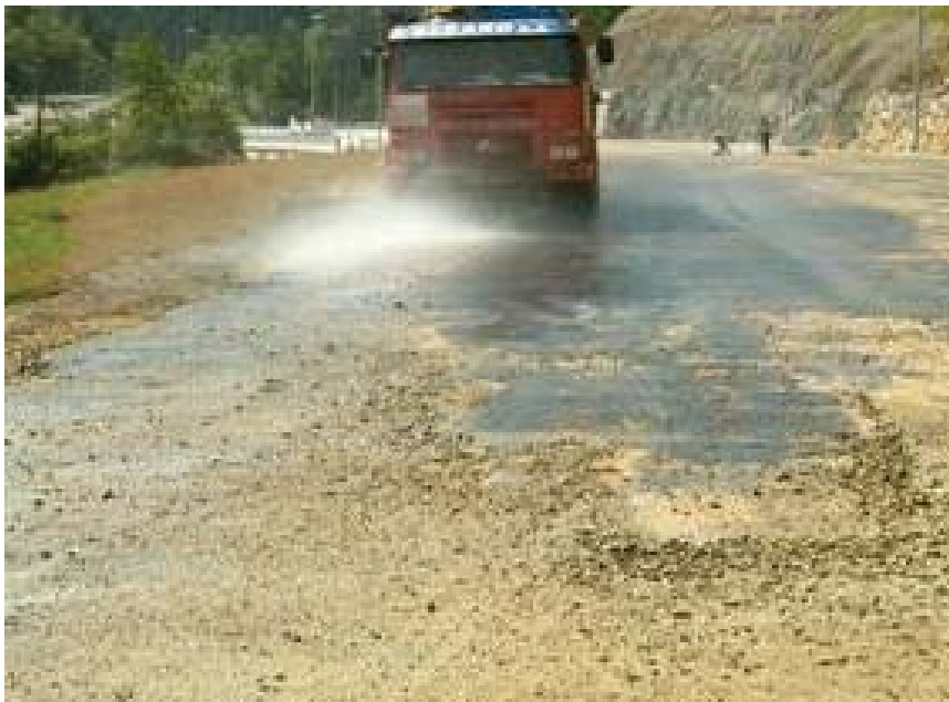
Figura 4.30 - Limpieza con agua a presión.
