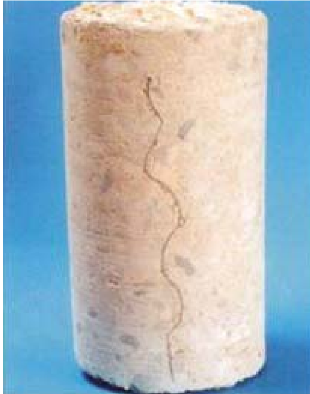
Figura 4.25 - Testigo extraído de una junta realizada con el sistema de juntas activas.
