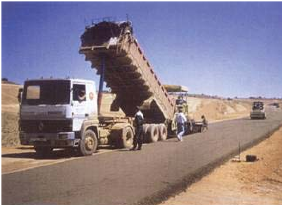
Figura 4.1 - Puesta en obra extendido de suelocemento con extendedora (Guía Técnica, 2014).
