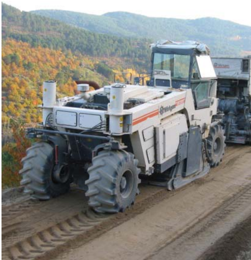
Figura 4.35 - Suelocemento in situ - trabajos maquinaria mezcladora, Wirtgen de picas.
