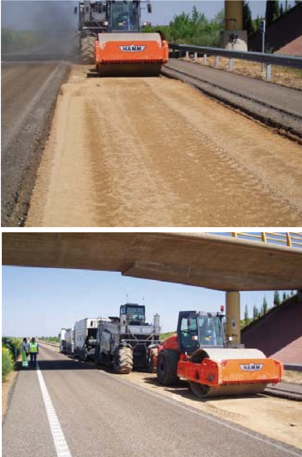
Figura 4.43 - Rehabilitación de un carril mediante técnica de suelocemento.
