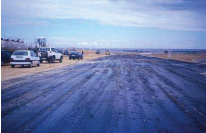
Figura 2.16 - Terminación de la capa, después de regada con emulsión.
