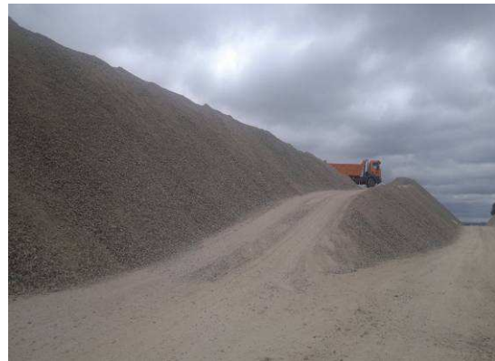
ACOPIOS DE MATERIAL PARA SUELOCEMENTO.
