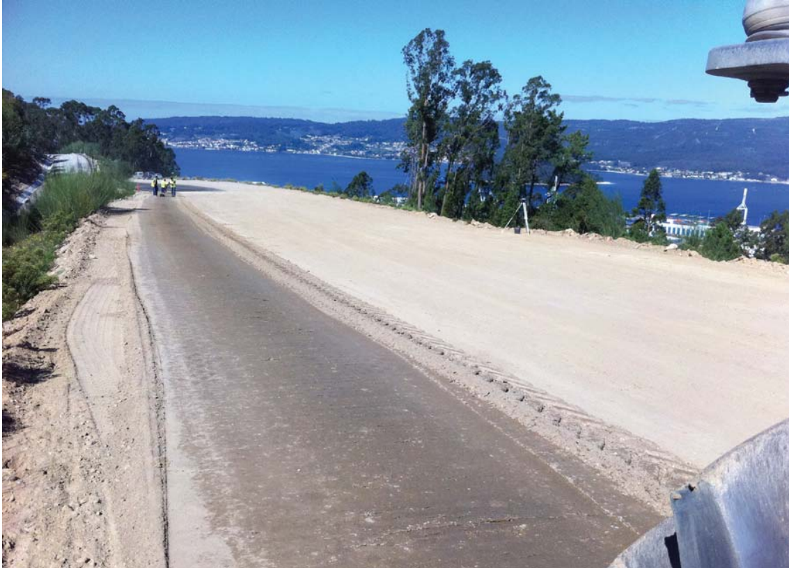
Figura 2.17 - Riego con agua de la capa estabilizada.
