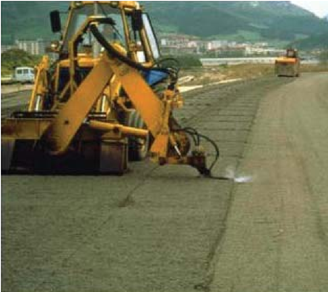
Figura 4.9 - Prefisuración de una capa de material tratado con cemento (Sistema Craft).
