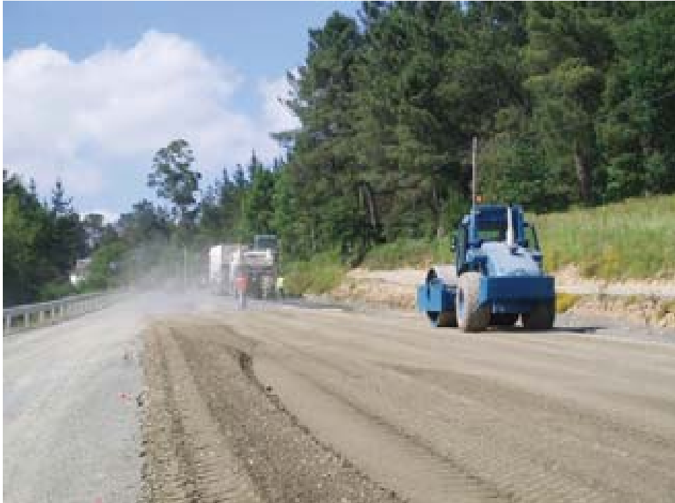
Figura 4.44 - Perspectiva de los equipos de compactación y refinado del material.
