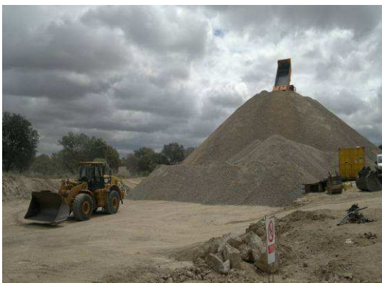
ACOPIOS DE MATERIAL PARA SUELOCEMENTO.
