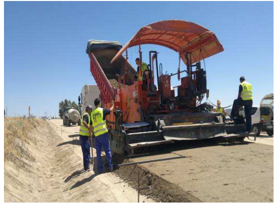
RIEGO SELECCIONADO PARA EXTENDER - TRAMO DE PRUEBA.
