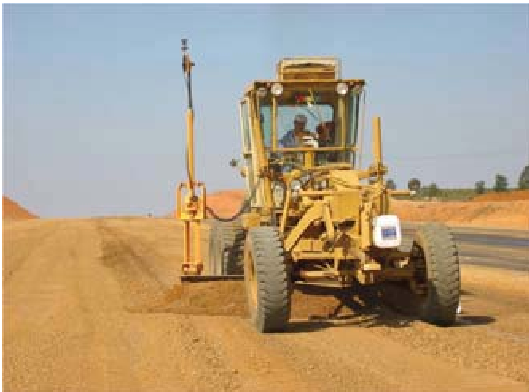
Figura 4.53- Nivelación de suelocemento con equipo dotado de 3D.
