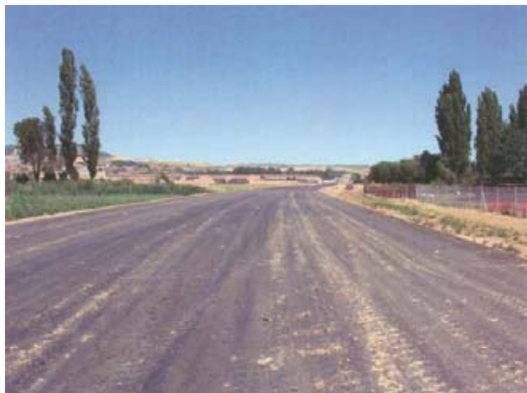
Figura 4. 38 - Trazado y riego de curado del suelo estabilizado.
