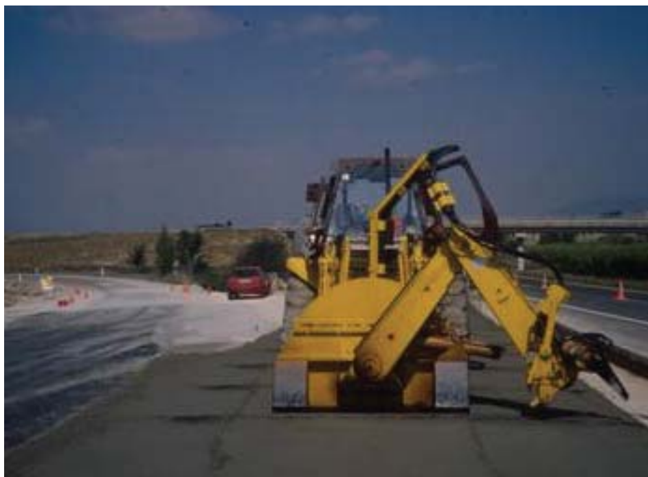
Figura 4.26 - Prefisuración en fresco tipo Craft que introduce un chorro de emulsión.
