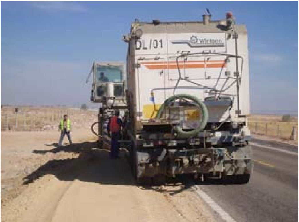
Figura 4.49 - Dosificador de lechada se hunde en un suelo arenoso.
