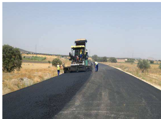
EXTENDIDO PRIMERA CAPA DE AGLOMERADO SOBRE SUELOCEMENTO.
