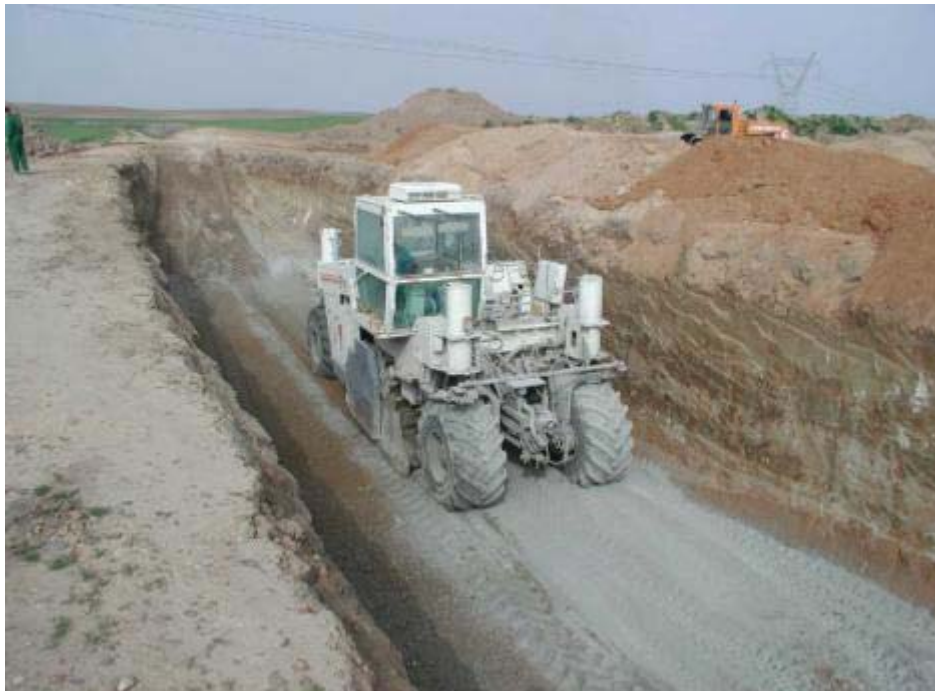
Figura 2.2- Estabilizadora de tambor con picas, recicladora Wirtgen (Guía Técnica, 2013).
