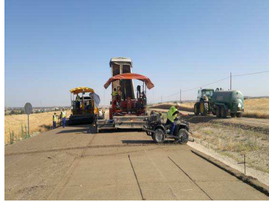
EXTENDIDO – JUNTAS CON EMULSIÓN PARA ROTURA.
