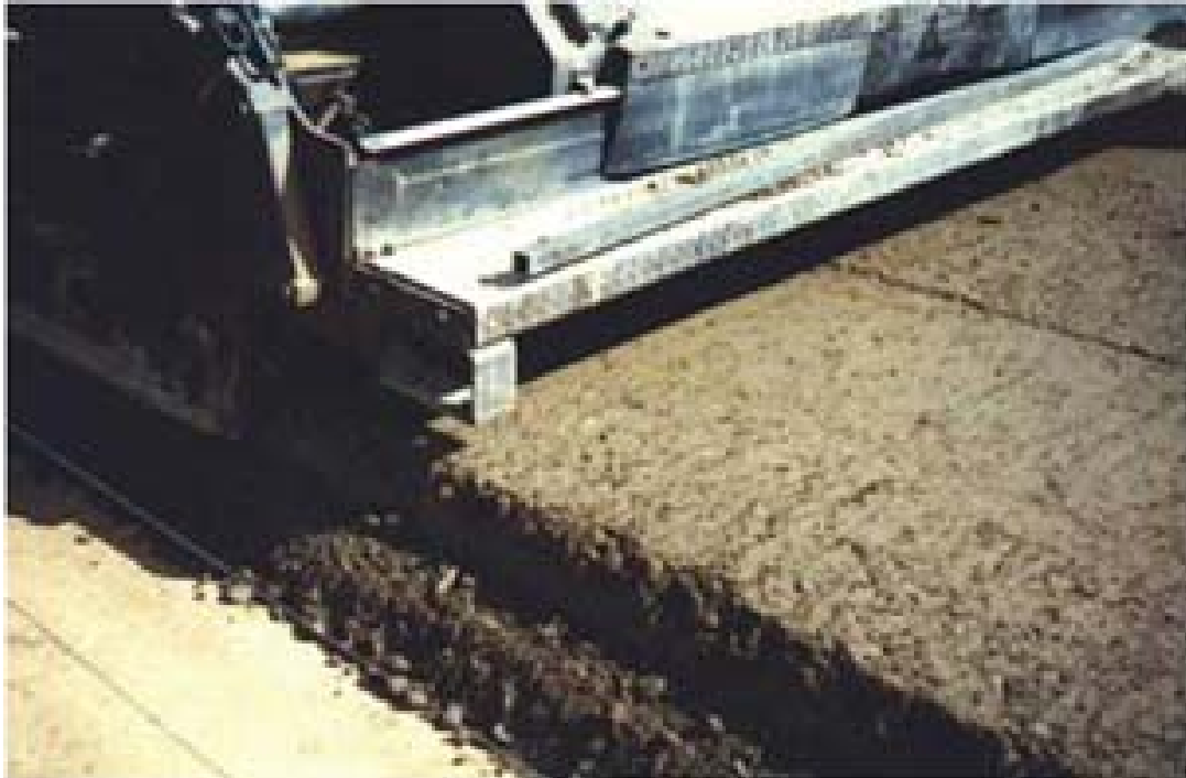
Figura 4.34 - Extendido de material tratado con cemento.
