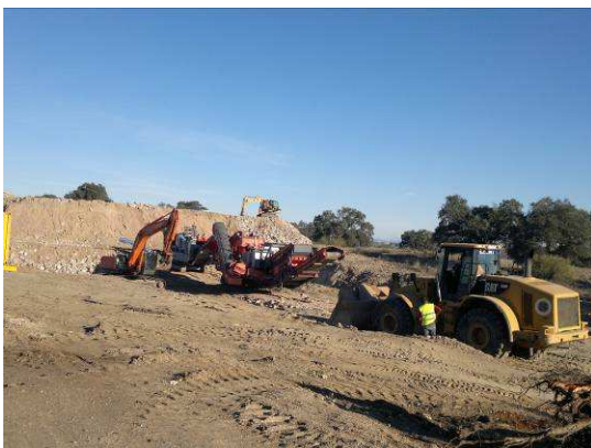
MACHAQUEO Y ACOPIO DE MATERIAL PARA SC.
