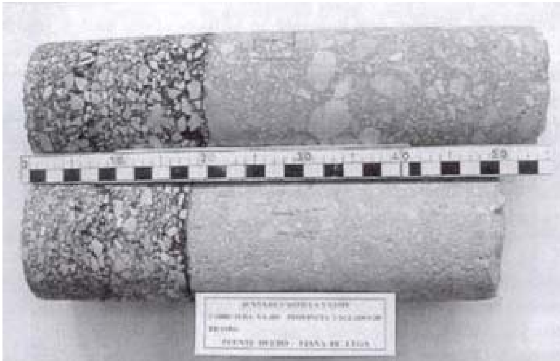
Figura 4.5- Testigos extraídos de un firme con base de suelocemento (Guía Técnica, 2014).
