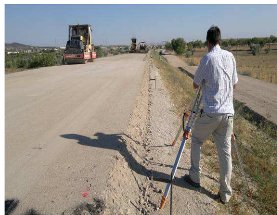
CONTROL CON TOPOGRAFÍA ANTES Y DESPUÉS DEL EXTENDIDO.
