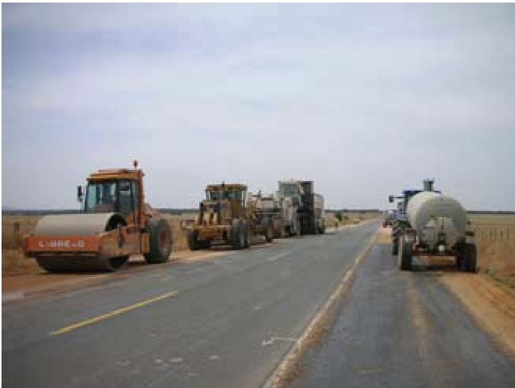
Figura 4.54 - Equipos de suelocemento in situ en un ensanche.
