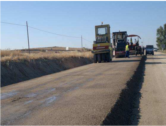
TRAMO DE PRUEBA COMPACTACIÓN Y DENSIDADES - HUMEDADES.
