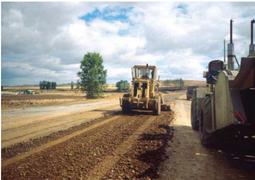
Figura 2.12 - Trabajos de refinó con motoniveladora.
