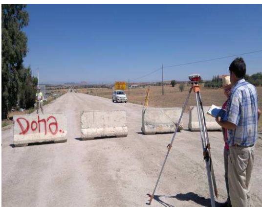
CONTROL CON TOPOGRAFÍA ANTES Y DESPUÉS DEL EXTENDIDO.
