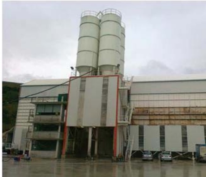
Figura 4.14 - Central de fabricación discontinua.
