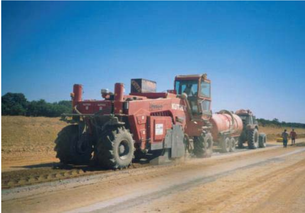
Figura 2.11 - Estabilizadora de tambor, con picas (Guía Técnica, 2013).
