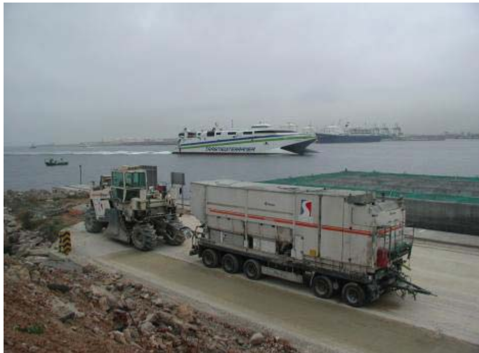
Figura 2.1 - Estabilización de plataforma junto al mar, con recicladora Wirtgen (Guía Técnica, 2013).
