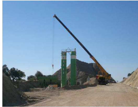
PLANTA FIJA DE SUELOCEMENTO, MONTAJE.
