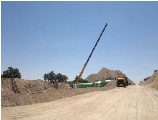
PLANTA FIJA DE SUELOCEMENTO, MONTAJE.
