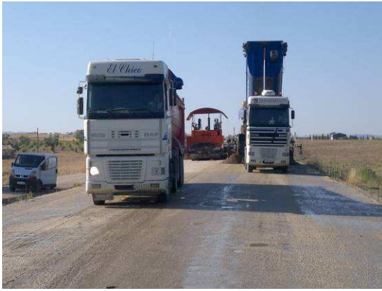
EXTENDIDO – JUNTAS CON EMULSIÓN PARA ROTURA.
