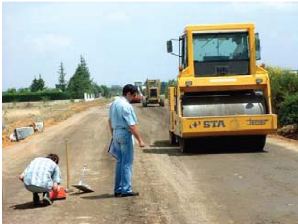
Figura 4.47 - Control de humedad y densidad en obra.
