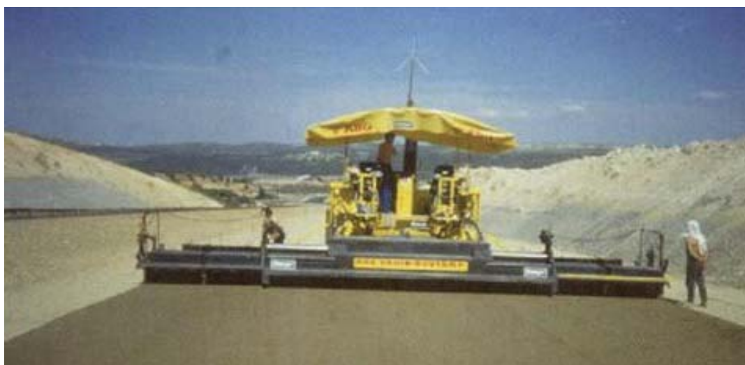
Figura 4.7 - Construcción de una base con material tratado con cemento.
