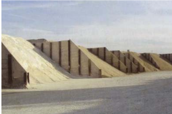
Figura 4.16 -Acopios de áridos.
