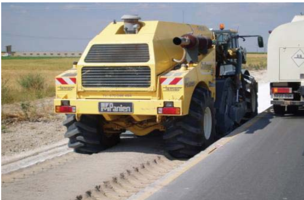
Figura 2.8 – Trabajos con la Wirtgen sobre la capa superior extendida previamente (Guía Técnica, 2013).
