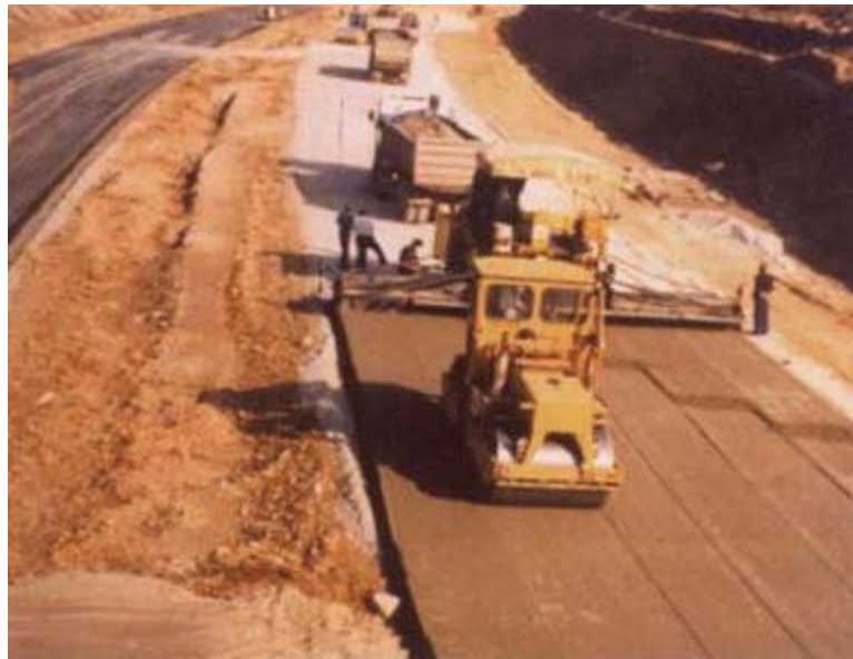
Figura 4.20 - Compactación de capa de suelocemento.
