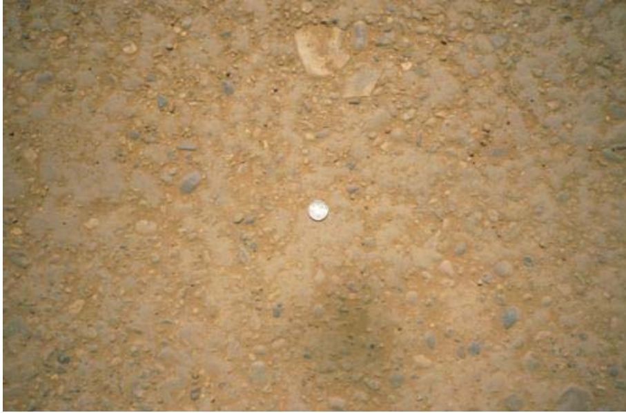
Figura 2.19 - Terminación superficial de la capa estabilizada, antes de emulsión.
