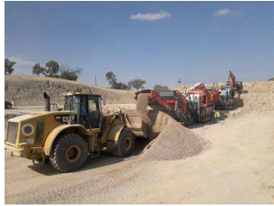
MACHAQUEO – FABRICACIÓN DE MATERIAL PARA SC.
