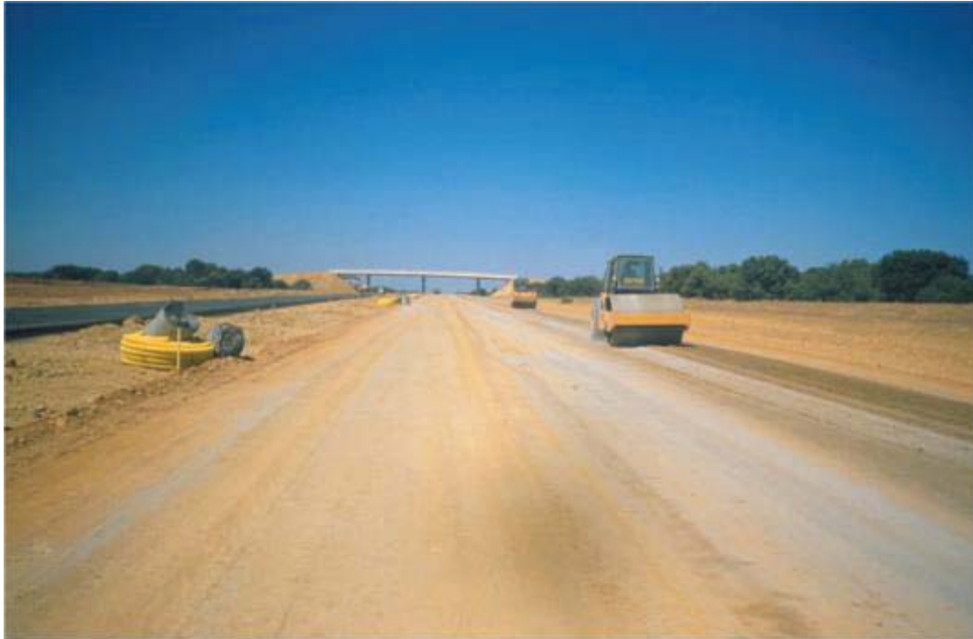
Figura 2.18 - Trabajos de compactación de la capa estabilizada.
