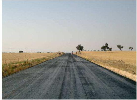
RIEGO DE CURADO CON EMULSIÓN.
