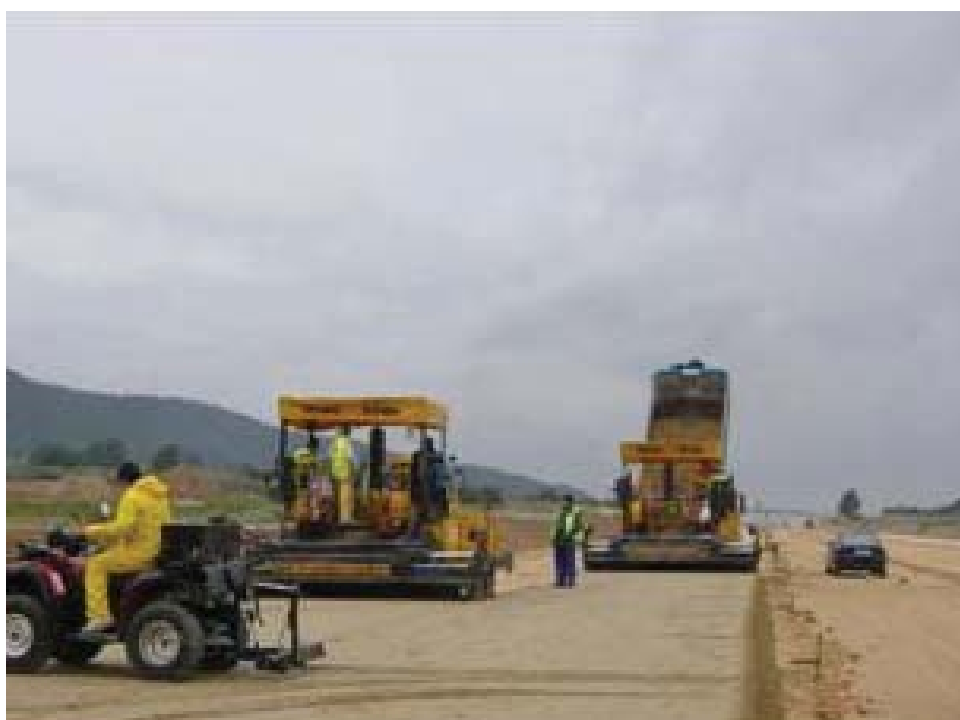
Figura 4.27- Otros equipos de prefisuración en fresco que introducen un chorro de emulsión.
