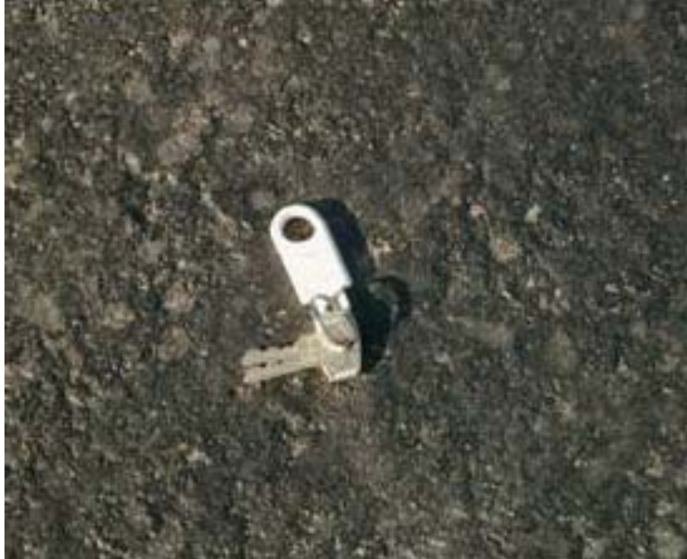
Figura 4.29 - Aspecto superficial de un buen riego de adherencia.
