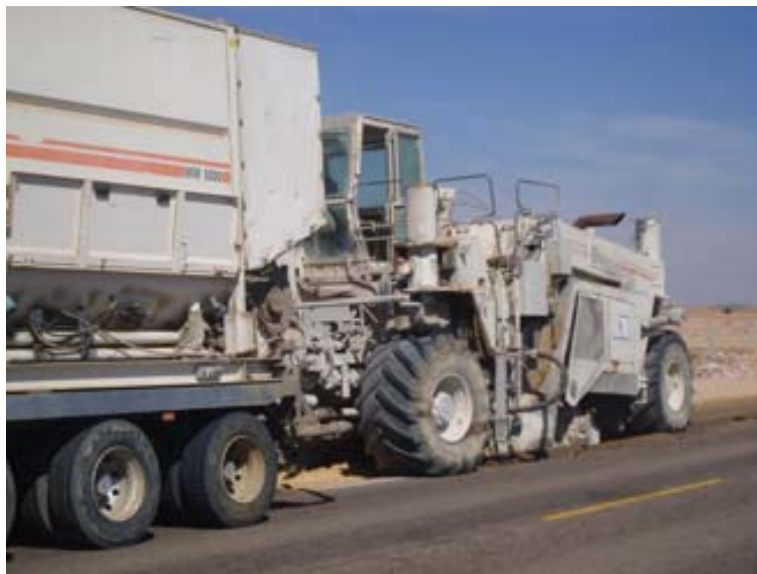
Figura 4.37 - Trabajos maquina estabilizadora Wirtgen.
