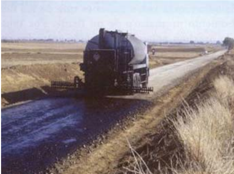
Figura 4.21 - Riego de curado camión con barra regadora horizontal.
