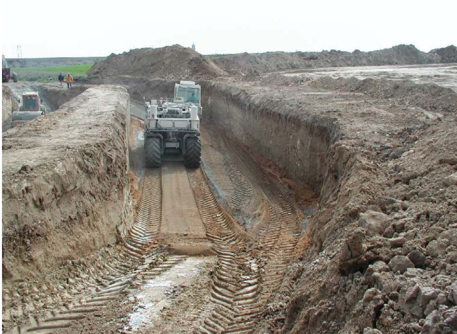
Figura 2.20 - Trabajos de estabilizado, con maquina Wirtgen (Guía Técnica).
