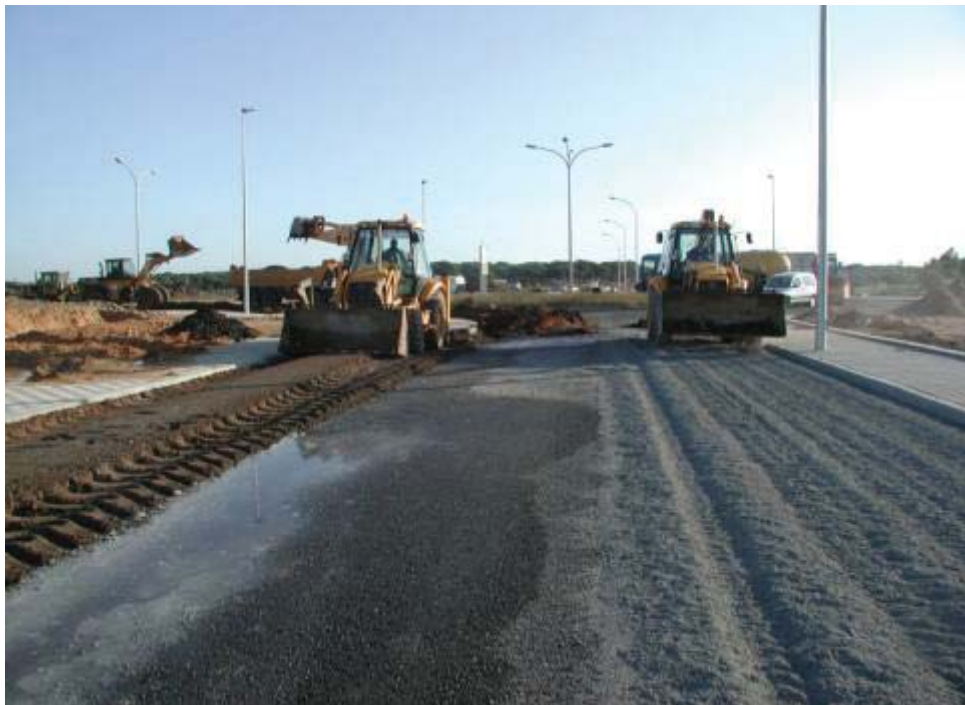
Figura 2.5 - Trabajos en traza.
