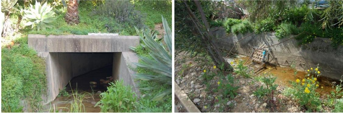
**Figura 4.3** Troços da ribeira da canada: passagem hidráulica (esq.) e secção trapezoidal (dir.)
