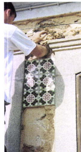
Figura 37 – remoção de azulejos da fachada
