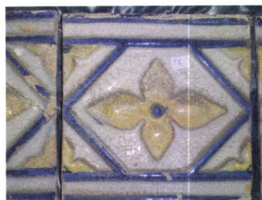
Figura 36 – Etiquetagem dos azulejos, antes das intervenções de conservação e restauro
