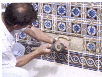
Figura 61 – Limpeza e humedecimento do suporte
