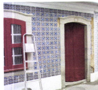
Figura 35 – Fachada onde decorreu a acção de formação
