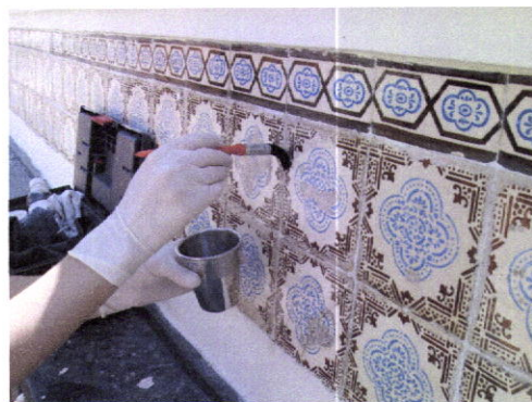
Figura 45 – Consolidação de azulejos executada no local
