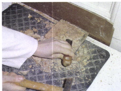
Figura 40 – Exemplo da remoção mecânica de argamassas do tardez
