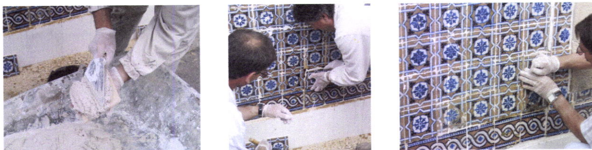
Figura 63 – Aplicação da argamassa no tardo e recolocação no suporte
