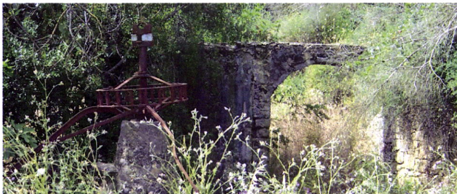
Fig. 63 – Nora e aqueduto junto à Ribeira da Murta.
