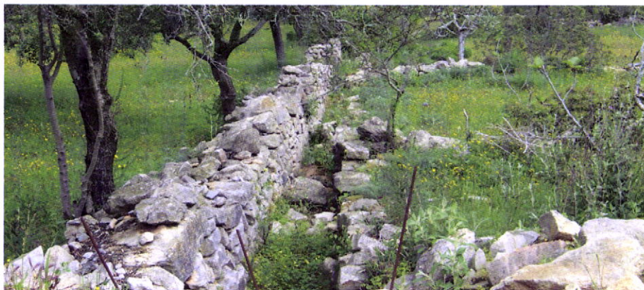
Fig. 59 – Valados na divisória de parcelas e vala de drenagem, ambos em pedra aparelhada resultado da despedrega.
