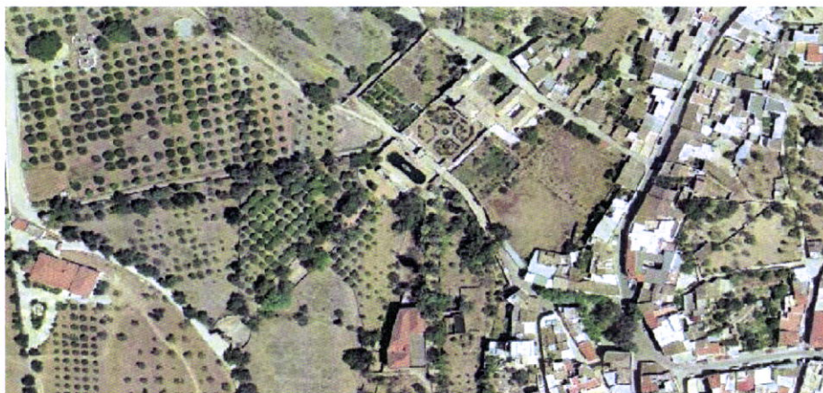
Fig. 5 – Vista aérea do sector poente da Aldeia de Estoi onde se insere o Palácio de Estoi. Fonte: Google Earth Junho 2007
