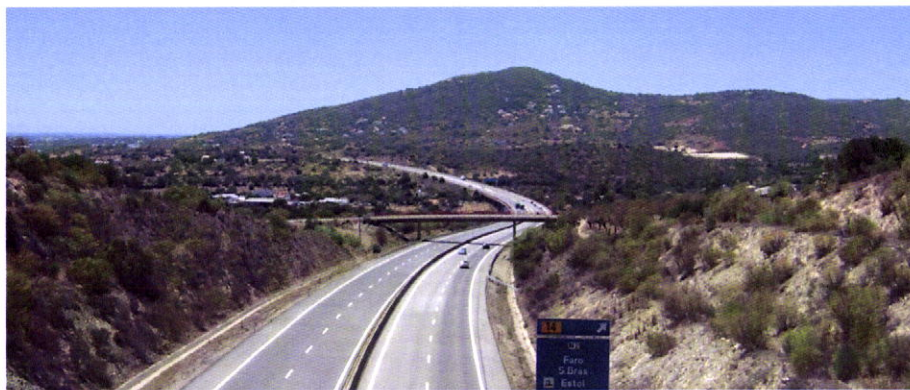
Fig. 29 – Via do Infante: atravessa a Freguesia de Estoi na transição do Barrocal para a planície litoral. Ao fundo, o Cerro do Guilhim.
