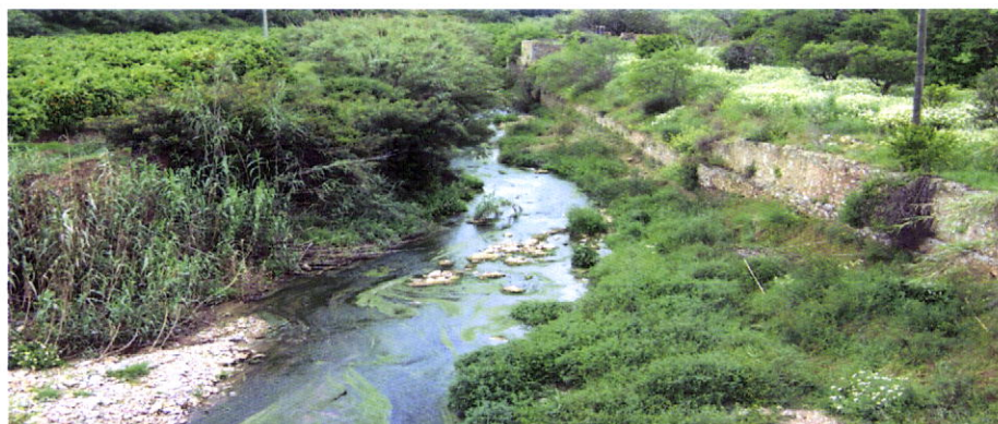
Fig. 50 – Rio seco, a juzante da ponte que liga Estoi a Coiro da Burra.
