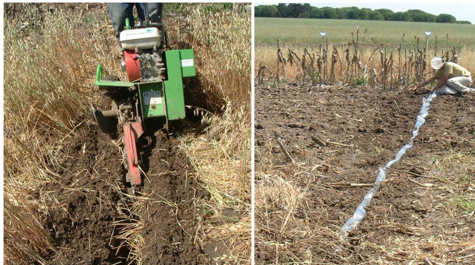
Figura 26 – Abertura de vala para colocação de tela, num talhão de SD, na zona de transição entre os dois níveis de salinidade (foto à esquerda), e colocação de tela plástica no topo dos talhões da repetição 2 e 3 do SC (foto à direita). Fotos feitas após a sementeira de 2005.
