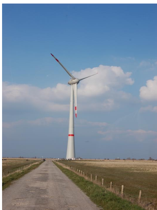
a) Enercon E-126 [Enercon14].
