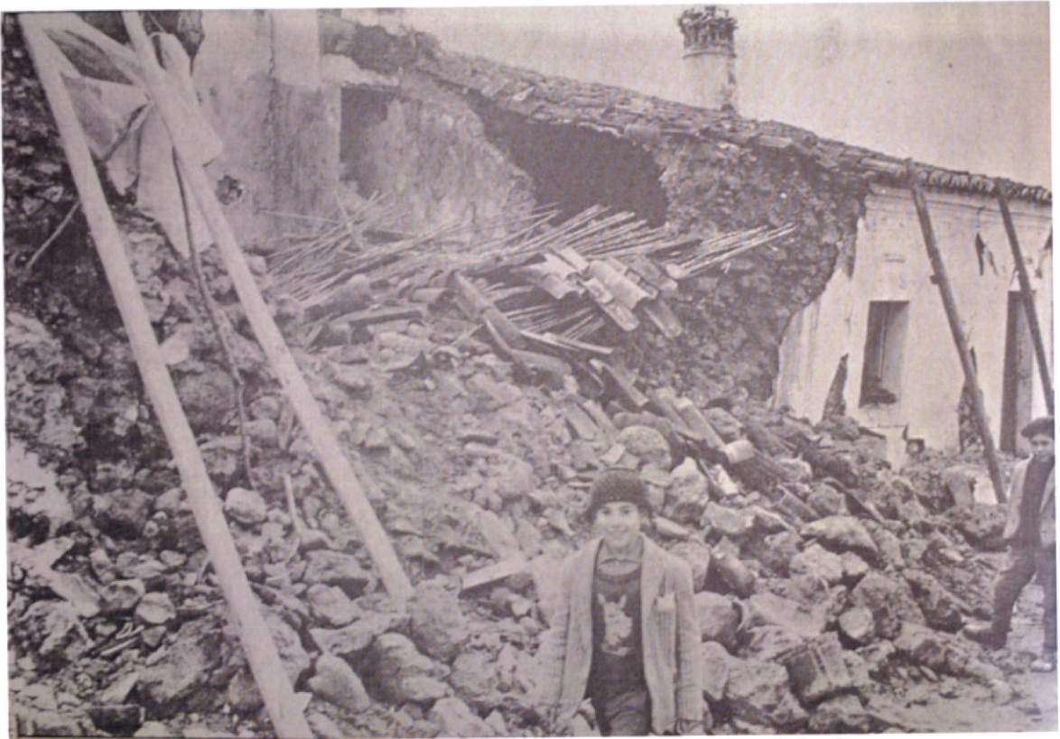
"Fontes Lozeiros. Uma casa e quinze montes de entulho."
