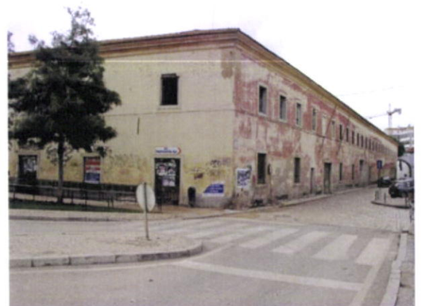
Paredes exteriores em alvenaria de pedra e terra
