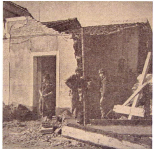
Silves. Pormenor de reconstrução com recurso ao betão armado e alvenaria de tijolo de barro cozido.
