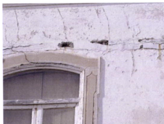
10-Rua Latino Coelho, pormenor de esticador em parede de alvenaria.
