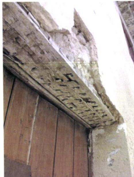
Fig.73-Exemplo da preparação de uma verga de porta para aplicação de reboco, numa construção localizada em Monchique.
