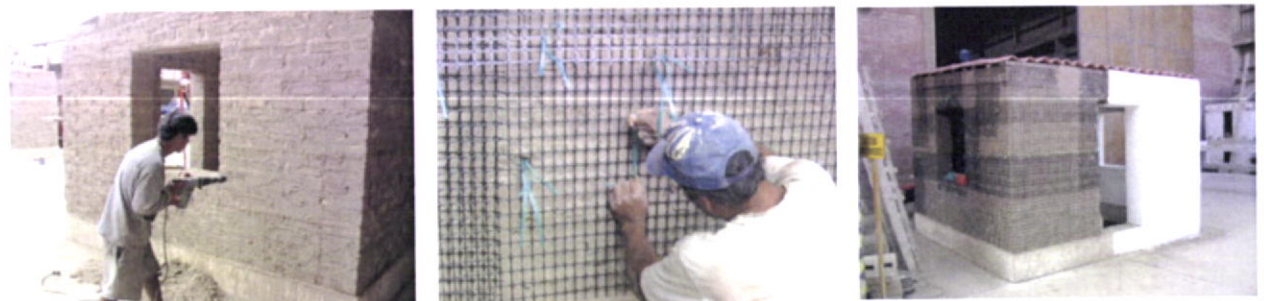
Fig.206-O Modelo 2, foi reforçado nas duas faces da parede com aplicação de rede de polietileno TENSAR BX 1200 fixa entre si com fitas plásticas. À direita observa-se a foto do modelo concluído e parcialmente rebocado, tal como foi ensaiado.
