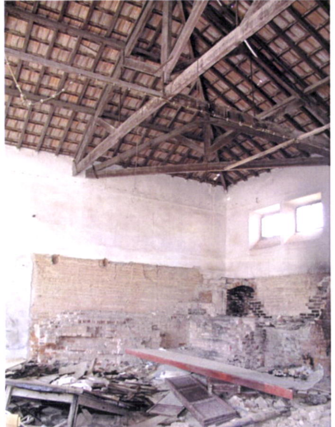
Fig.159-Vista da altura das paredes da nave industrial da fabrica de conservas Facho Limitada em Portimão, onde a taipa foi executada intercalando alternadamente camada de terra e argamassa de cal e areia.
