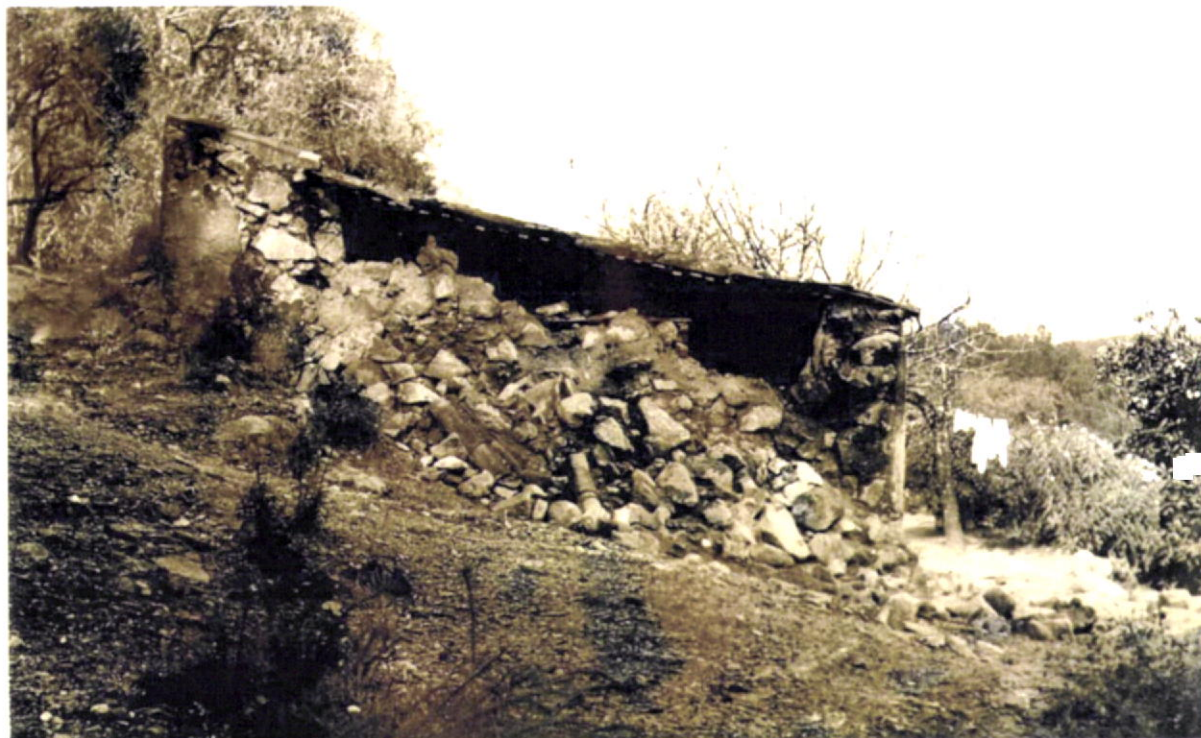
Fig.32-Casa de alvenaria de pedra e terra. Foto de António Silva Carriço. Sola, Monchique 28/2/1969.
