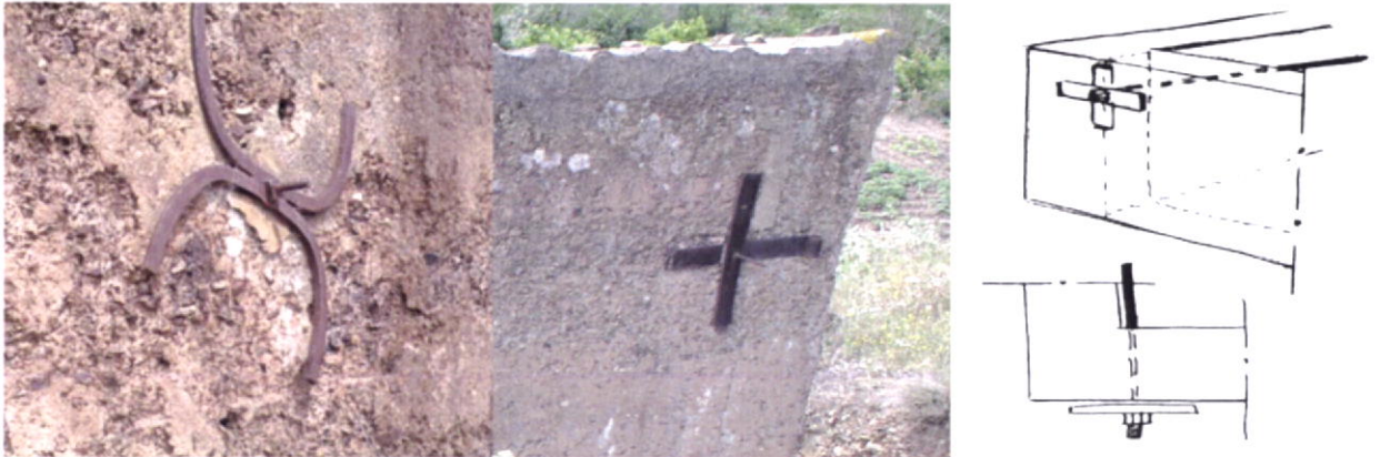
Fig.171-Tipos de esticadores encontrados e esquema de aplicação.
