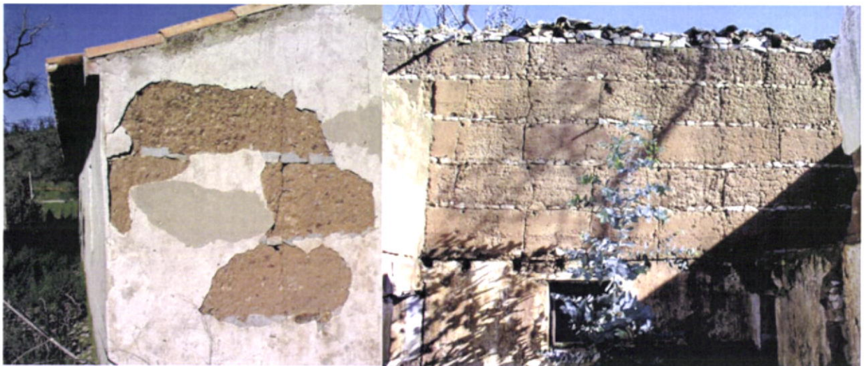
Fig.125-Pormenor da aplicação de pedras longitudinalmente ao longo das juntas. Aguas Belas.
