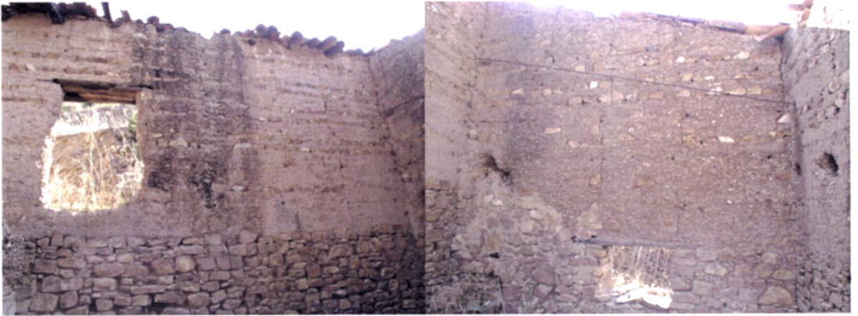
Fig.126-Pormenor da aplicação de pedras longitudinalmente ao longo das juntas, numa ramada. Segundo explicação do mestre Joaquim da Ladeira de Cima, esta solução era aplicada nas ramadas porque a palha apodrecia, quando ficava armazenada em contacto com a taipa.
