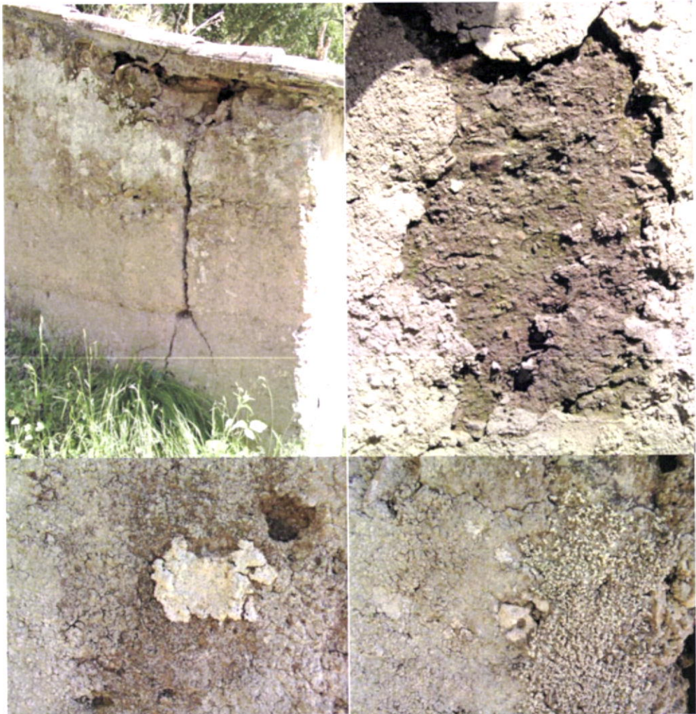
Fig.230-Exemplos de infestação liquénica
