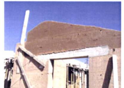
Fig.267-Pormenor de verga em betão. Odemira, Troviscais 28/76/2005.
