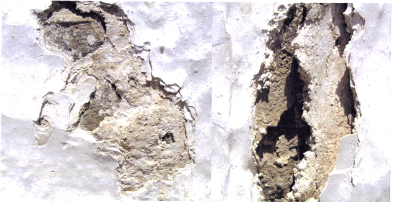
Fig.75-Aspecto de um revestimento composto por inúmeras camadas de cal sobre reboco tradicional.
