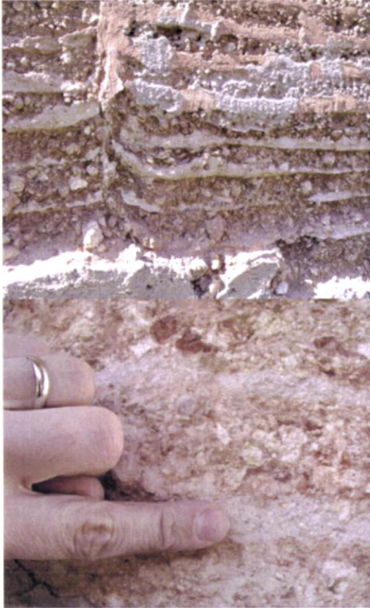
Fig.158-Exemplo de aplicação de camada de argamassa sobre cada camada de solo compactado. Fabrica de conservas Facho Limitada em Portimão.
