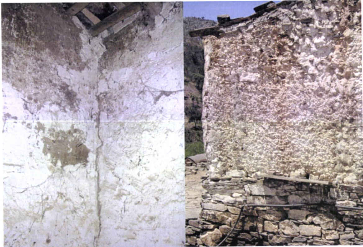
Fig.78-Pormenor de revestimento com pasta de cal, exemplo de aplicação em interior e exterior.
