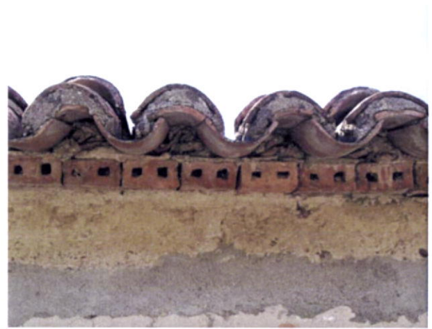
Fig.93-Pormenor de execução de beirado simples recente.
