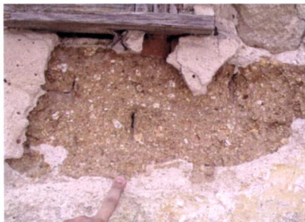
Fig.26-Exemplo de parede exterior realizada em adobe. Monchique.
