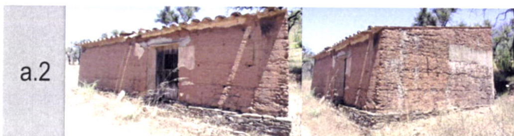
Fig.45-Pedros, construção de apoio à actividade agrícola em taipa. Fotografias do exterior.
