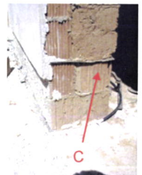
Fig.238-Exemplo da aplicação de (C) tela em PEAD. Algoz, Calvos.
