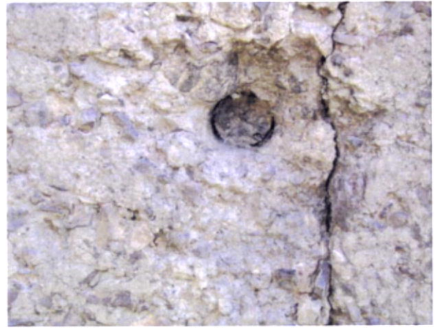
Fig.128-Pormenor de tapamento dos buracos das agulhas com madeira. Passil.
