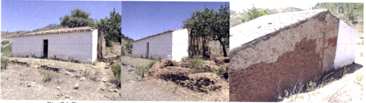
Fig.74-Pormenor de uma construção datada de 1940, onde se observa a textura irregular característica no reboco de cal, no revestimento da fachada principal.
