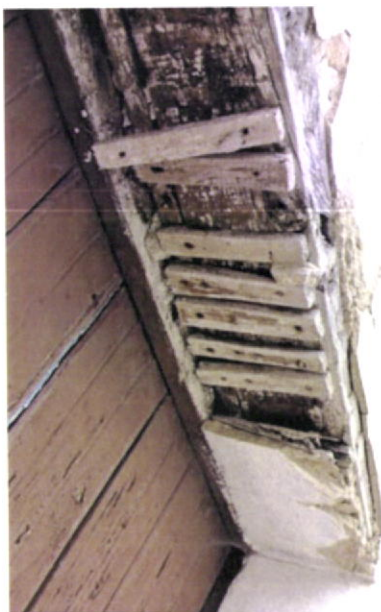
Fig.73-Exemplo da preparação de uma verga de porta para aplicação de reboco, numa construção localizada em Monchique.
