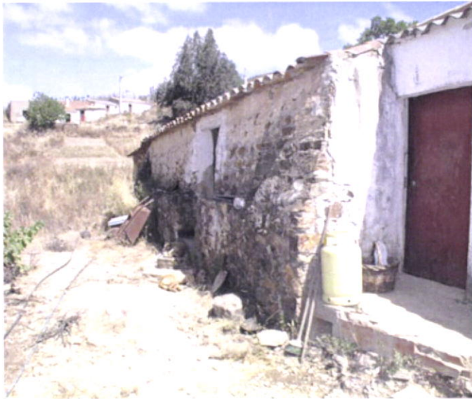
Fig.185-Pormenor da execução de reforço da base e enchimento em alvenaria de pedra, para correcção do desnível exterior da parede de taipa. Cancino.
