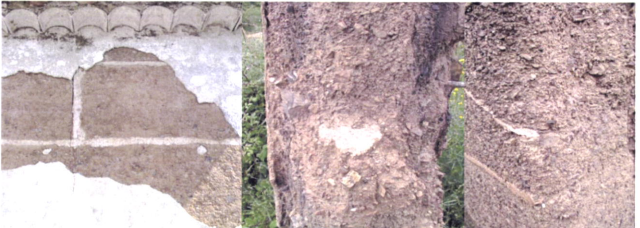
Fig.111-Exemplo de junta de cal em toda a espessura da parede, observe-se a pequena espessura (+/-0.5cm) a meio da parede comparativamente com as faces exteriores da parede onde passa a 2.5cm de espessura.
