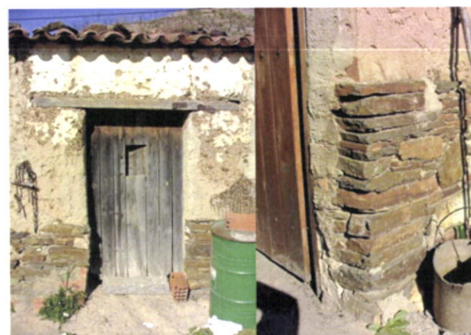
Fig.69-Pormenor de acilho em pedra de xisto, numa construção na Perna da Negra.
