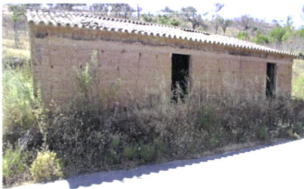
Fig.165-Vistas de uma construção junto à estrada para as Romeiras, onde se observa bem a existência de uma viga ao nível do topo dos vãos.
