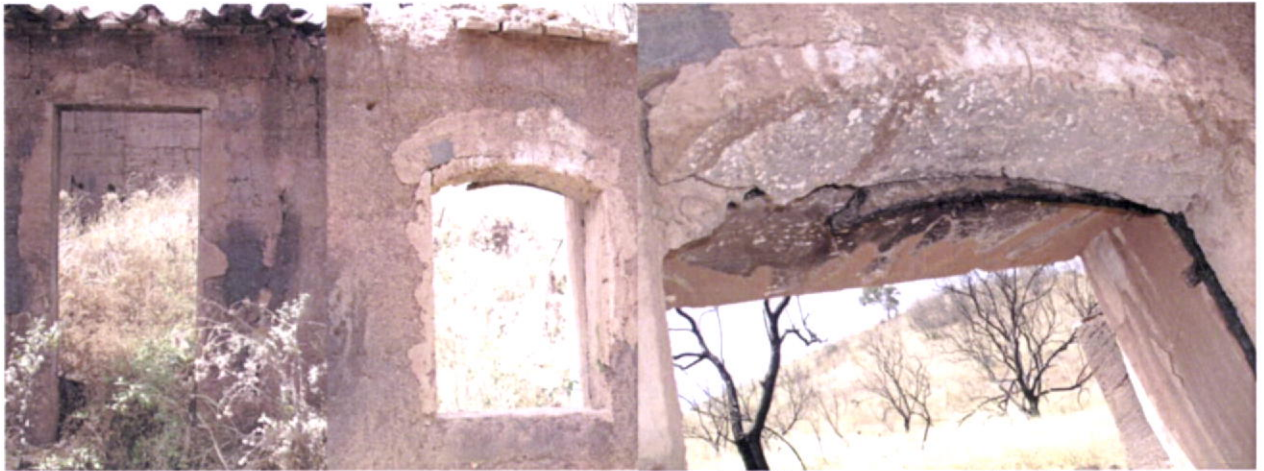
Fig.90-Pormenor de vão guardado com alvenaria de pedra e argamassa de cal e areia.
