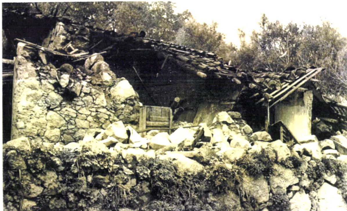
Fig.33-Vista de casa de alvenaria de pedra e terra. Foto de António Silva Carriço. Sola, Monchique 28/2/1969.
