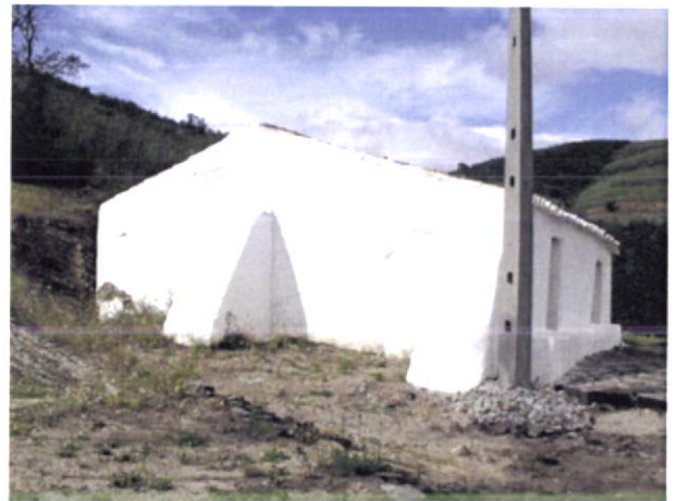
Fig.181-Exemplo de contrafortes laterais em Casas de Odelouca.
