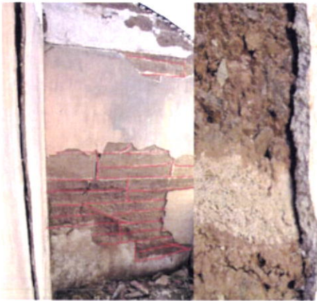
Fig.156-Exemplo de aplicação de camada de argamassa a meia altura de cada taipalada, numa habitação de dois pisos. Pomba.
