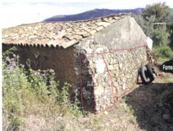
Fig.183-Exemplo de reforço de parede com contrafortes e enchimento com alvenaria de pedra. Corte da Pomba.
