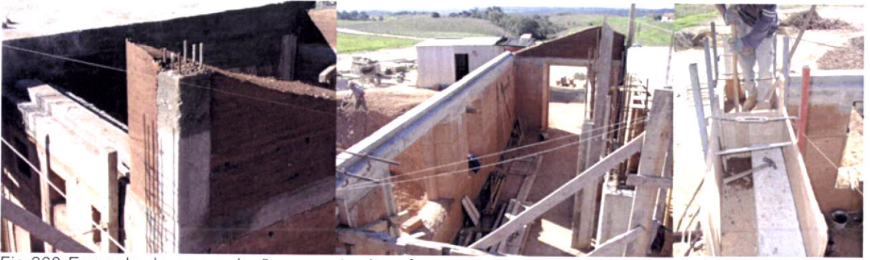
Fig.260-Exemplo de uma solução corrente de reforço estrutural com construção de uma estrutura de betão armado com taipa como enchimento estrutural. Odemira, Troviscais 28/76/2005.
