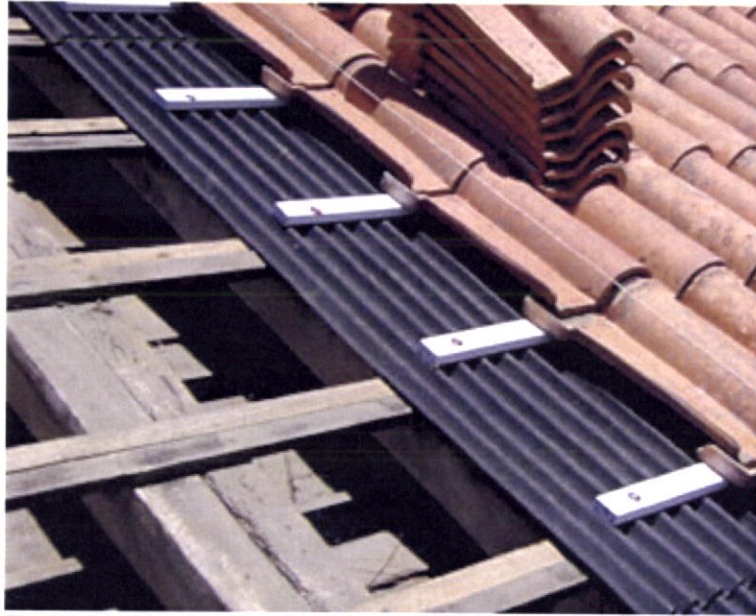
Fig.269-Exemplo de aplicação de subtelha em cartão asfáltico. Fonte: ONDULINE. Fotos [ http://www.onduline.pt/fotos.htm ] Arquivo (3/9/2006)
