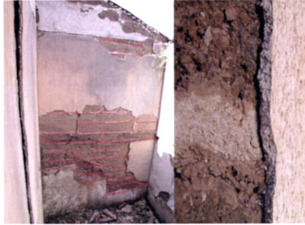
Fig.113-Exemplo de juntas de grande espessura (+/-5cm) em reforço estrutural de edifícios de dois pisos. Corte da Pomba.
