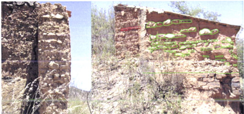
Fig.129-Pormenor do uso de pedras de grandes dimensões para enchimento das taipaladas. Tojeiro.
