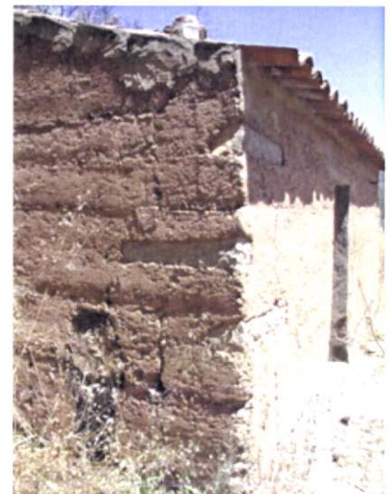
Fig.163-A utilização de pedras de cantaria numa construção de apoio agrícola na Panasqueira constituiu um exemplo único de entre todos os observados. Panasqueira.
