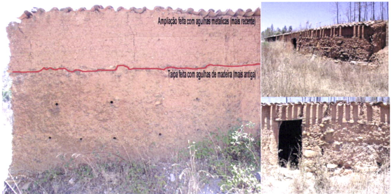
Fig.109-Pormenor de duas fases de construção com recurso a agulhas de madeira na parte mais antiga (abaixo) e agulhas de ferro na ampliação (topo). Foz do Farelo, Monchique.
