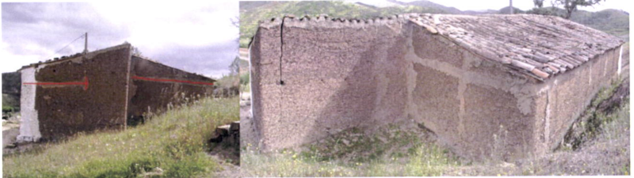
Fig.175-Pormenor de uma aplicação pontual e de envolvimento completo de casa de habitação principal. Casas de Odelouca.
