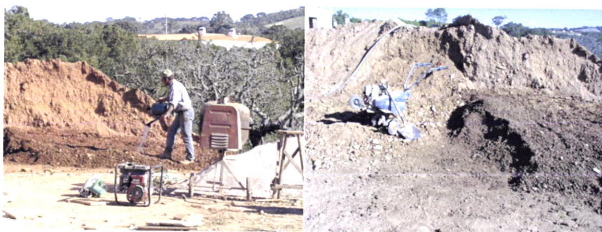
Fig.100-Preparação da terra para uma obra em Troviscais, Odemira. Rega por regador, destorroamento e mistura mecânica com moto cultivador.
