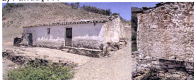
Fig.67-Pormenor de acilho em pedra numa construção na Foz do Açor, com aproximadamente 70cm de altura.
