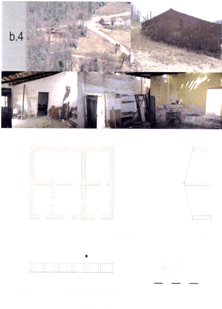
Fig.49-Várzea da Eira, casa em taipa, alvenaria de pedra e tabique. Planta, alçados e fotografias do exterior e interior.
