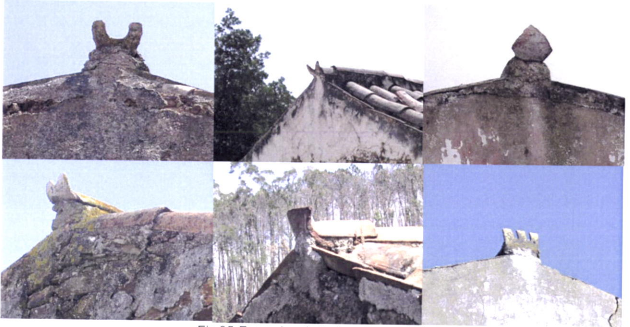
Fig.95-Exemplos de "rabos de pomba".
