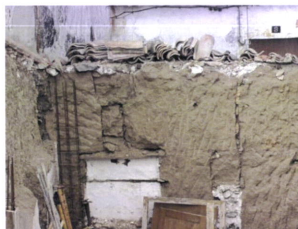
Fig.31-Pormenor de construção em taipa. É aqui uma prática corrente de construção, o recurso à edificação com parede meia, assim designada por as paredes contíguas serem comum e pertencentes aos donos das duas casas contíguas. Monchique.
