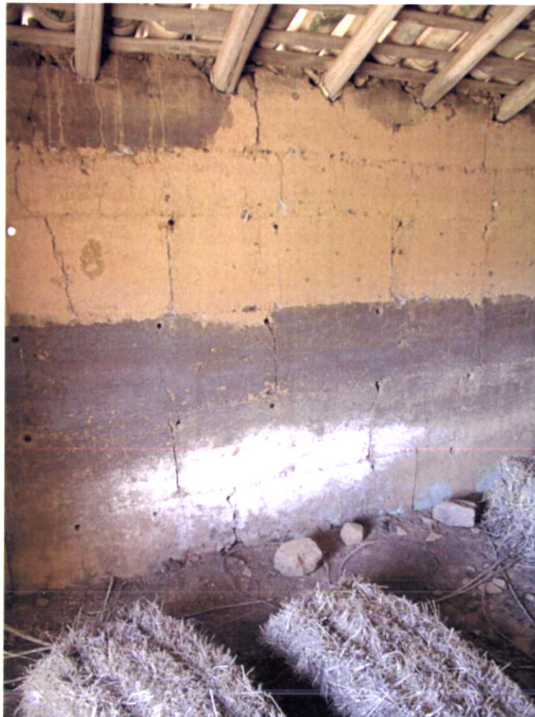
Fig.231- Exemplos de eflorescências salinas por acção da urina animal.
