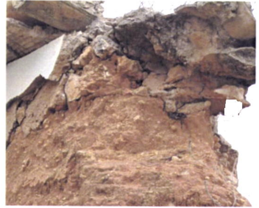
Fig.179-Reforço com cabo de aço, em topo de parede exterior. Albufeira.
