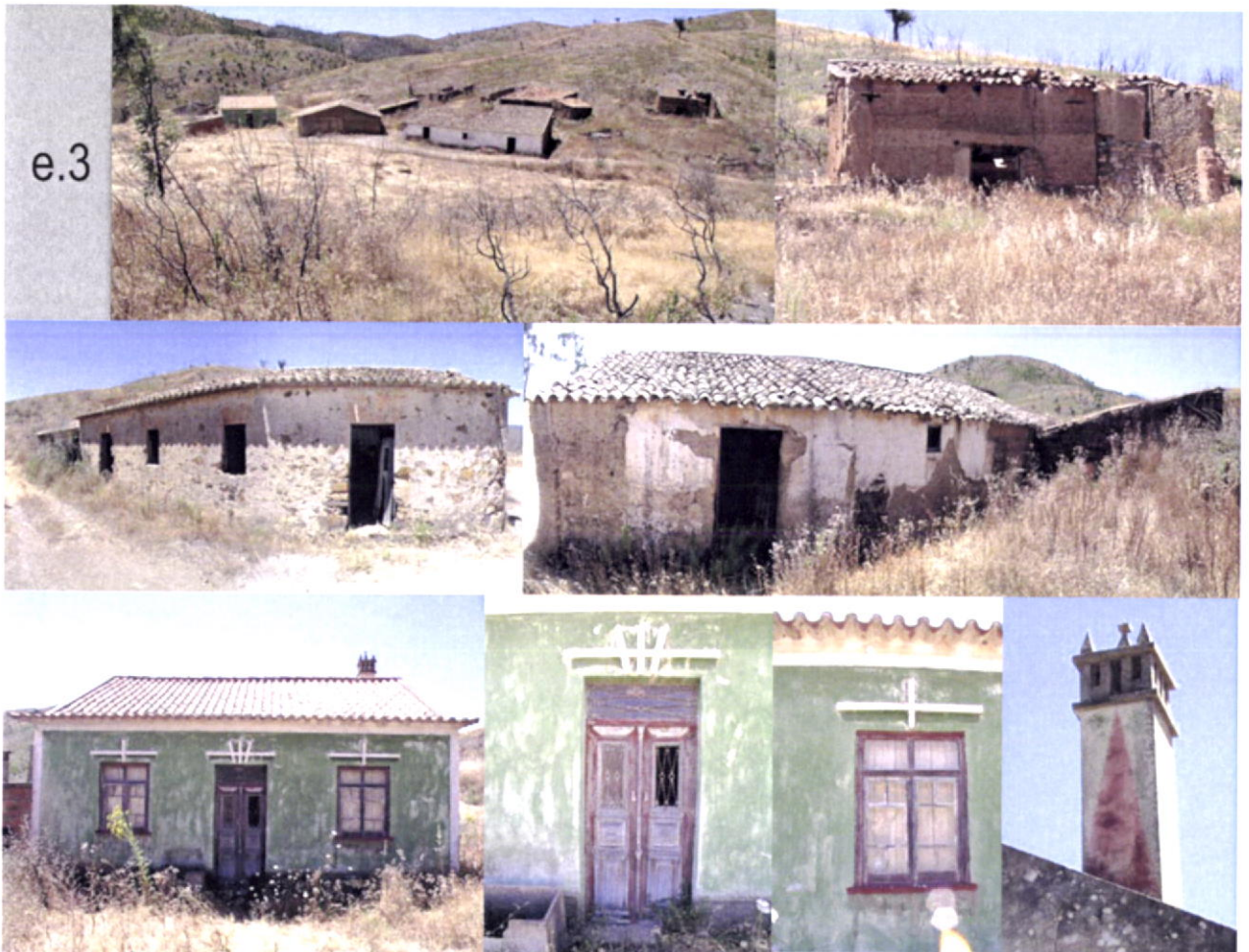
Fig.57-Tojeiro, monte de grande dimensão composto por casas dispersas em taipa, alvenaria de pedra e alvenaria de tijolo. Fotografias do exterior.
