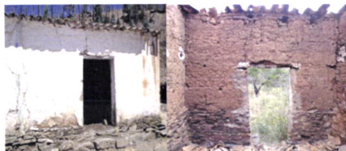
Fig.68-Diferença entre altura do acilho de uma construção da Foz do Açor (50cm) e da Foz do Besteiro (80cm).
