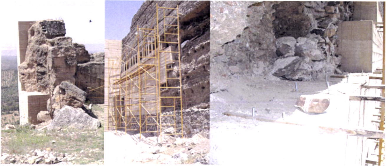
Fig.251-Exemplo da consolidação e tapamento de lacunas de grande dimensão, por execução de revestimento da taipa original por camada de revestimento também em taipa, nas muralhas do castelo de La Reina, Espanha 10/6/2003.
