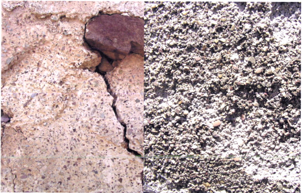
Fig.80-Dois exemplos de rebocos de cal e cascalho da ribeira.
