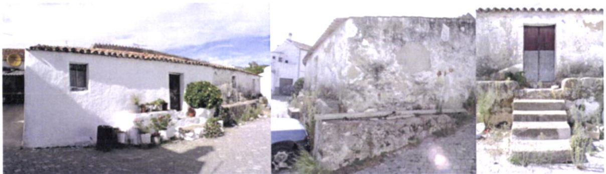
Fig.186-Poial de reforço de base de construção em Casais. Observe-se que a altura do poial é manifestamente desadequada para uma utilização como banco.
