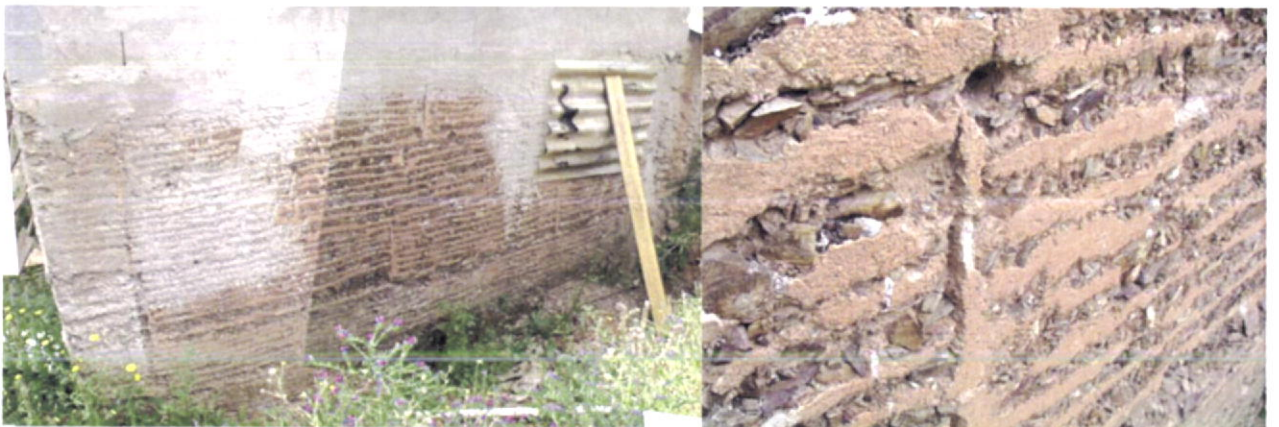
Fig.112-Constituindo exemplo único, foi observado no Monchicão, a aplicação de junta sobre cada camada de terra compactada.
