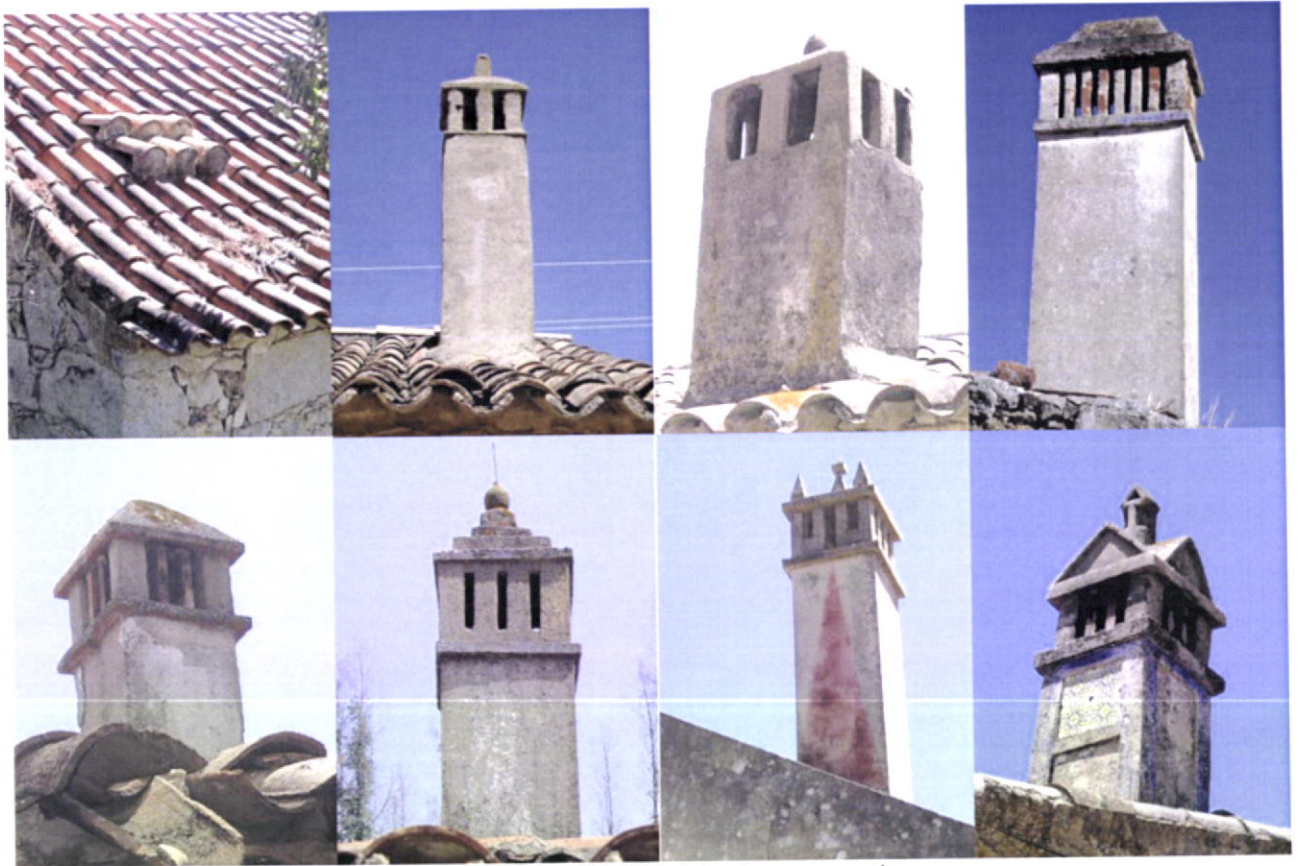
Fig.94-Exemplos de chaminés de casa rurais.
