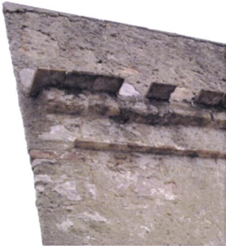
Fig.123-Pormenores de régua em tijoleira de barro, deixada em platibanda. Estói.
