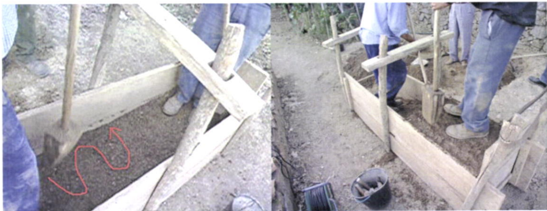
Fig.106-Pormenor do desenvolvimento da compactação no centro do taipal. Monchique.
