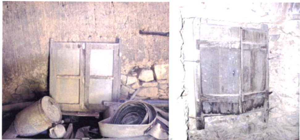
Fig.87-Comparação entre duas carpintaria de janela, uma de modelo com quatro vidros e outra inteiramente em madeira.
