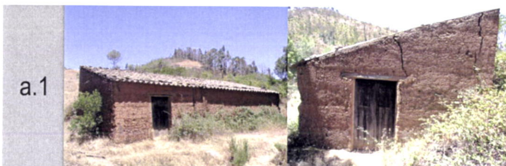
Fig.44-Foz do Carvalho, construção de apoio à actividade agrícola em taipa. Fotografias do exterior.
