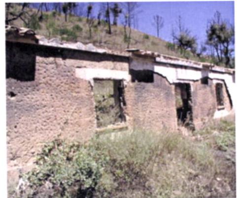
Fig.72-Pormenor da picagem da superfície de uma parede de taipa como preparação para rebocar.
