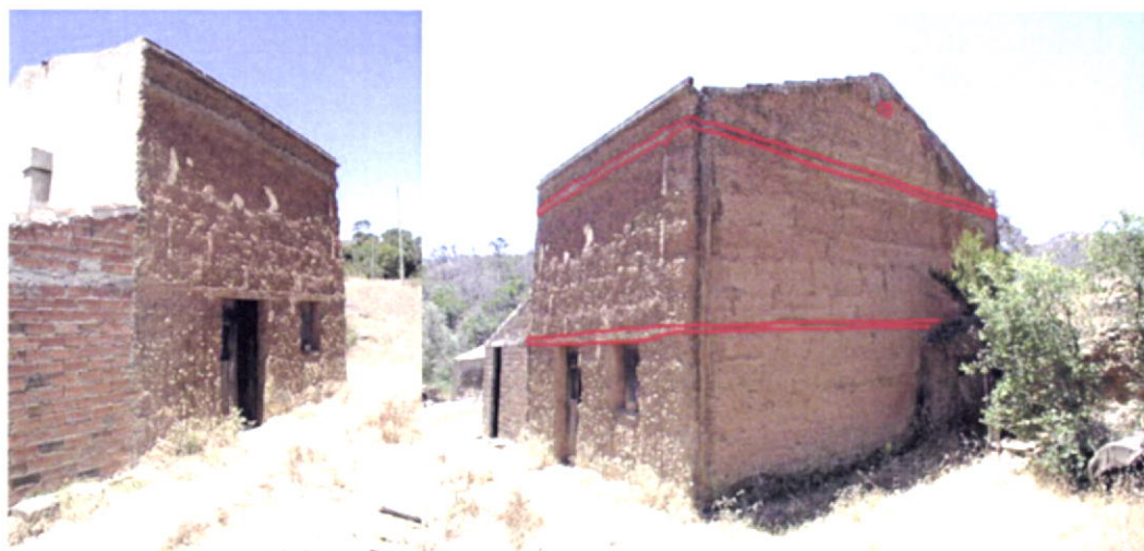
Fig.168-Pormenor de reforço de edificação de dois pisos, com vigas em paredes-mestras e esticador. Três figos
