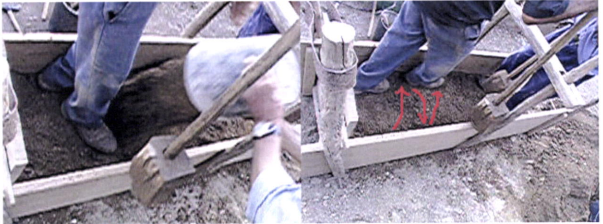
Fig.104-Cada nova camada de terra é cuidadosamente espalhada com os pé, de modo a obter uma espessura uniforme e afastar as pedras da face dos taipais. Monchique.
