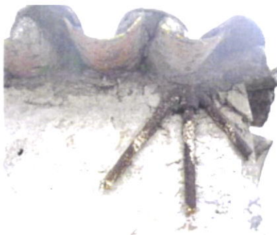
Fig.150-Pormenor de Ferrolho à vista. Marmeleite.
