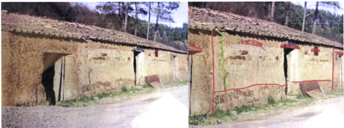
Fig.114-Pormenor de parede com vergas de madeira em vãos por abrir. Do lado esquerdo, apresenta-se esquematicamente a vermelho a estrutura das paredes e as vergas, e a verde a fissuração existente no cunhal. Corte da Pomba.
