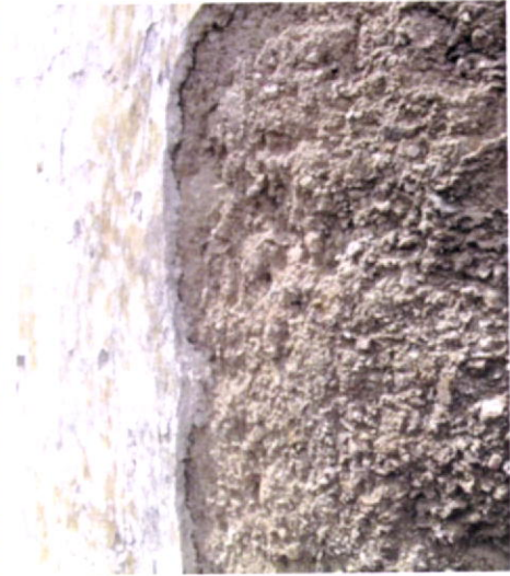
Fig.77-Os rebocos tradicionais são sempre de diminuta espessura.
