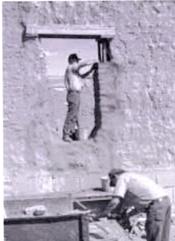
Fig.261 Exemplo de reabilitação de um vão.
