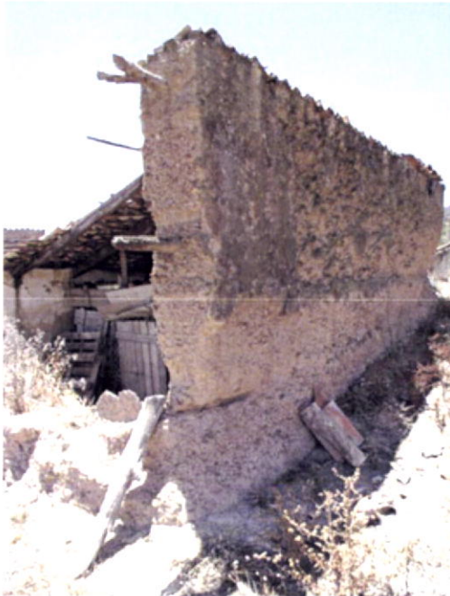
Fig.160-Pormenor de reforço de cunhais com troncos de madeira. As peças utilizadas têm 1m de comprimento em média. Três figos, Casa de Sr. Manuel da Conceição Cristina.
