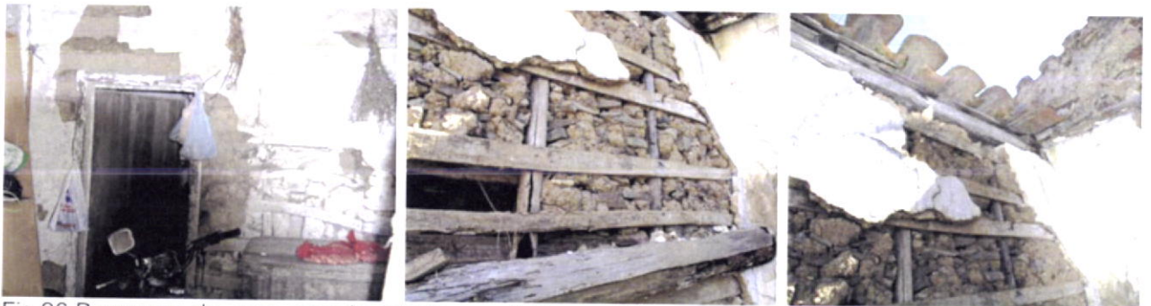
Fig.96-Pormenor de uma parede interior em tabique. Observe-se o travamento da estrutura vertical de madeira, por viga de topo. Padescas, Monchique.
