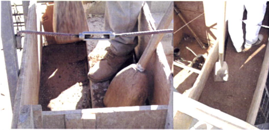
Fig.102-Pormenor dos dois tipos de malhos utilizados na realização da taipa em Troviscais, Odemira.
